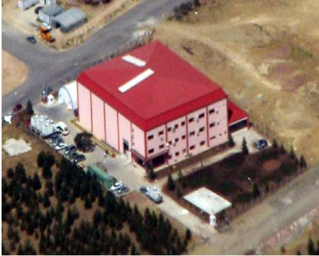
Resim 7.1. PGL binası [Olcay, 2007]
