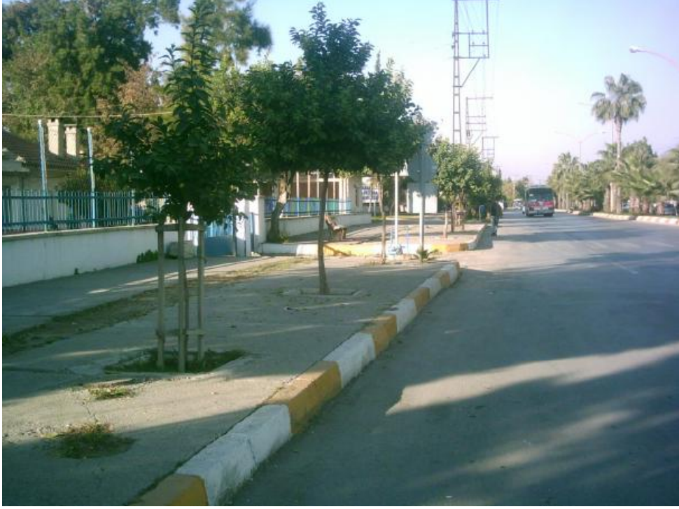
Şekil 3.10. Barış Bulvarı Mevcut Yaya Yollarının Bozuk Yüzey Kaplamaları
