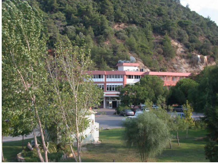
Şekil 4.52 İzmir’de Balçova Termal Tedavi Merkezi ve Oteli. Şehir merkezine yakın olmasına karşın doğa içerisinde konumlanabilmiştir.
