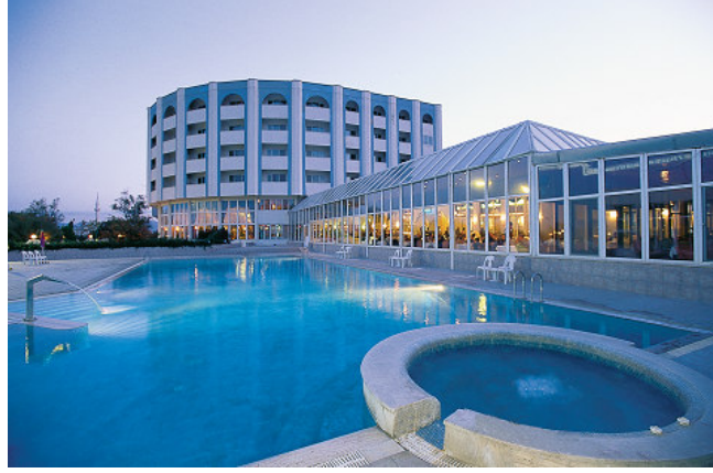
Şekil 4.25 Afyon'da Oruçoğlu Thermal Otel. Açık sıcak termal havuz
