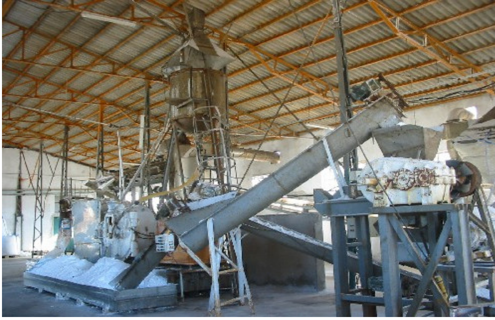
Şekil 6.15 Tuzla kaplıcası ana kaynağı üzerindeki tuz fabrikasının içinden görünüm
