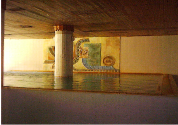
Şekil 4.61 İzmir’de Balçova Termal Tedavi Merkezi. Yeni düzenlemede bazı çözümsüzlükler oluşmuştur. Termal havuz kolonu içine almıştır.
