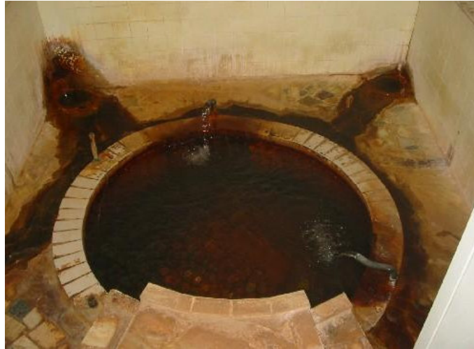
Şekil 6.24 Küçükçetmi kaplıcası havuzu
