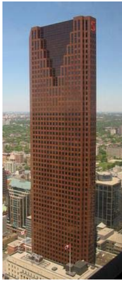
Şekil 4.82 Scotia Plaza Binası (Toronto) 275 m., 65 katlı
