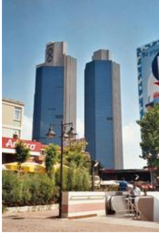
Şekil 5.41 Sabancı Center Görünüşü
