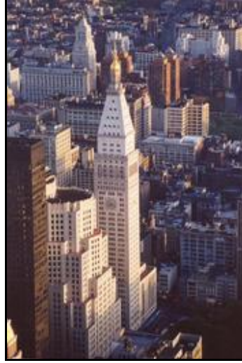
Şekil 2.7 Equitable Life Insurance Company Binası (New York)
