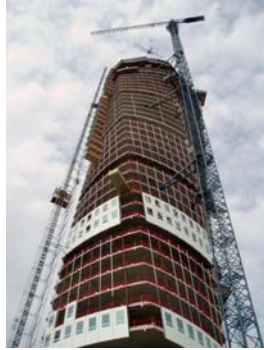
Şekil 5.28 Turning Torso'nun İnşaat Aşaması
