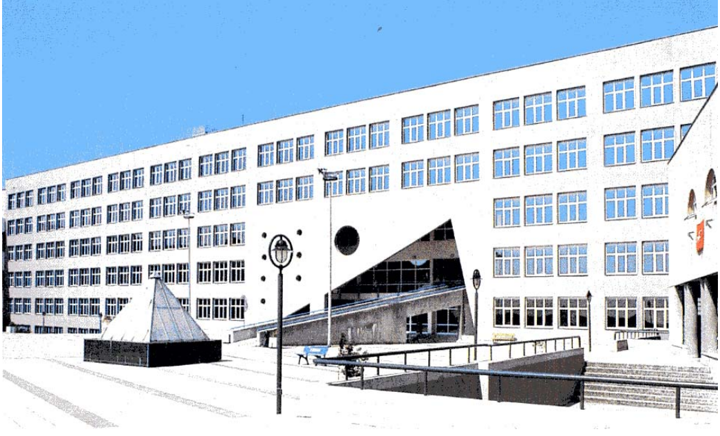
Şekil 4.93 Darüşşafaka Lisesi eğitim bloğu girişi(Yapı, 1999, s.82).
