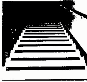
Şekil 4.62Basamağa yerleştirilen kaymayı engelleyici bant (Holmes, 1996, s.48;Leibrock, 1999, s.16).
