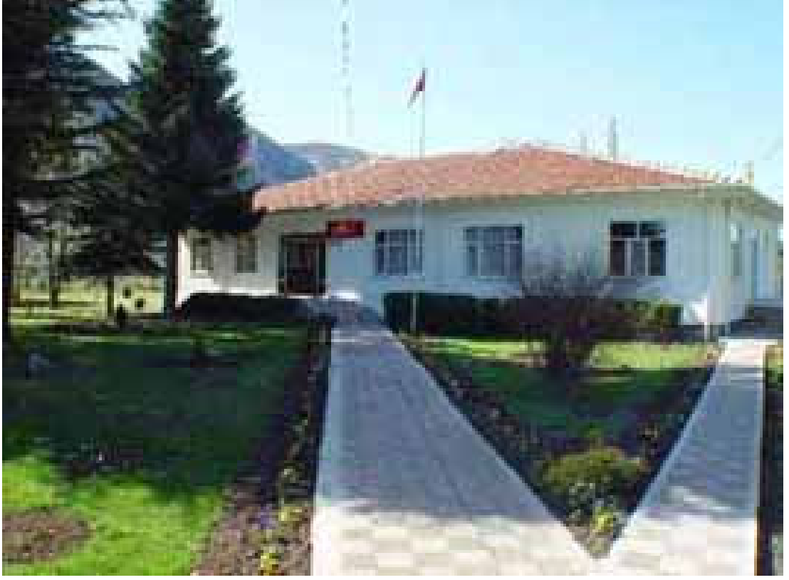
Şekil 3.6. Egridir Orman Fidanlık Mühendisliği merkez binası
