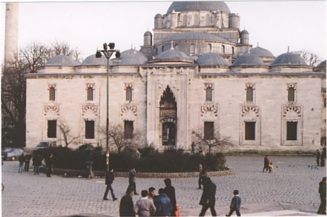
Fotoğraf 2 : Saray Kapısının Bulunduğu Cephe
