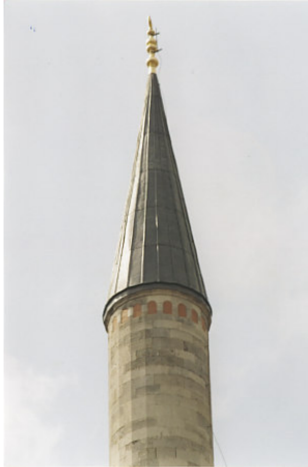
Fotoğraf 78 : Minare Kûlahı' (Batı Minare)
