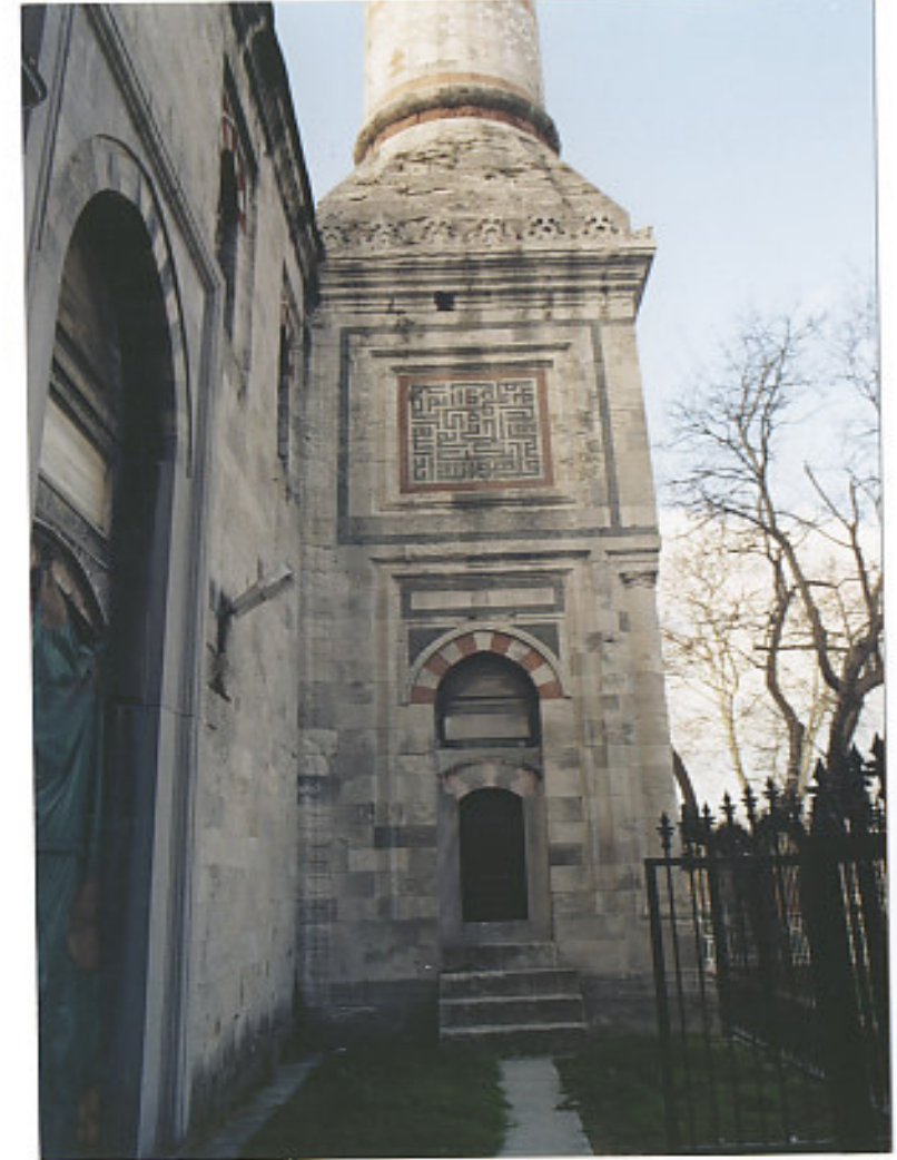
Fotoğraf 64 : Minare Kapı Cephesi (Batı Minare)
