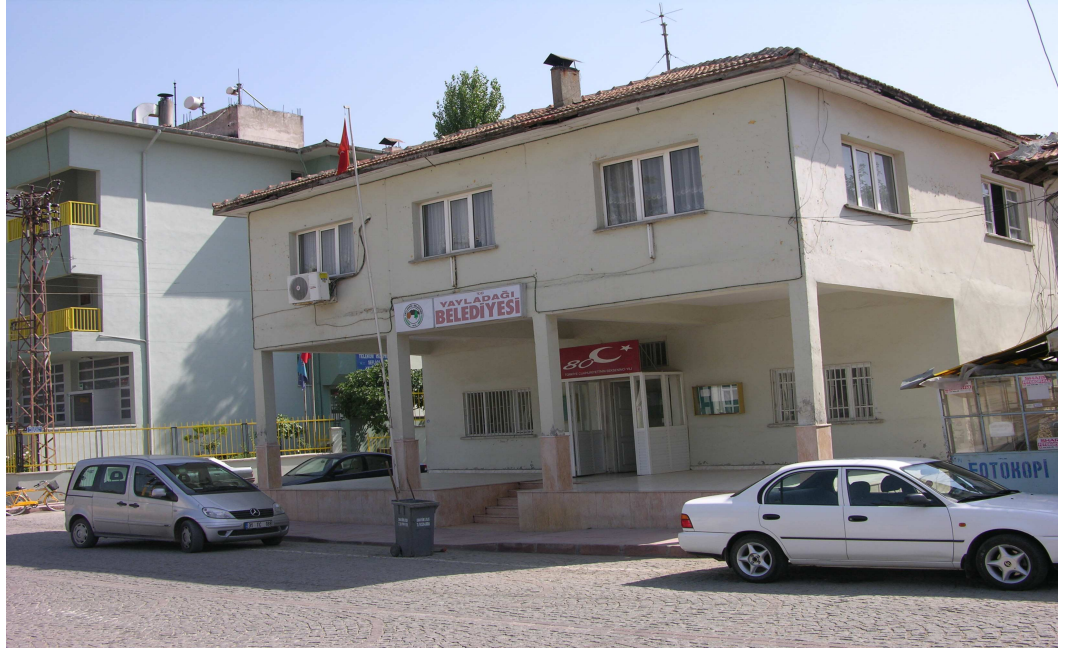
Fotoğraf 50: Yayladağı Belediye Binası
