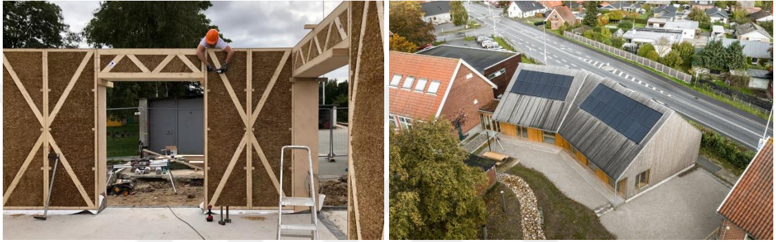
Şekil 3.4. Feldballe School A) samandan oluşan sıkıştırılmış panel sistemi (ArchDaily, 2023a) B) çatıda yer alan güneş panelleri (ArchDaily, 2023a)
