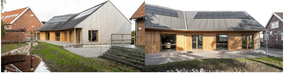
Şekil 3.3. Feldballe School A) yan görünüş (ArchDaily, 2023a) B) ön görünüş (ArchDaily, 2023a)
