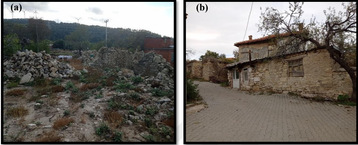
Fotoğraf 27. Çınarlı köyünde yıkılmış bir taş yapı (a) ve Çınarlı köyünde geleneksel meskenlere bir örnek (b)
