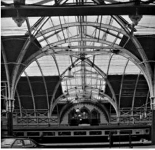
Resim 3.3. Brunel ve Digby'nin Paddington İstasyonu
