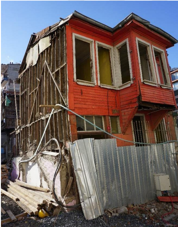
Şekil 4. 32 1890 ada 45 parsel ve 2287 ada 25 parselde yer alan mail-i inhidam durumda yapı elemanlarında kopmalar olan yapılar
