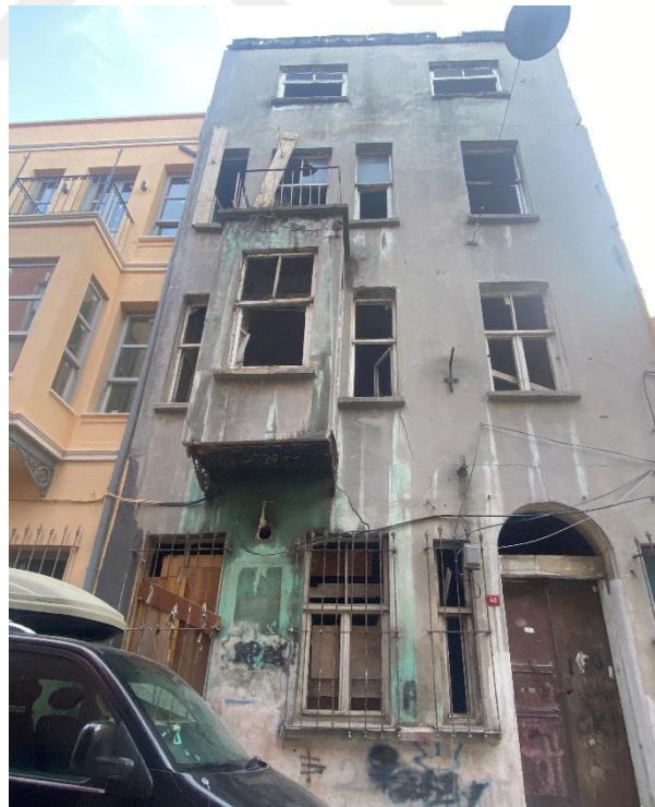
Şekil 4. 32 1890 ada 45 parsel ve 2287 ada 25 parselde yer alan mail-i inhidam durumda yapı elemanlarında kopmalar olan yapılar
