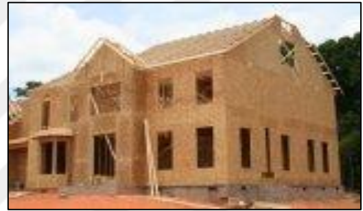
Fotoğraf 2.4 OSB Ev uygulaması (URL-4, 2023)
