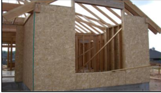
Fotoğraf 2.1 OSB Dış cephe kaplaması (Hızıroğlu, 2017)
