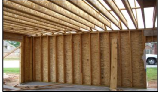
Fotoğraf 2.2 OSB I-Kiriş uygulaması (Hızıroğlu, 2017)
