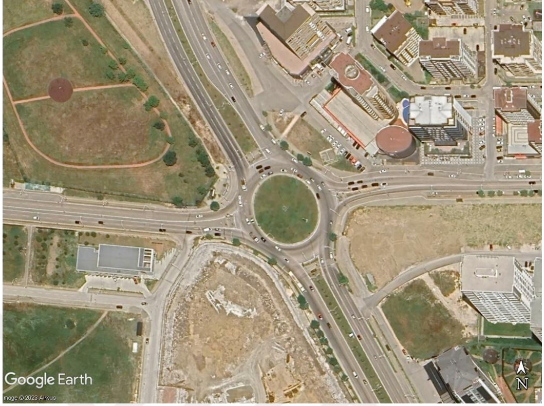
Şekil 4.8. Altınşehir Mah. Hipodrom Kavşağı uydu görüntüsü
