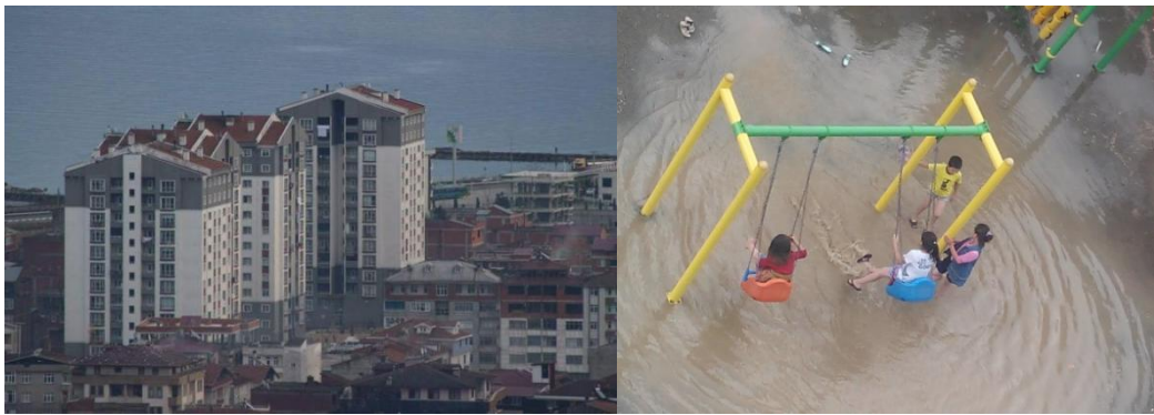
Şekil 5.41 TOKİ 1. etap konutları (Trabzon Araklı TOKİ konutları, 2021)
