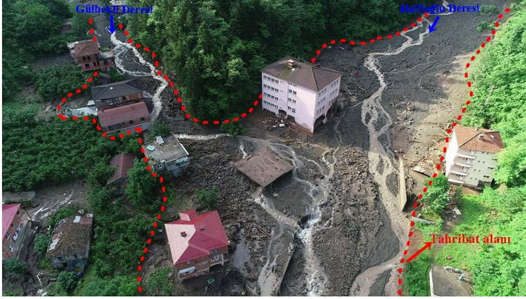
Şekil 5.34 Çamlıktepe Mahallesi dere yatağı ve akarsu birleşim noktasındaki yıkım (Işık vd, 2020)
