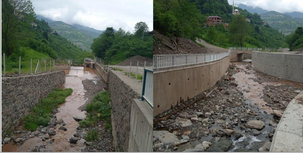
Şekil 5.25 HES ve alçak köprü
