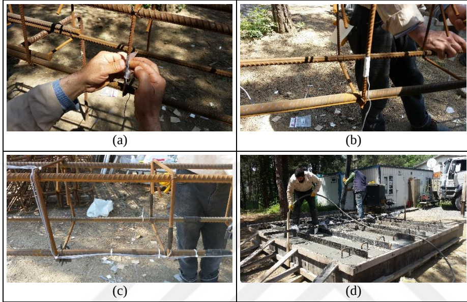
Şekil 3.5 : (a) Gerinim ölçerin yerleştirilmesi, (b) ilk kat yalıtımın yapılması, (c) ikinci ve üçüncü kat yalıtımın yapılması, (d) beton dökümü.
