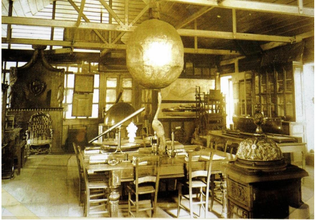
Şekil 3.33: Sağ alt köşede İstanbul Kasımpaşa Bahriye Kütüphanesinde kullanılmış kapağı seramik kaplamalı döküm soba görülmektedir. 1902-1904
