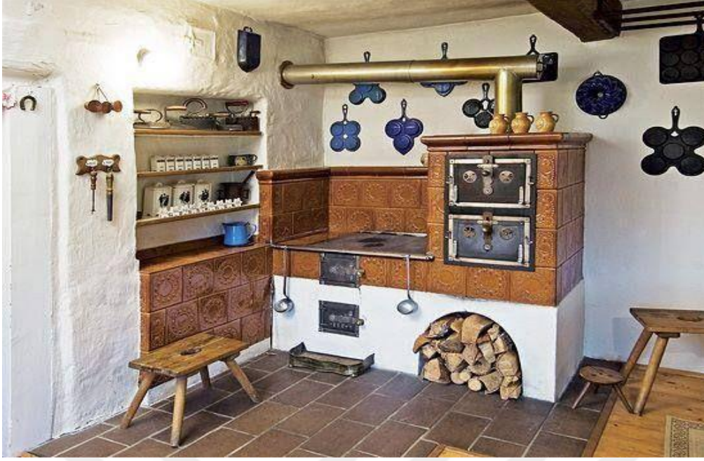
Şekil 3.18: 18. yüzyılda Orta Avrupa’da, ısınma ve yemek pişirme ihtiyacını bir arada karşılayan duvardan öne odanın içine doğru çekilmiş fırınlı sabit bir yemek sobası örneği
