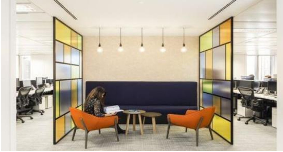
Şekil 4.1. Monte edilerek yapılmış sabit bölücü eleman örneği
