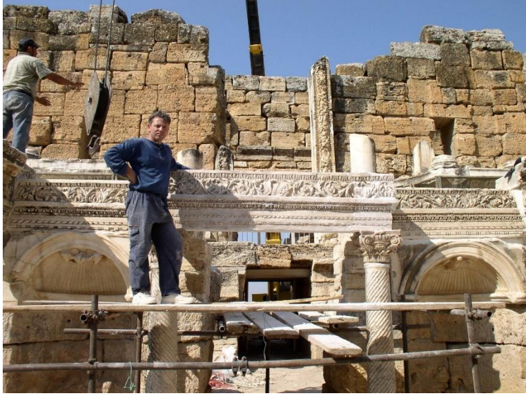
Resim 151. Hierapolis antik kenti restorasyon çalışmaları (M. Cura)
