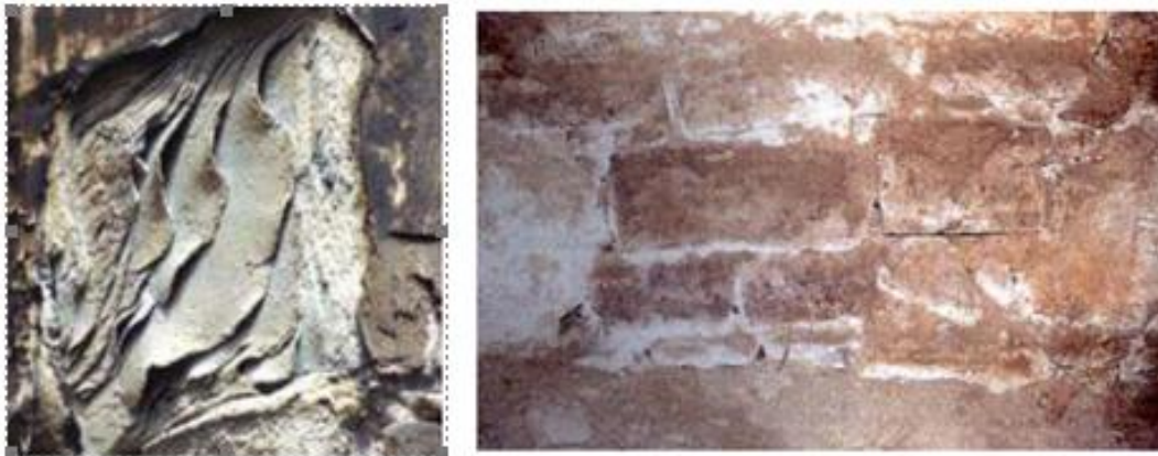
Resim 99. Yapraklaşma ve tuzlanma (Hasbay ve Hattap 2017: Şekil. 15 ve 12)
