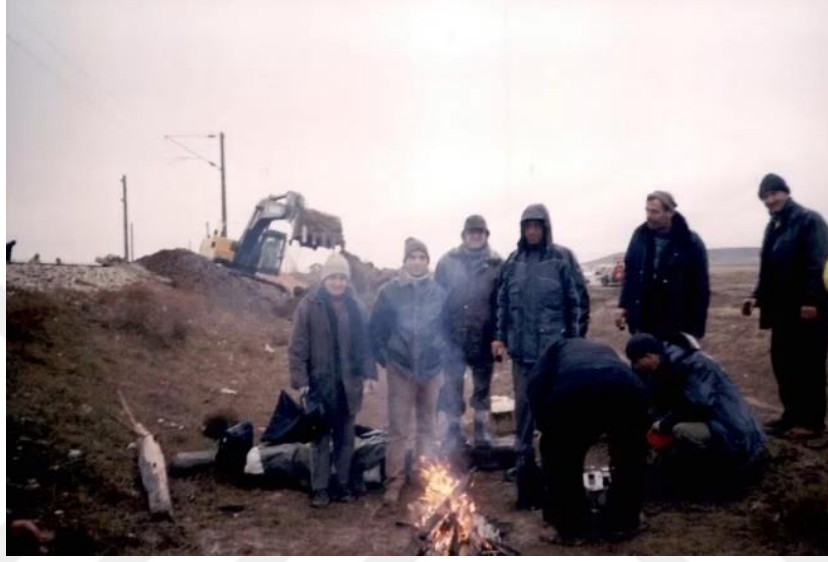
Görsel 3.6. TCDD Yol Hizmetleri Bölümü Çalışanlarının Yol Yapım Çalışması
