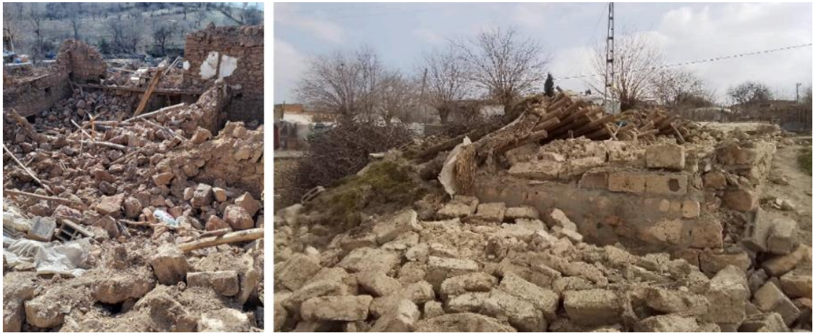
Şekil 2.1. Tamamen göçen yığma yapı örnekleri
