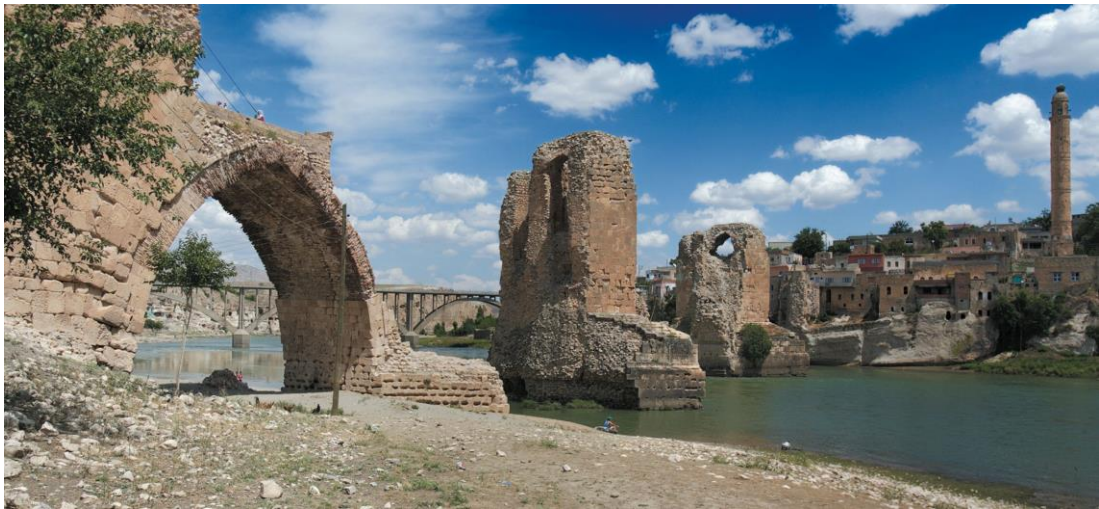
Şekil 4.9 Tarihi Artuklu köprü ayakları ve modern köprü (Selçuklu Belediyesi, 2017)
