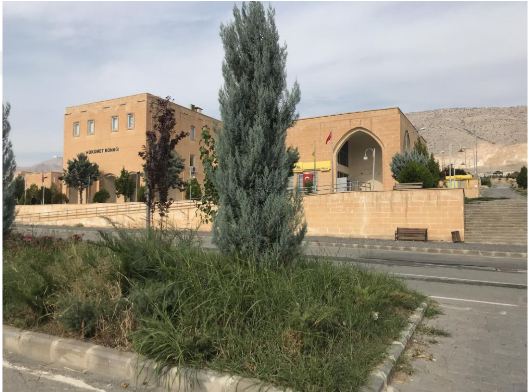
Şekil 4.39 Yeni Hasankeyf Hükümet Konağı ve PTT Binası (Kartal, 2023)
