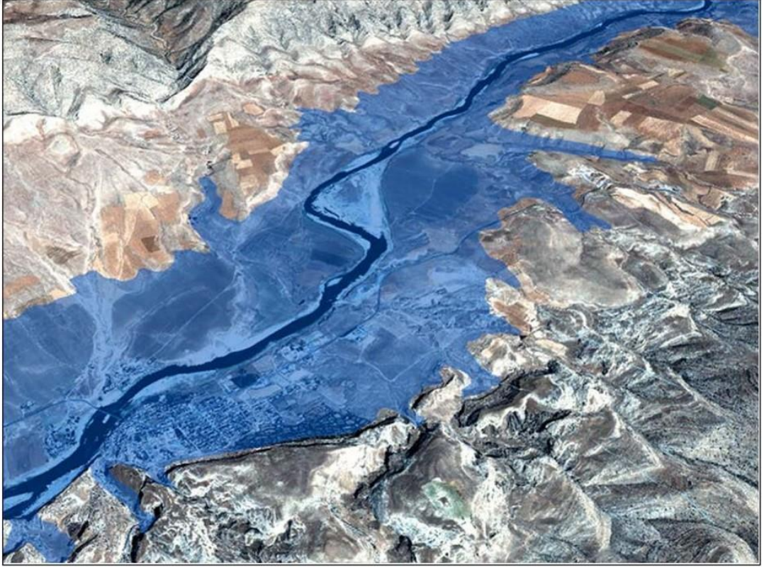
Şekil 3.44 Ilısu Barajı'nın etkilediği Hasankeyf yerleşimi (Uluçam, 2017:10)
