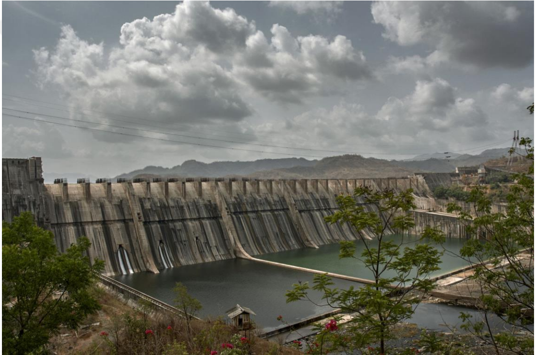
Şekil 3.19 Sardar Sarovar Barajı (The Telegraph, 2019).
