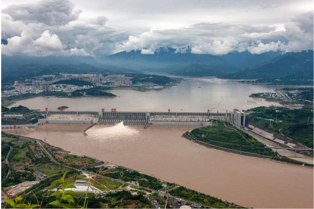
Şekil 3.21 Üç Boğaz Barajı görünüm (Donanım Haber, 2023)
