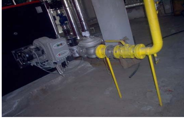
Şekil 4.13 Kazan gaz besleme borularının desteklenmesi
