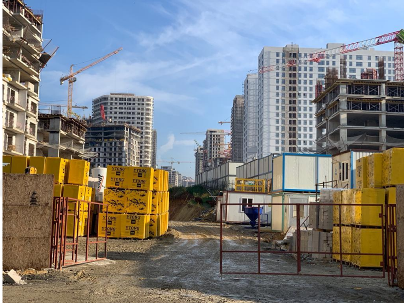
Foto 43: Fikirtepe 1. Etapta Yapımı Devam Eden İnşaat Çalışmaları (2023)
