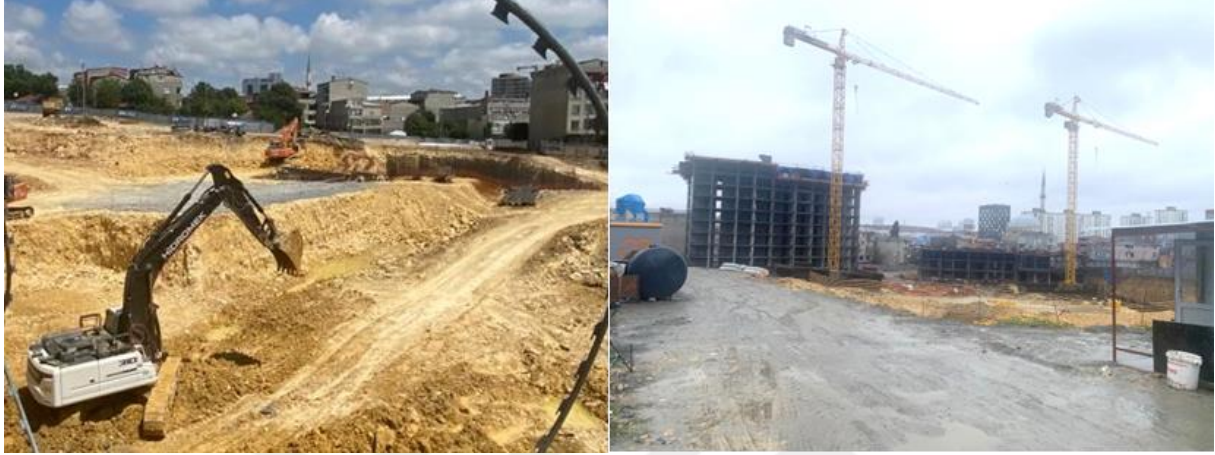
Foto 53: Köyiçi Mevkii Şehirsel Dönüşüm Projesi 1. Etapta Devam Eden İnşaat Faaliyetleri (2023)
