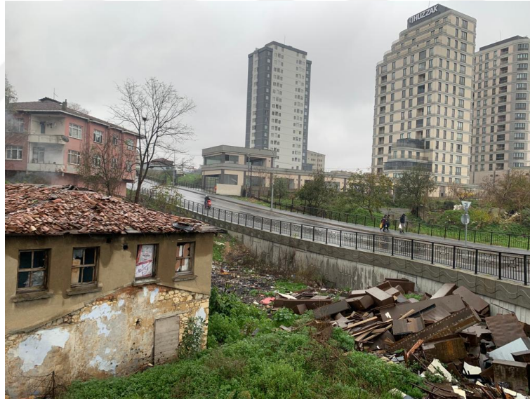
Foto 23: İkitelli’de Eski ve Yeni Yapılar (2023)
