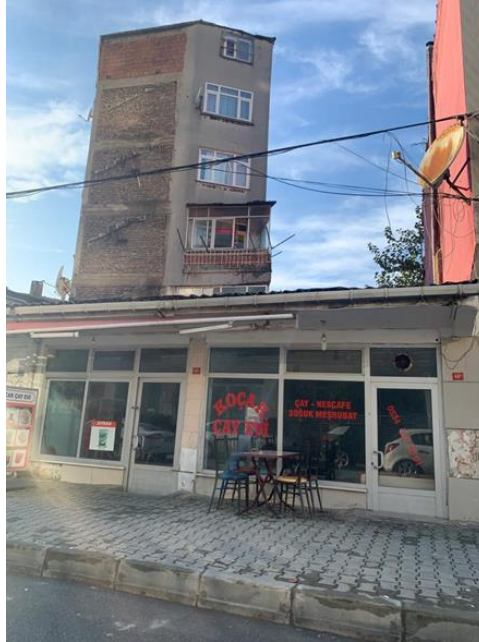
Foto 12: Fikirtepe’de Tek Katlı ve Çok Katlı Eski Yapılar (2023)
