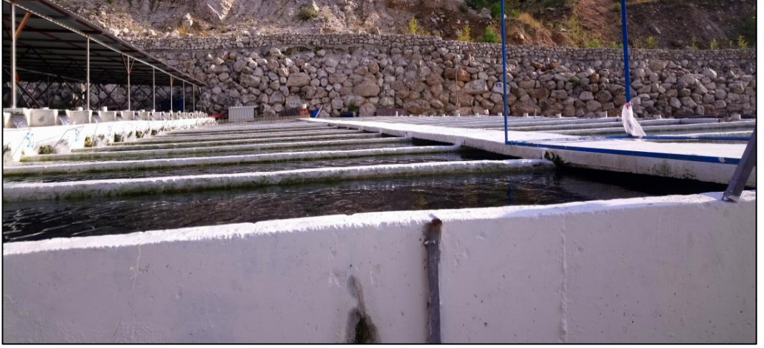
Şekil 4.24. Havuzlara taşkın, heyelan, erozyon etkilerini önlemek için inşa edilen koruyucu istinat duvarları, Ayhan Alp alabalık tesisi (orijinal)
