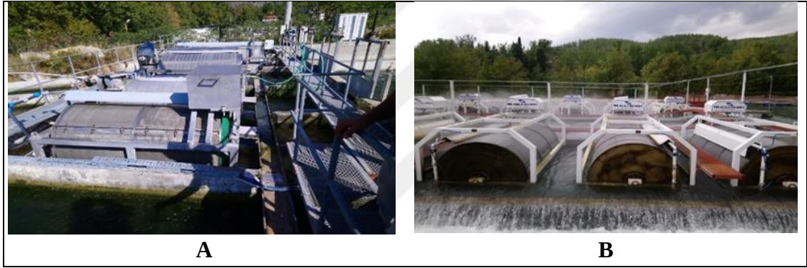
Şekil 4.19. Tambur filtreler. A) Enka su ürünleri Sahilceylan/Muğla, B) Gümüşdoğ a su ürünleri Seydikemer/Muğla
