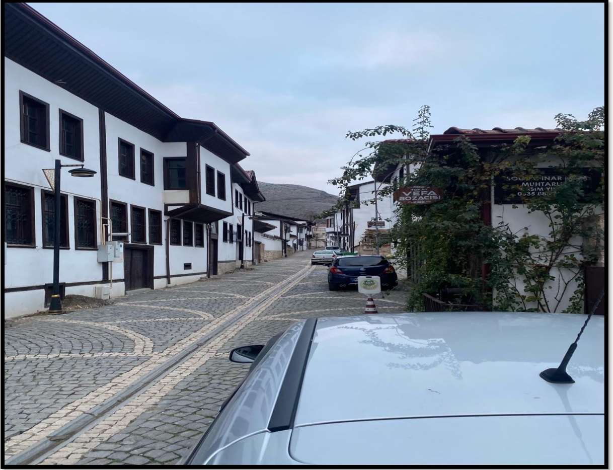
Şekil 4. 14. Bey Sokağı Konut Cephesi Tek Çıkmalı ( Tuğba Nur YILMAZ Arşivi,2023)
