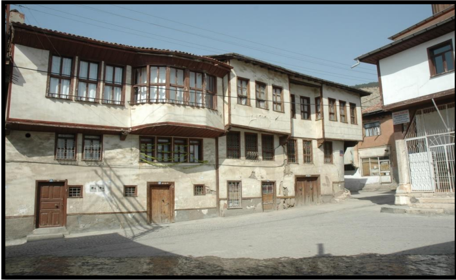
Şekil 4. 12. Bey Sokağı Konut Cephesi (Eski Hali) (Tokat Belediyesi Fotoğraf Arşivi)
