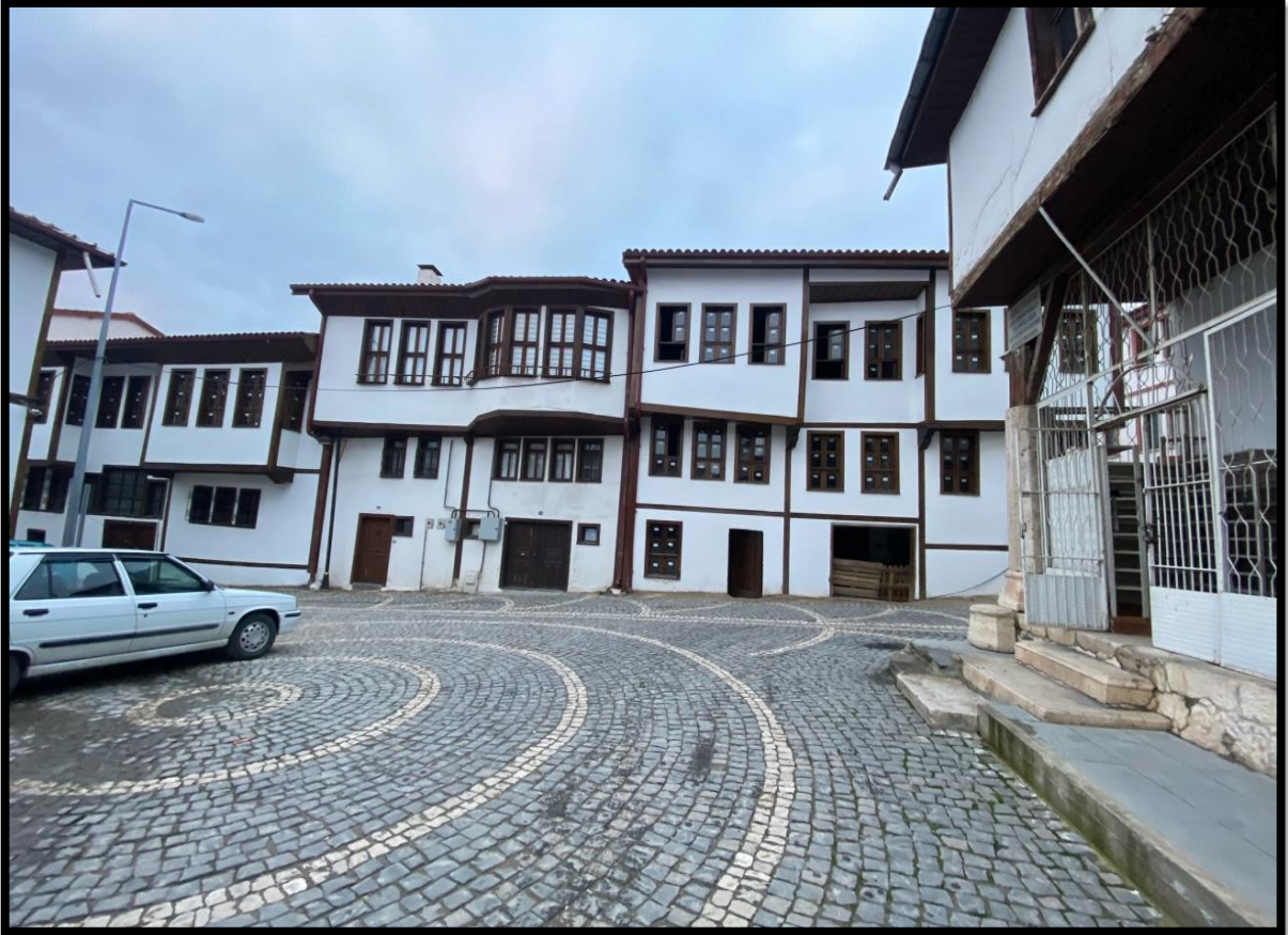
Şekil 4. 13. Bey Sokağı Konut Cephesi (Yeni Hali)( Tuğba Nur YILMAZ Arşivi,2023)
