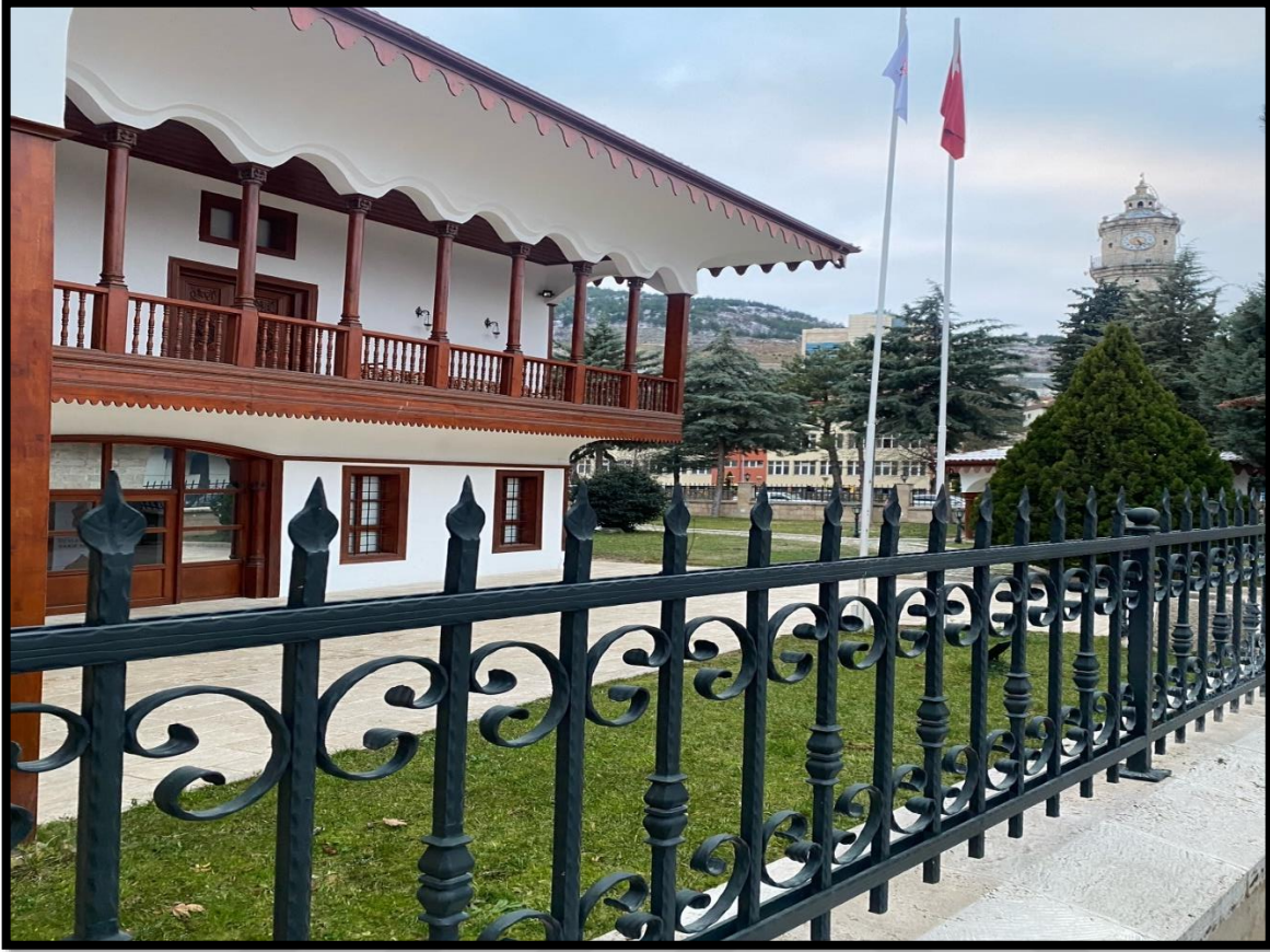
Şekil 3. 7. Mevlevihane Bahçeli Dış Cephe Görünümü(Tuğba Nur YILMAZ Arşiv,2023)
