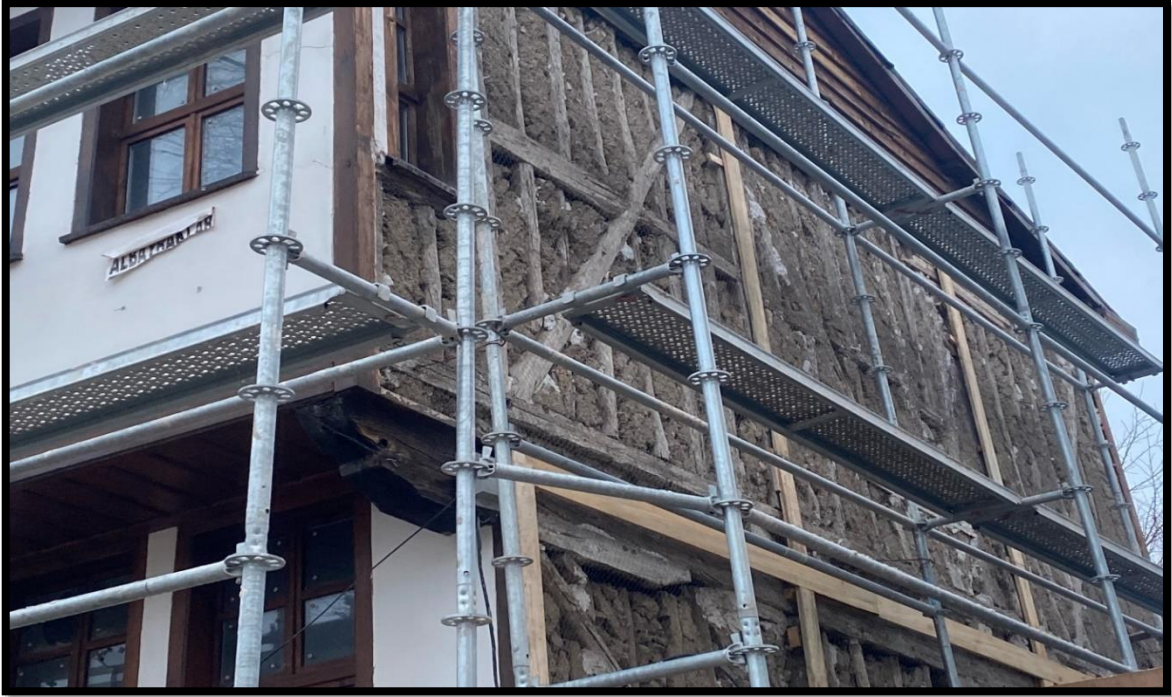
Şekil 3. 13. Tokat Geleneksel Evinin Yapımında Kullanılan Hımış Yapım Tekniği (Bey sokağı) (Tuğba Nur Yılmaz Arşiv, 2023)
