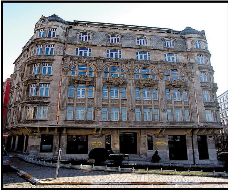
Şekil 2. 1. Art Deco Cephe Tasarımına Örnek Yapı (URL-1)
