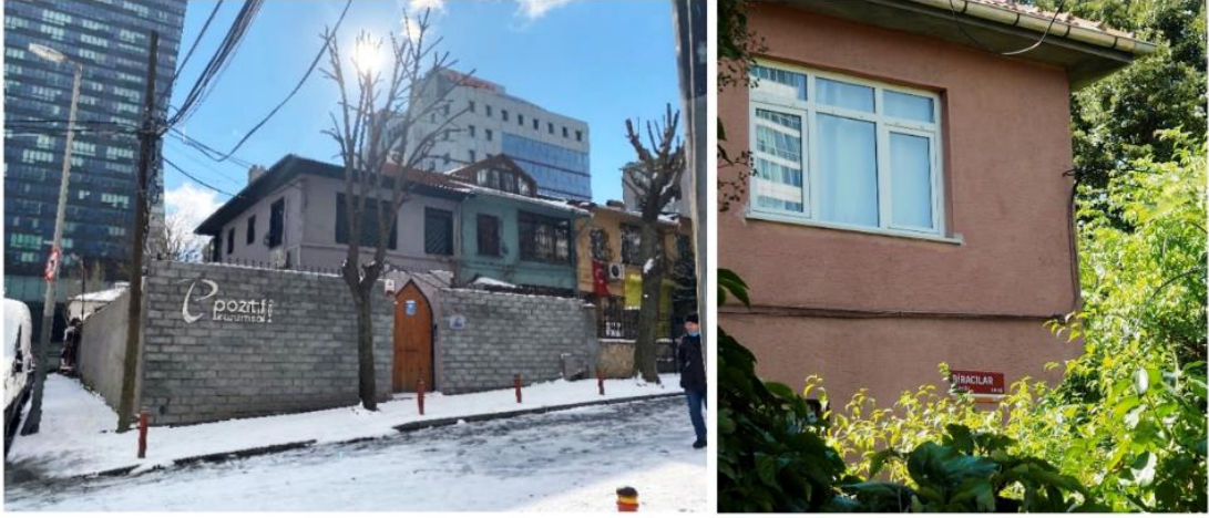
Görsel 4.25: Solda Kuştepe Bira Evleri'nin temelini atıldığı ve bira şişelerinin gömüldüğü parsel yerine inşa edilen ilk yapı, Mart 2022, sağda Biracılar Sokak 31 Ağustos 2020, Fotoğraflar: Eda Yiğit.
