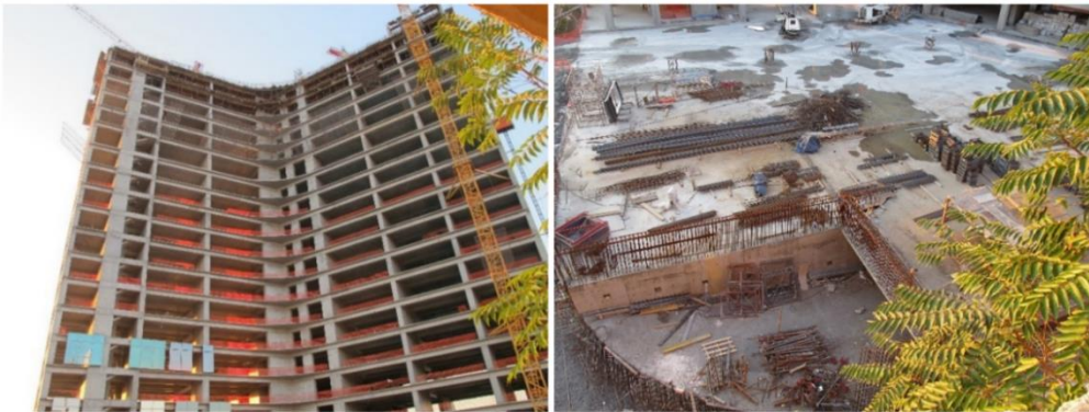
Görsel 6.7: Solda Hilton Oteli inşaatı bina cephesinde cam uygulama örneği ve sağda otel önü, Fotoğraf: Eda Yiğit.
