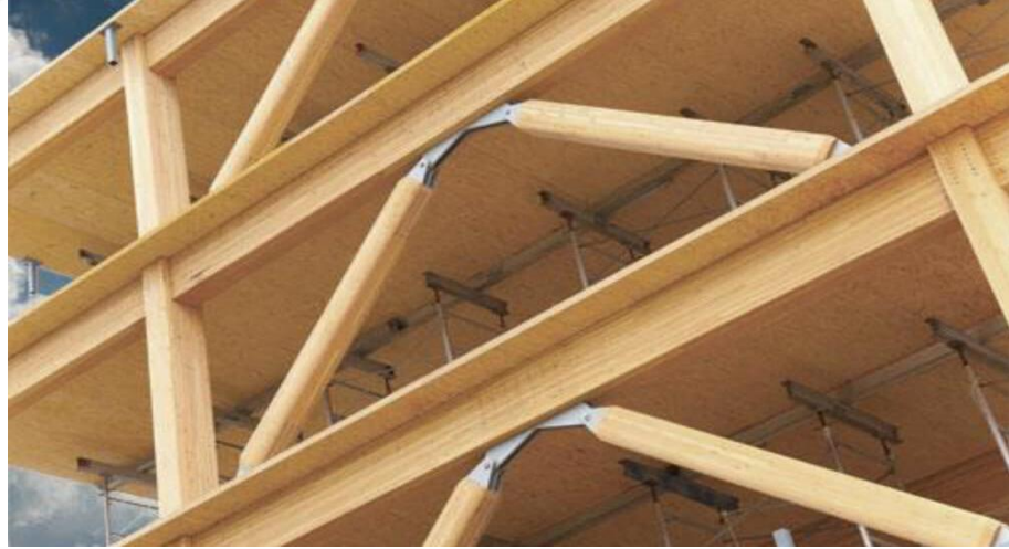
Şekil 3.18. Ahşap Yapıda Çapraz Destek Elemanı
