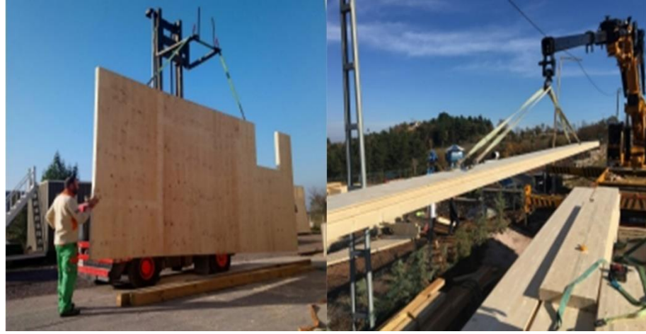
Şekil 3.10. Sol Resim CLT Panel Taşınması. Sağ Resim GLT Ürün Taşınması
