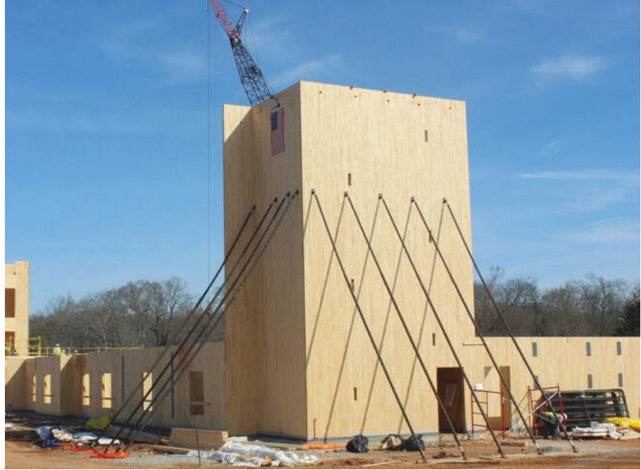
Şekil 3.13. CLT Panellerin Çelikle Desteklenmesi
