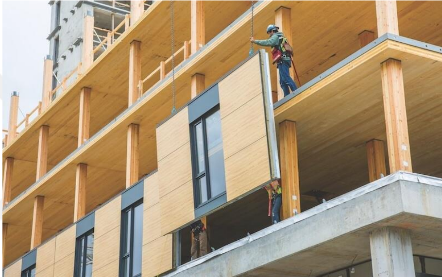
Şekil 3.19. Hibrit Yapıda Duvar Paneli Uygulaması
