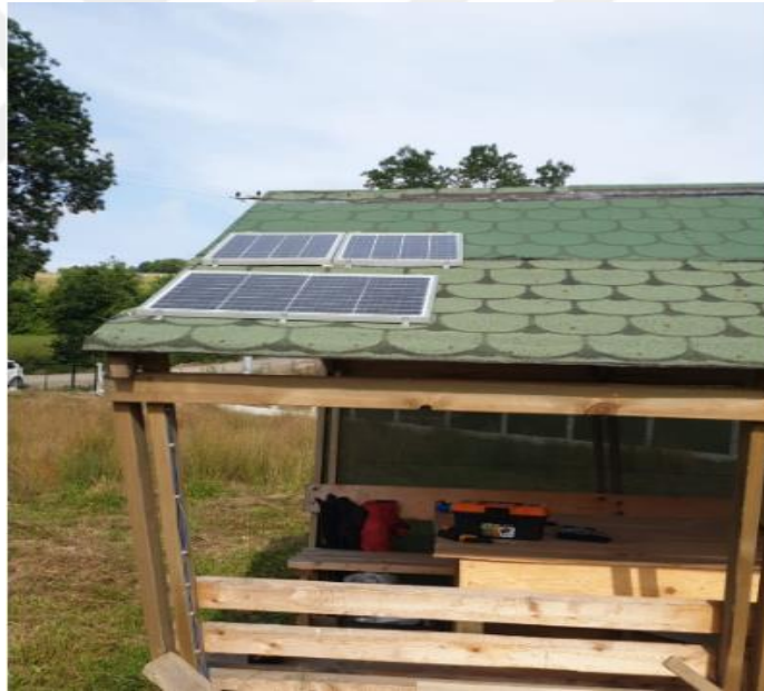
Şekil 6.2 Kamelyaya PV modül montajı
