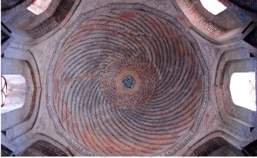
Görsel 23: Battalgazi Ulu Camii Kubbesi, Sırlı ve Sırsız Tuğla Dizilimi. Malatya https://www.mustafacambaz.com/details.php?image_id=28430 , (Erişim Tarihi: 03.03. 2023)
