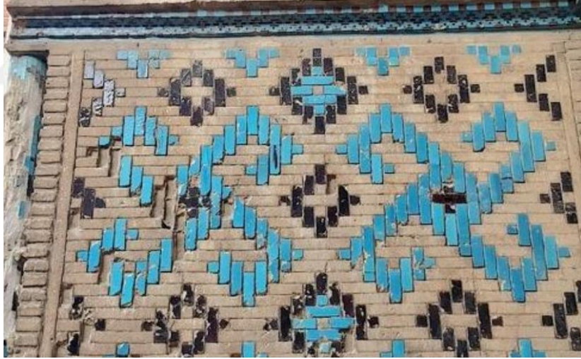
Görsel 35: Sırçalı Medrese, Sırlı Tuğla Tekniği (13. yy). Konya Kaynak: (Öney, 1976: 20)
