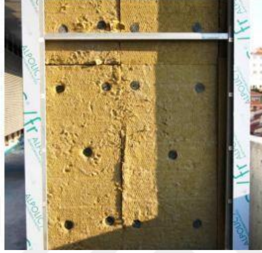
Şekil 5.4. Yarı esnek levha formunda taş yünü ısı yalıtım malzemesi (Türkmen, 2016)
