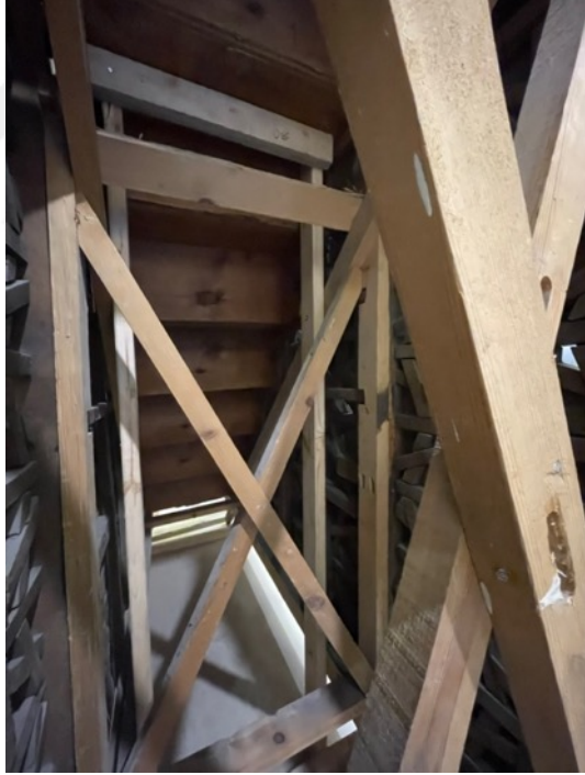
Resim 3.262. Taşkınpaşa Camii minberi eksen kayması ve gönye bozulma görüntüleri 2.
