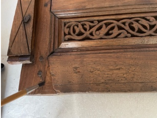
Resim 3.411. Taşkınpaşa Camii minberi kapı kanatları sağlamlaştırma işlem görüntüleri 7.
