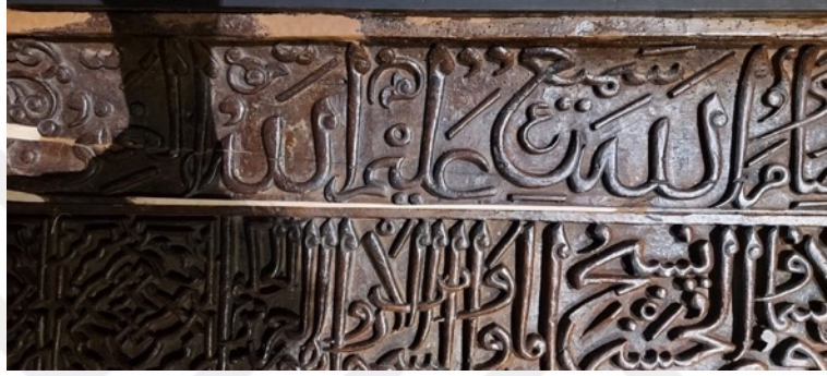
Resim 3.209. Taşkınpaşa Camii mihrabı müze teşhirde balsa ile tamamlama işlemi 3.
