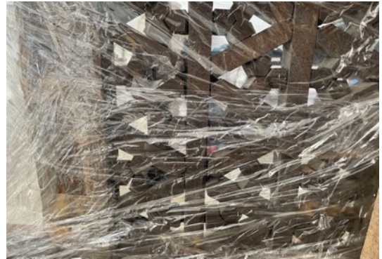
Resim 3.372. Taşkınpaşa Camii minberi köşk altı kısmı enjektör ile Xirein uygulama işlem görüntüleri.
