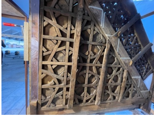
Resim 3.260. Taşkınpaşa Camii minberi birleşim yerlerinden ayrılma örnekleri 3.
