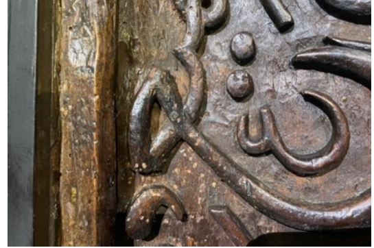
Resim 3.198. Taşkınpaşa Camii mihrabı müze teşhirde tamamlama ve böcek uçuş deliği doldurma işlem görüntüleri 4.
