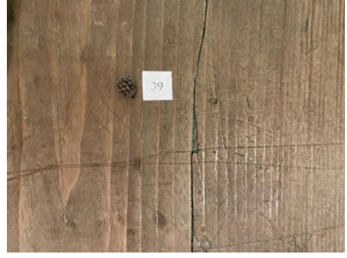
Resim 3.595. Gazanfer Ağa Camii vaaz kürsüsü rahle kısmında oluşan çatlama ve ayrılma örneği detayı.
