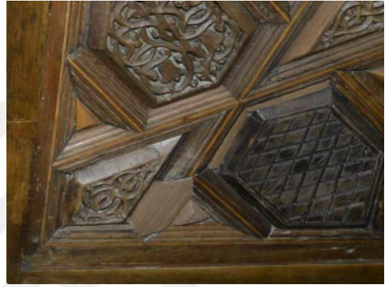
Resim 3.414. Taşkınpaşa Camii minberi kapı kanatları parça tamamlama işlem görüntüleri 3.
