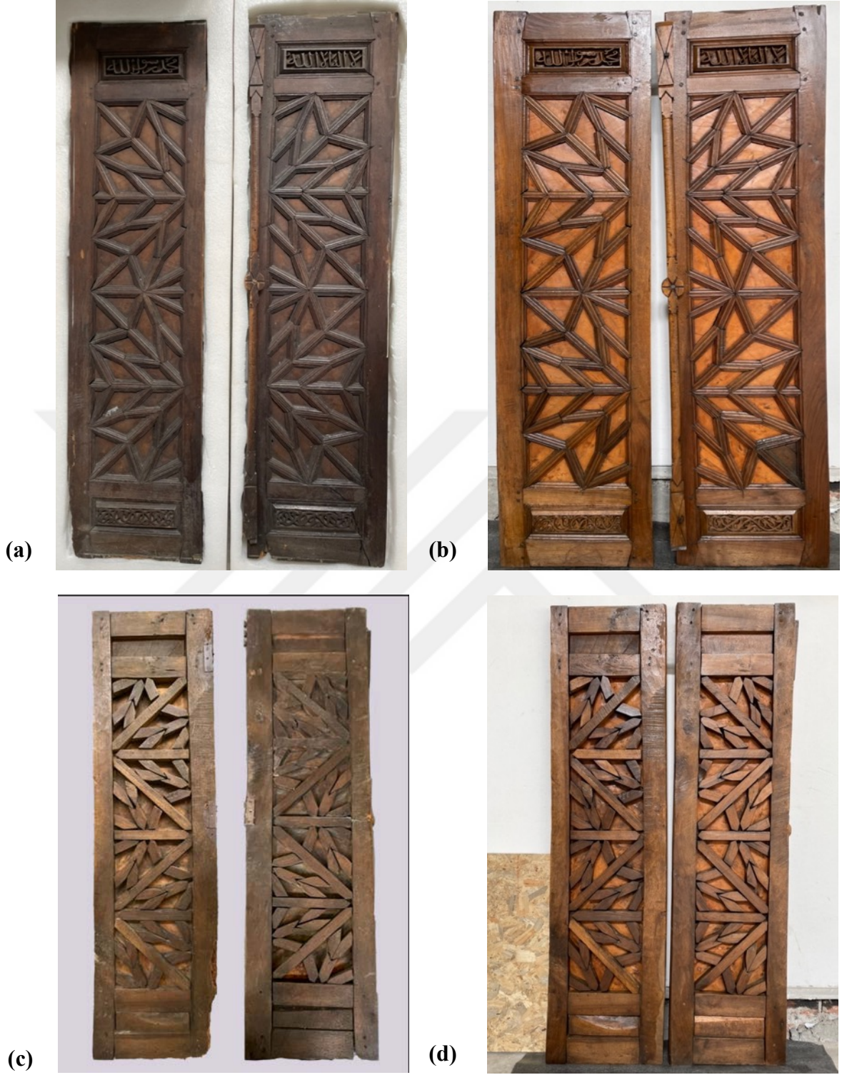
Resim 3.428. Taşkınpaşa Camii minberi kapı kanatları parça tamamlama işlem görüntüleri 8. (a, c) İşlem öncesi görüntüleri, (b, d) İşlem sonrası görüntüleri.
