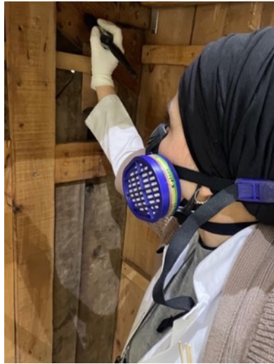
Resim 3.145. Taşkınpaşa Camii mihrabı (a) Xirein uygulama aşaması (b) azot çadırı uygulaması.
