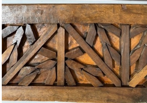
Resim 3.423. Taşkınpaşa Camii minberi kapı kanatları parça tamamlama işlem görüntüleri 3. (a, c) İşlem öncesi görüntüleri, (b, d) İşlem sonrası görüntüleri.
