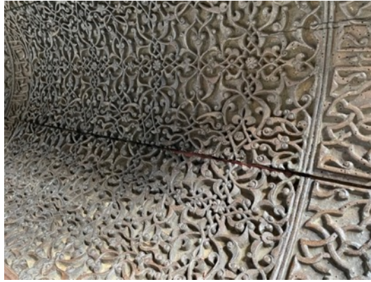
Resim 3.67. Taşkınpaşa Camii mihrabı çerçevelerde düz bağlantı yerlerinden ayrılma örnekleri.
