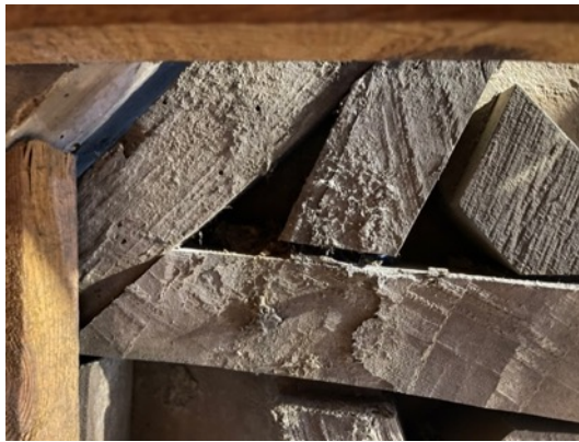
Resim 3.290. Taşkınpaşa Camii minberi aynalık iç kısmı yüzey birikintileri, toz ve kir / lekelenme örnekleri 2.
