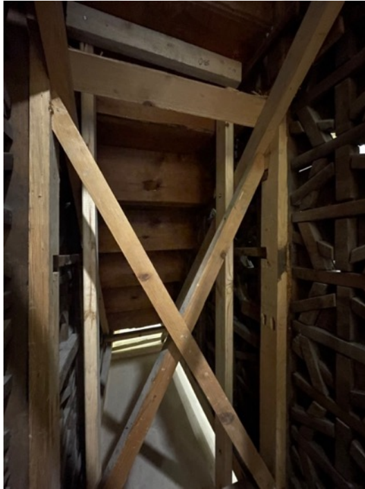
Resim 3.357. Taşkınpaşa Camii minberi destek ve ön koruma işlemleri.
