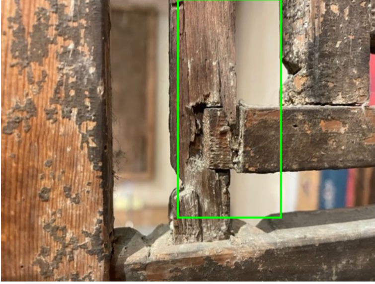
Resim 3.473. Şeyh Bahşı Mescidi vaaz kürsüsü zivana-kiniş geçme yerlerinde parça kaybı örneği 1.
