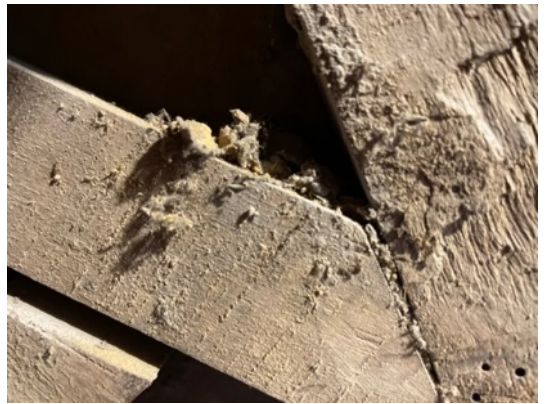
Resim 3.290. Taşkınpaşa Camii minberi aynalık iç kısmı yüzey birikintileri, toz ve kir / lekelenme örnekleri 2.
