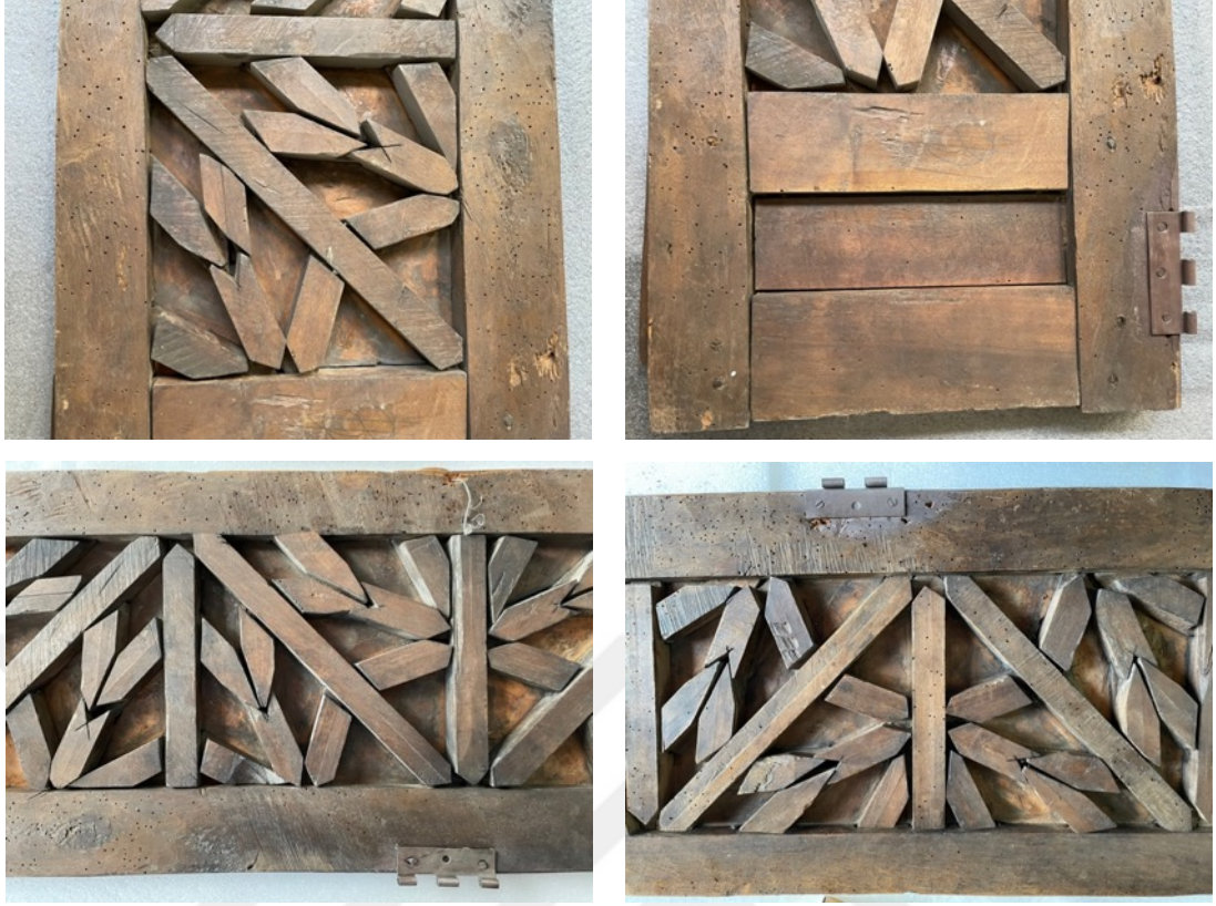
Resim 3.250. Taşkınpaşa Camii minberi kapı kanatları gevşeme örnekleri.
