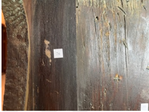
Resim 3.597. Gazanfer Ağa Camii vaaz kürsüsü taklit künde-kârî arka yüzünde oluşan çatlama ve ayrılma örneği detayı.
