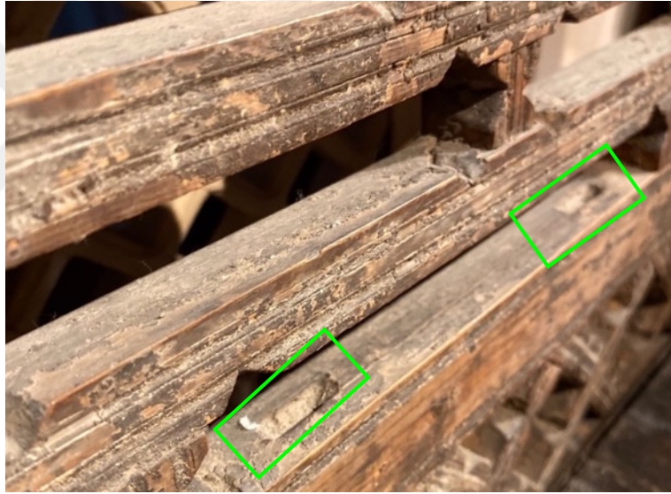
Resim 3.480. Şeyh Bahşı Mescidi vaaz kürsüsü zivana-kiniş kısmı parça kaybı örneği 2.
