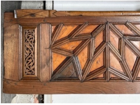
Resim 3.427. Taşkınpaşa Camii minberi kapı kanatları parça tamamlama işlem görüntüleri 7. (a, c) İşlem öncesi görüntüleri, (b, d) İşlem sonrası görüntüleri.
