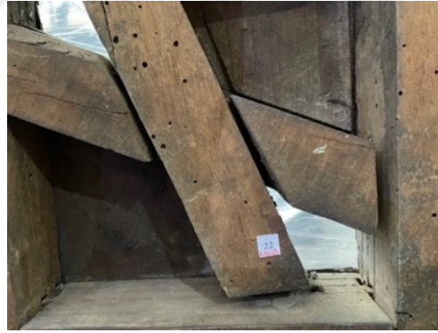
Resim 3.323. Taşkınpaşa Camii minberi böceklenme ve böcek uçuş delikleri detay fotoğrafı 5 (a) Fotoğraf makinesi çekimi (b) Optik Mikroskopta x50 büyüklükte detay görüntüsü (c) Optik Mikroskopta x200 büyüklükte detay görüntüsü.
