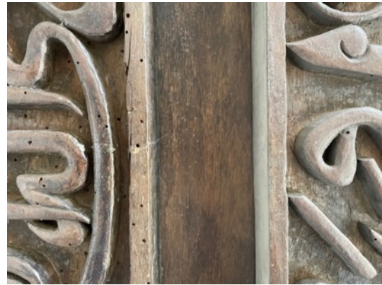
Resim 3.57. Taşkınpaşa Camii mihrabı süslemeli yüzeyde meydana gelen çatlak örneği ve detayları.
