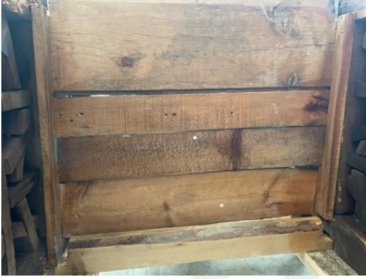
Resim 3.375. Taşkınpaşa Camii minberi aynalık kısmı enjektör ile Xirein uygulama işlem sırası ve sonrası görüntüleri.
