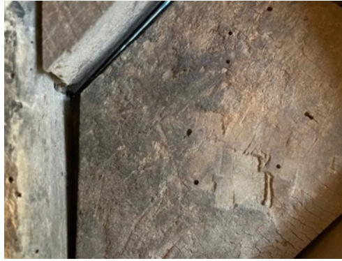
Resim 3.282. Taşkınpaşa Camii minberi renk değişim detay fotoğrafı 3 (a) Fotoğraf makinesi çekimi (b) Optik Mikroskopta x50 büyüklükte detay görüntüsü (c) Optik Mikroskopta x200 büyüklükte detay görüntüsü.
