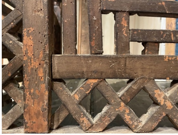
Resim 3.524. Şeyh Bahşi Mescidi vaaz kürsüsü yüzeyinde böcek uçuş delikleri örneği 2.
