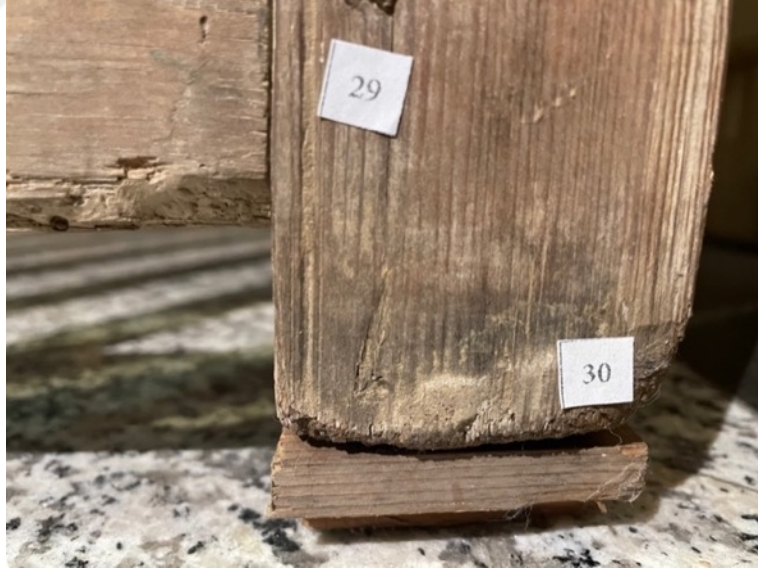
Resim 3.531. Şeyh Bahşi Mescidi vaaz kürsüsü ahşap malzeme ile yapılan destek görüntüsü 2.
