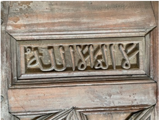
Resim 3.335. Taşkınpaşa Camii minberi kapısında niteliksiz onarım örnekleri 1.
