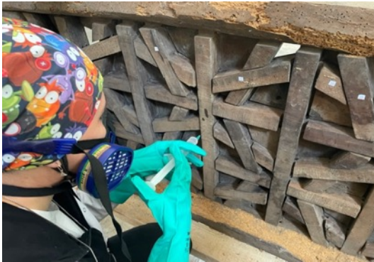
Resim 3.372. Taşkınpaşa Camii minberi köşk altı kısmı enjektör ile Xirein uygulama işlem görüntüleri.
