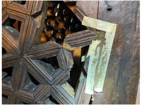
Resim 3.435. Taşkınpaşa Camii minberi müze nakil sonrası parça tamamlama işlem görüntüleri 5.
