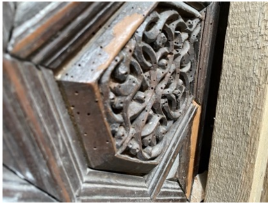
Resim 3.419. Taşkınpaşa Camii minberi parça tamamlama işlem görüntüleri 8.
