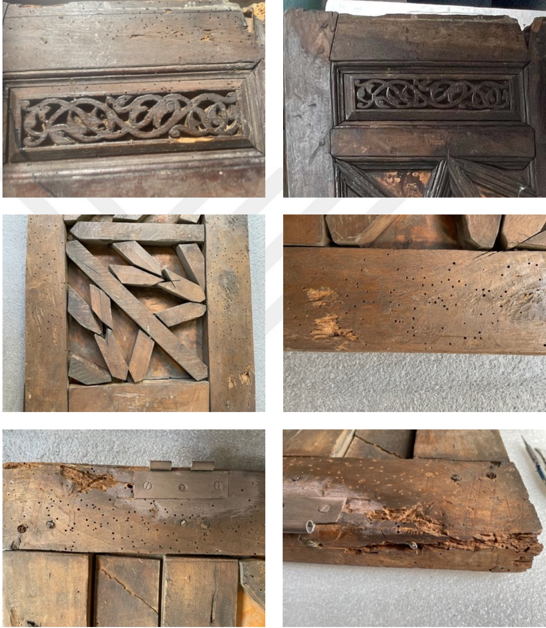
Resim 3.272. Taşkınpaşa Camii minberi kapı kısmı erozyon örnekleri.
