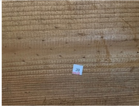
Resim 3.303. Taşkınpaşa Camii minberi yüzey birikintileri, toz ve kir / lekelenme detay fotoğrafı 11 (a) Fotoğraf makinesi çekimi (b) Optik Mikroskopta x50 büyüklükte detay görüntüsü (c) Optik Mikroskopta x200 büyüklükte detay görüntüsü.
