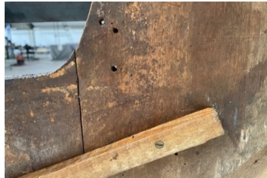
Resim 3.166. Taşkınpaşa Camii mihrabı arka yüzeyde böcek uçuş delikleri doldurma (a) öncesi (b) sonrası görüntü 2.
