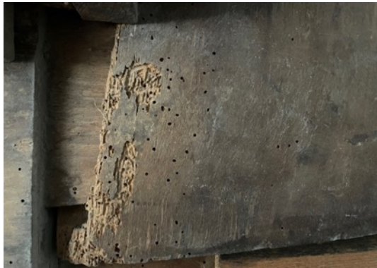
Resim 3.52. Taşkınpaşa Camii mihrabı arka yüzeyde meydana gelen kırılma örneği detayları.
