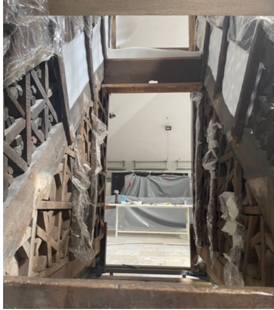
Resim 3.373. Taşkınpaşa Camii minberi aynalık kısmı enjektör ile Xirein uygulama işlem görüntüleri.
