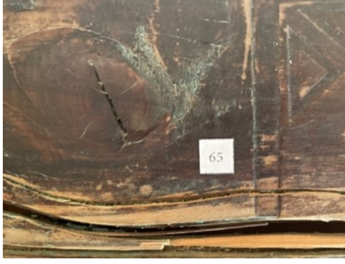
Resim 3.585. Gazanfer Ağa Camii vaaz kürsüsü arka yüzünde budak kaynaklı oluşan bozulma örneği detayı.
