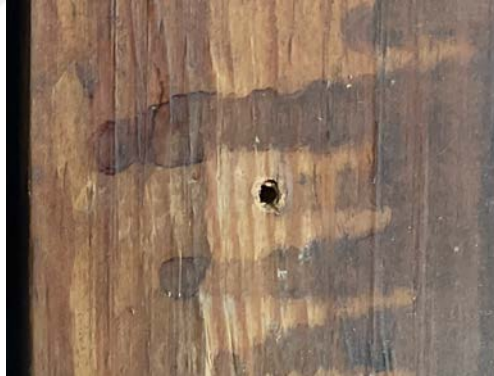
Resim 3.340. Taşkınpaşa Camii minberi niteliksiz onarım detay fotoğrafı 2 (a) Fotoğraf makinesi çekimi (b) Optik Mikroskopta x50 büyüklükte detay görüntüsü (c) Optik Mikroskopta x200 büyüklükte detay görüntüsü.
