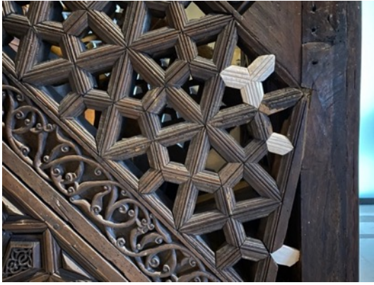
Resim 3.436. Taşkınpaşa Camii minberi müze nakil sonrası parça tamamlama işlem görüntüleri 6.
