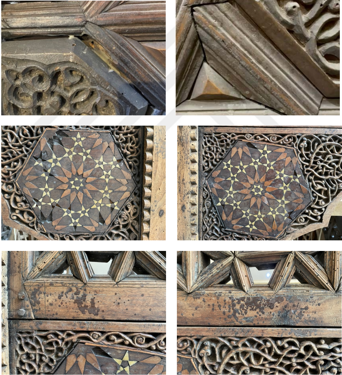
Resim 3.269. Taşkınpaşa Camii minberi koruyucu katmanda tabakalaşma örnekleri.
