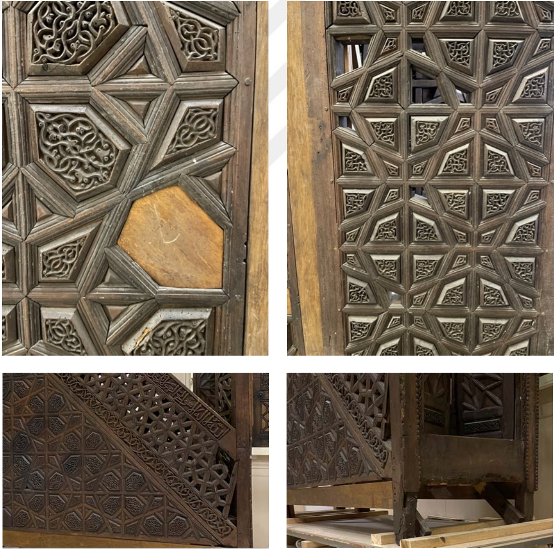
Resim 3.263. Taşkınpaşa Camii minberi parça kaybı örnekleri 1.
