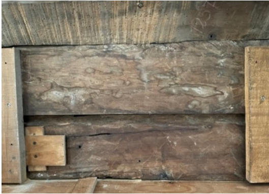
Resim 3.59. Taşkınpaşa Camii mihrabı arka yüzeyde meydana gelen çatlak örnekleri.
