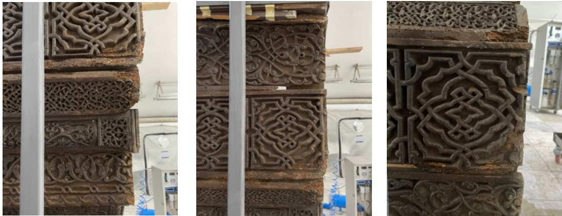
Resim 3.61. Taşkınpaşa Camii mihrabı süslemeli yüzeyde gevşeme örnekleri detay.
