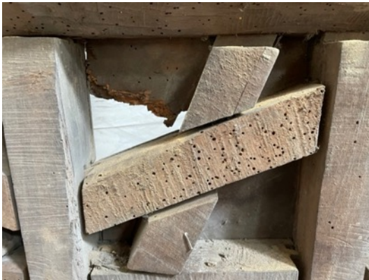
Resim 3.285. Taşkınpaşa Camii minberi köşk altı kısmı yüzey birikintileri, toz ve kir örnekleri 1.
