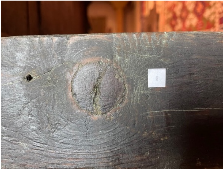
Resim 3.586. Gazanfer Ağa Camii vaaz kürsüsü yüzeyinde oluşan çatlama ve ayrılma örneği 1.
