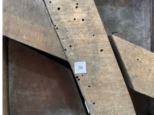
Resim 3.327. Taşkınpaşa Camii minberi böceklenme ve böcek uçuş delikleri detay fotoğrafı 9 (a) Fotoğraf makinesi çekimi (b) Optik Mikroskopta x50 büyüklükte detay görüntüsü (c) Optik Mikroskopta x200 büyüklükte detay görüntüsü.
