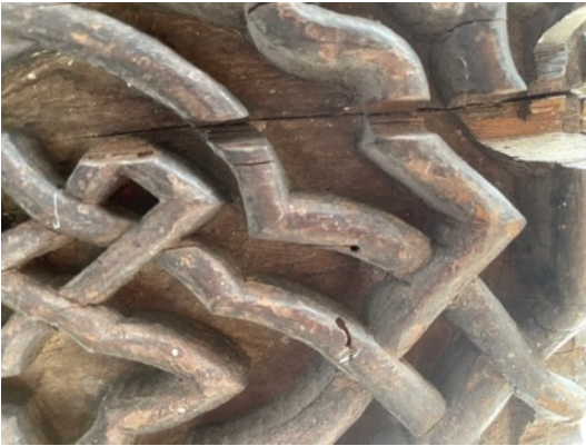
Resim 3.50. Taşkınpaşa Camii mihrabı süslemeli yüzeyde meydana gelen kırılma örneği detayları-2.
