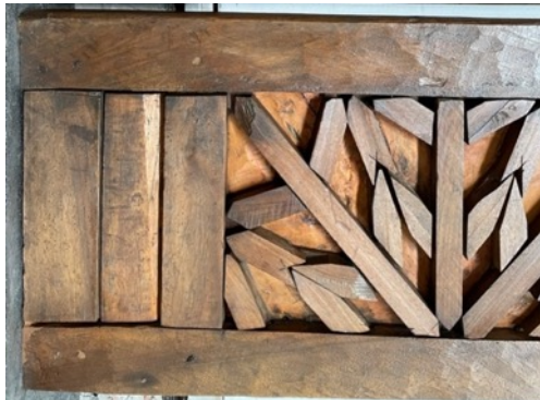
Resim 3.427. Taşkınpaşa Camii minberi kapı kanatları parça tamamlama işlem görüntüleri 7. (a, c) İşlem öncesi görüntüleri, (b, d) İşlem sonrası görüntüleri.
