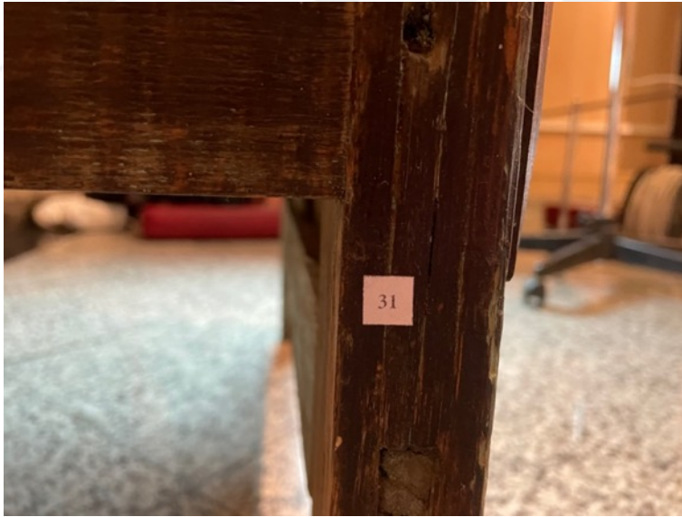
Resim 3.590. Gazanfer Ağa Camii vaaz kürsüsü ayak kısmında oluşan çatlama ve ayrılma örneği 1.
