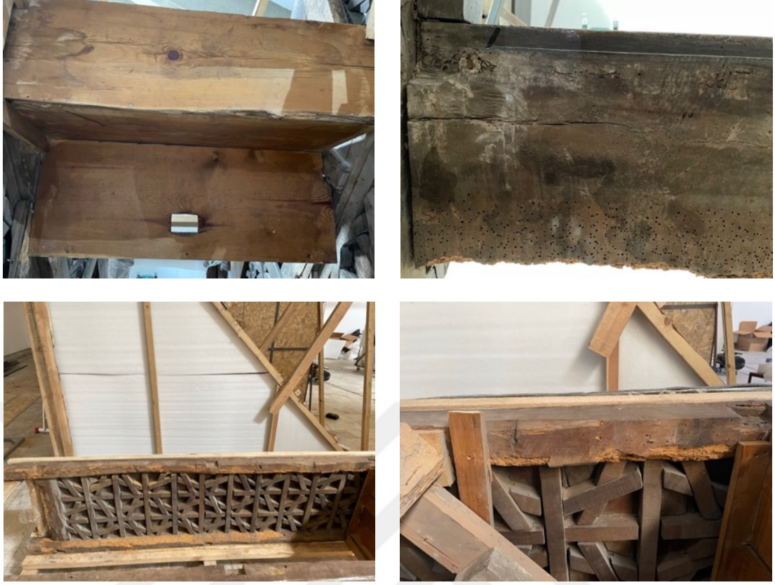
Resim 3.242. Taşkınpaşa Camii minberi kırılma örnekleri 2.
