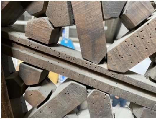
Resim 3.257. Taşkınpaşa Camii minberi iskelet sistemi oynama örnekleri 4.
