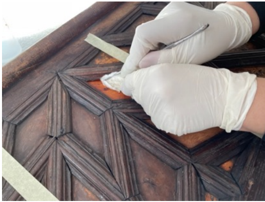
Resim 3.390. Taşkınpaşa Camii minberi kapı kanatları temizlik işlem görüntüleri 2.
