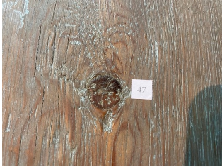
Resim 3.583. Gazanfer Ağa Camii vaaz kürsüsü rahle kısmında budak kaynaklı oluşan bozulma örneği 3.
