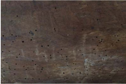
Resim 3.165. Taşkınpaşa Camii mihrabı arka yüzeyde böcek uçuş delikleri doldurma (a) öncesi (b) sonrası görüntü 1.
