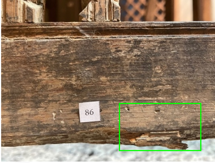
Resim 3.528. Şeyh Bahşi Mescidi vaaz kürsüsü yüzeyinde böcek uçuş delikleri tahribatı.
