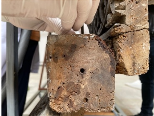
Resim 3.54. Taşkınpaşa Camii mihrabı alt kısmında meydana gelen kırılma örneğı detayları.
