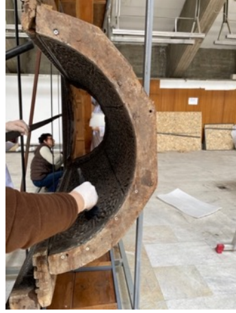
Resim 3.161. Taşkınpaşa Camii mihrabı yüzeyinden kimyasal boya kaldırma işlem görüntüleri 8.
