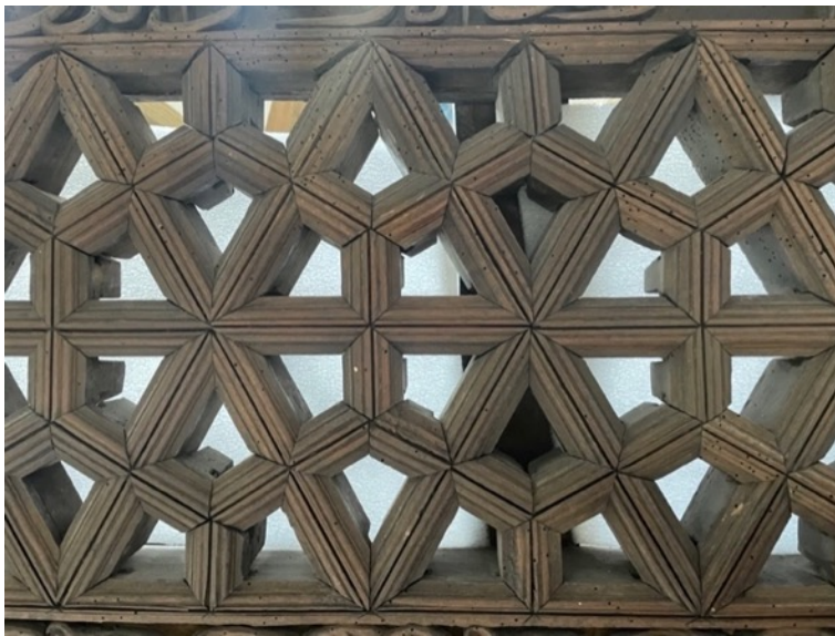
Resim 3.230. Taşkınpaşa Camii minberi korkuluk detayı.
