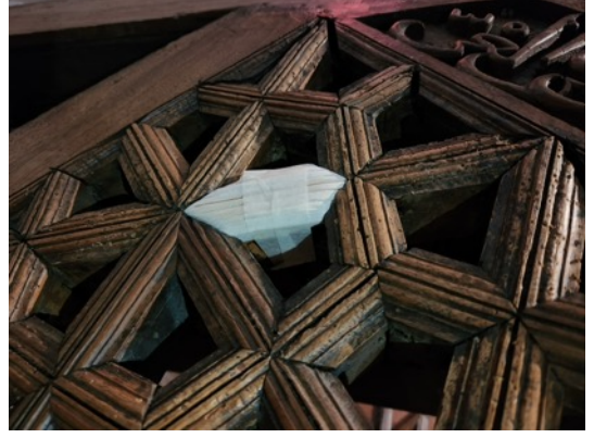
Resim 3.437. Taşkınpaşa Camii minberi müze nakil sonrası parça tamamlama işlem görüntüleri 7.
