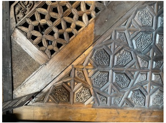
Resim 3.394. Taşkınpaşa Camii minberi müze nakil sonrası boya kaldırma işlem görüntüleri 3.
