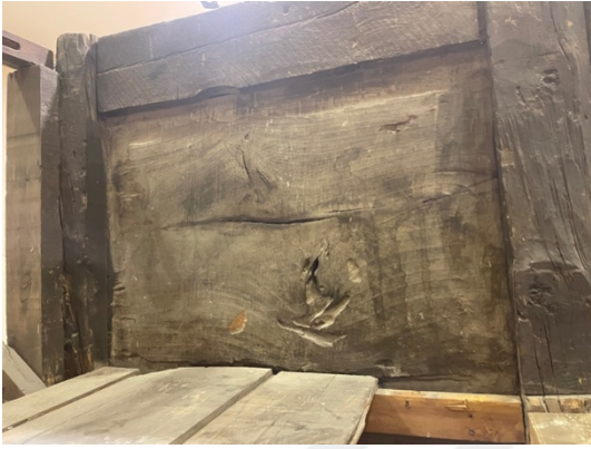
Resim 2.6. Eser yüzeyinde çatlama-yarılma örnekleri.
