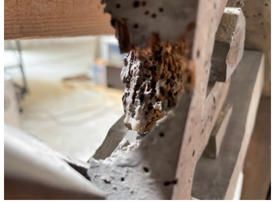
Resim 3.267. Taşkınpaşa Camii minberi parça kaybı örnekleri 5.
