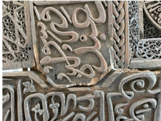
Resim 3.49. Taşkınpaşa Camii mihrabı süslemeli yüzeyde meydana gelen kırılma örneğı detayları-1.
