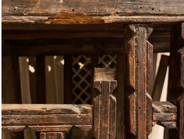
Resim 3.476. Şeyh Bahşi Mescidi vaaz kürsüsü zivana-kiniş geçme yerlerinde parça kaybı örneği 4
