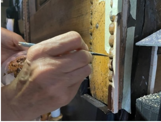
Resim 3.434. Taşkınpaşa Camii minberi müze nakil sonrası parça tamamlama işlem görüntüleri 4.
