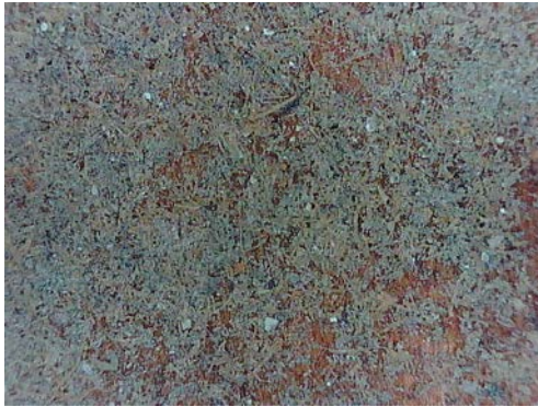
Resim 3.103. Taşkınpaşa Camii mihrabı yüzey birikintileri, toz ve kir / lekelenme detay fotoğrafı 8 (a) Fotoğraf makinesi çekimi (b, c) Optik Mikroskopta x50 büyüklükte detay görüntüsü (d, e, f, g) Optik Mikroskopta x200 büyüklükte detay görüntüsü.
