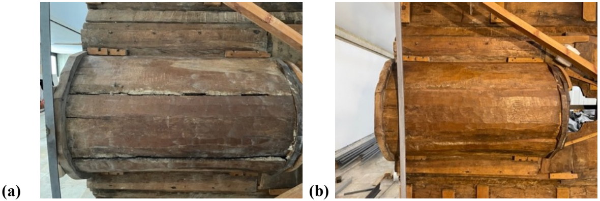
Resim 3.168. Taşkınpaşa Camii mihrabı, niş arka yüzey böcek uçuş delikleri doldurma (a) öncesi (b) sonrası görüntü.
