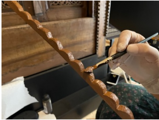
Resim 3.432. Taşkınpaşa Camii minberi müze nakil sonrası parça tamamlama işlem görüntüleri 2.
