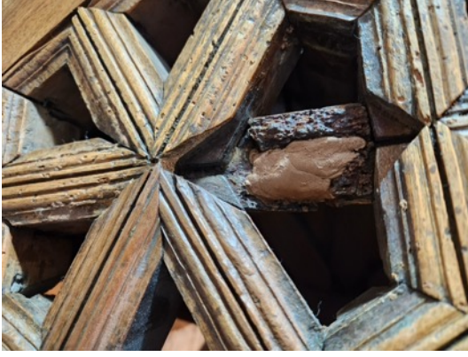
Resim 3.437. Taşkınpaşa Camii minberi müze nakil sonrası parça tamamlama işlem görüntüleri 7.
