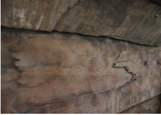
Resim 3.58. Taşkınpaşa Camii mihrabı süslemeli yüzeyde meydana gelen çatlak detayları.
