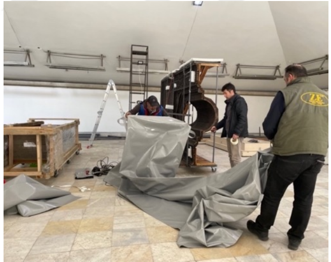
Resim 3.145. Taşkınpaşa Camii mihrabı (a) Xirein uygulama aşaması (b) azot çadırı uygulaması.
