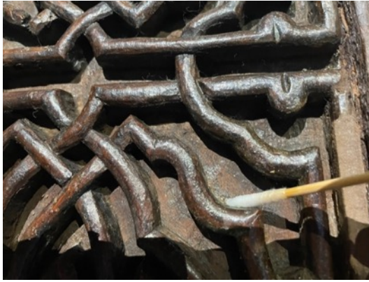
Resim 3.204. Taşkınpaşa Camii mihrabı müze teşhirde tamamlama ve böcek uçuş deliği doldurma işlem görüntüleri 10.
