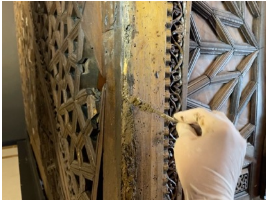
Resim 3.432. Taşkınpaşa Camii minberi müze nakil sonrası parça tamamlama işlem görüntüleri 2.
