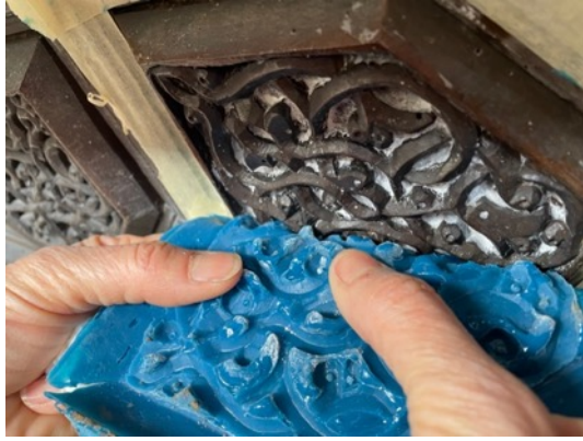
Resim 3.416. Taşkınpaşa Camii minberi parça tamamlama işlem görüntüleri 5.
