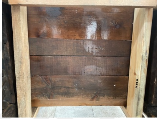
Resim 3.375. Taşkınpaşa Camii minberi aynalık kısmı enjektör ile Xirein uygulama işlem sırası ve sonrası görüntüleri.
