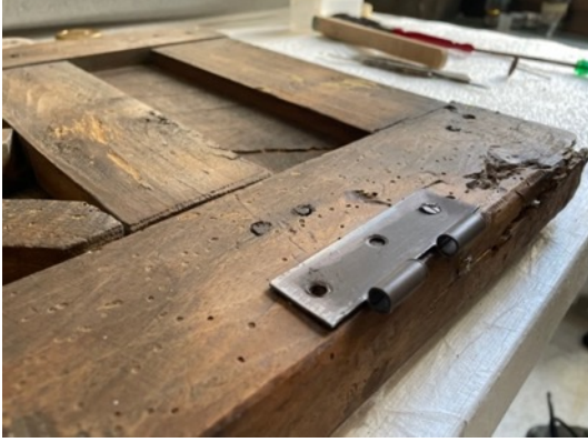
Resim 3.334.. Taşkınpaşa Camii minberi aynalık iç kısmı niteliksiz onarım örnekleri 3.
