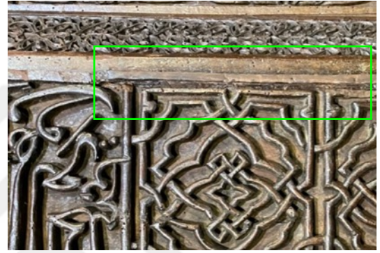
Resim 3.198. Taşkınpaşa Camii mihrabı müze teşhirde tamamlama ve böcek uçuş deliği doldurma işlem görüntüleri 4.
