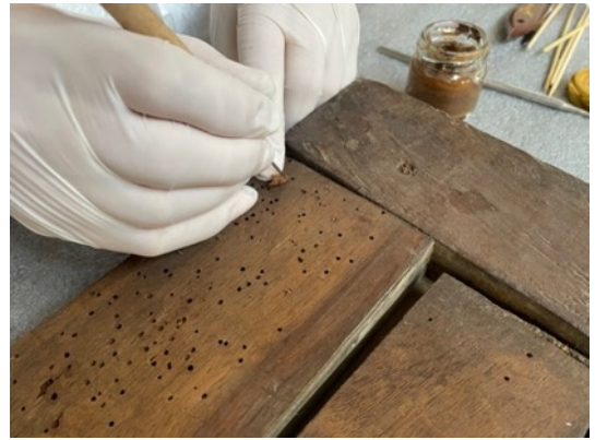
Resim 3.410. Taşkınpaşa Camii minberi kapı kanatları sağlamlaştırma işlem görüntüleri 6.
