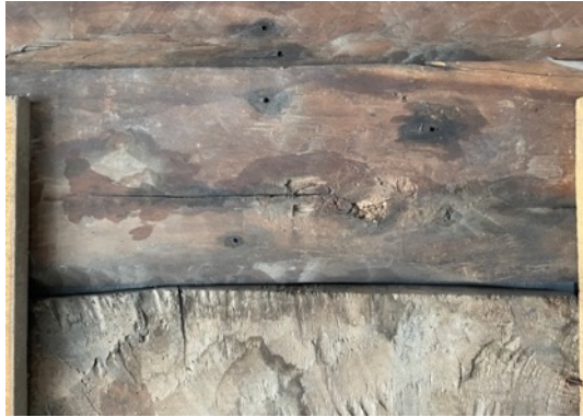
Resim 3.59. Taşkınpaşa Camii mihrabı arka yüzeyde meydana gelen çatlak örnekleri.
