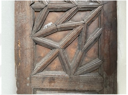
Resim 3.336. Taşkınıpaşa Camii minberi kapısında niteliksiz onarım örnekleri 2.
