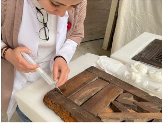
Resim 3.406. Taşkınpaşa Camii minberi kapı kanatları sağlamlaştırma işlem görüntüleri 2.
