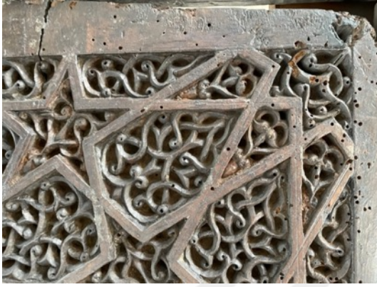
Resim 3.51. Taşkınpaşa Camii mihrabı süslemeli yüzeyde meydana gelen kırılma örneği detayları- 3.
