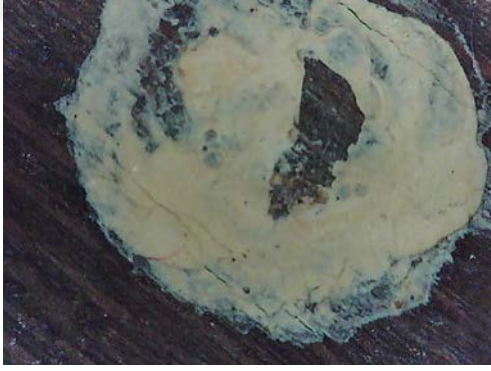
Resim 3.493. Şeyh Bahşi Mescidi vaaz kürsüsü beyaz tabakalaşma ve yüzeyden ayrılma detay fotoğrafı 5. (a) Fotoğraf makinesi çekimi b) Optik Mikroskopta x50 büyüklükte tabaka detay görüntüsü b) Optik Mikroskopta x200 büyüklükte tabaka detay görüntüsü.
