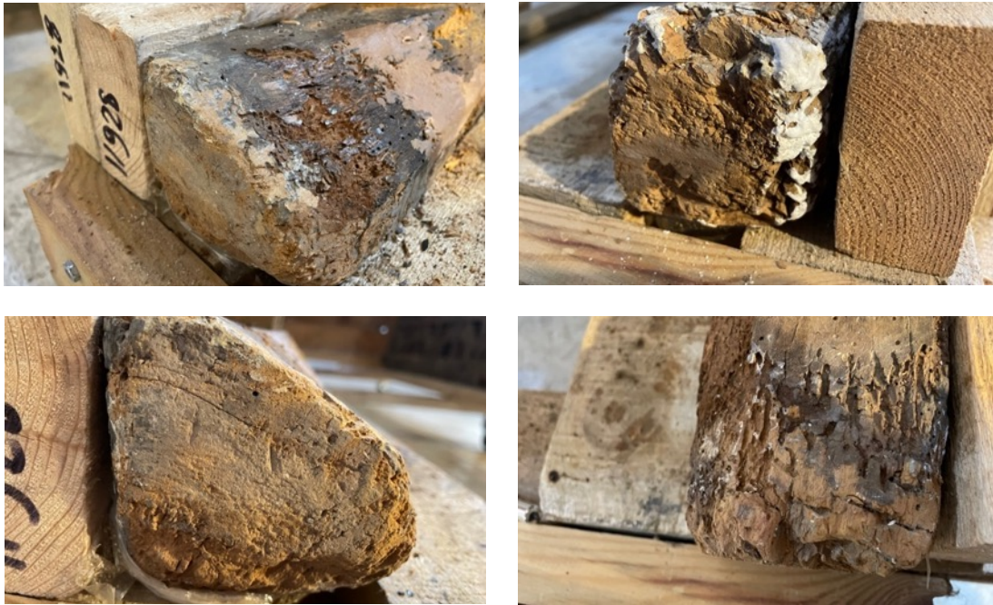
Resim 3.271. Taşkınpaşa Camii minberi ayak kısmında erozyon örnekleri.
