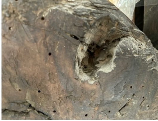
Resim 3.267. Taşkınpaşa Camii minberi parça kaybı örnekleri 5.
