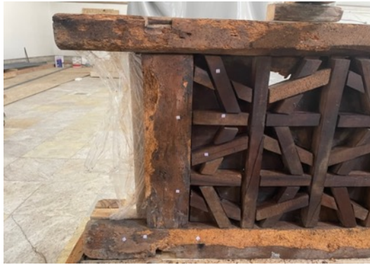
Resim 3.374. Taşkınpaşa Camii minberi aynalık kısmı enjektör ile Xirein uygulama işlem sonrası görüntüleri.
