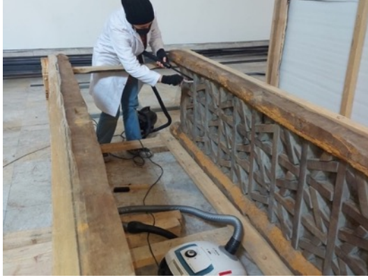
Resim 3.371. Taşkınpaşa Camii minberi vakumlu ön kuru temizlik işlemi görüntüleri.
