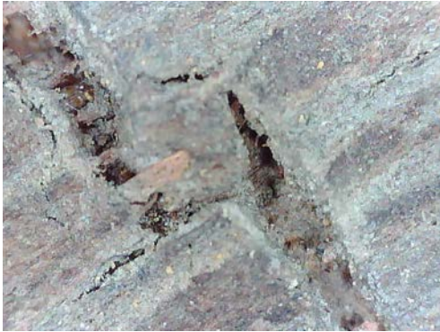
Resim 3.274. Taşkınpaşa Camii minberi erozyon detay fotoğrafı 2 (a) Fotoğraf makinesi çekimi (b) Optik Mikroskopta x50 büyüklükte detay görüntüsü (c) Optik Mikroskopta x200 büyüklükte detay görüntüsü.
