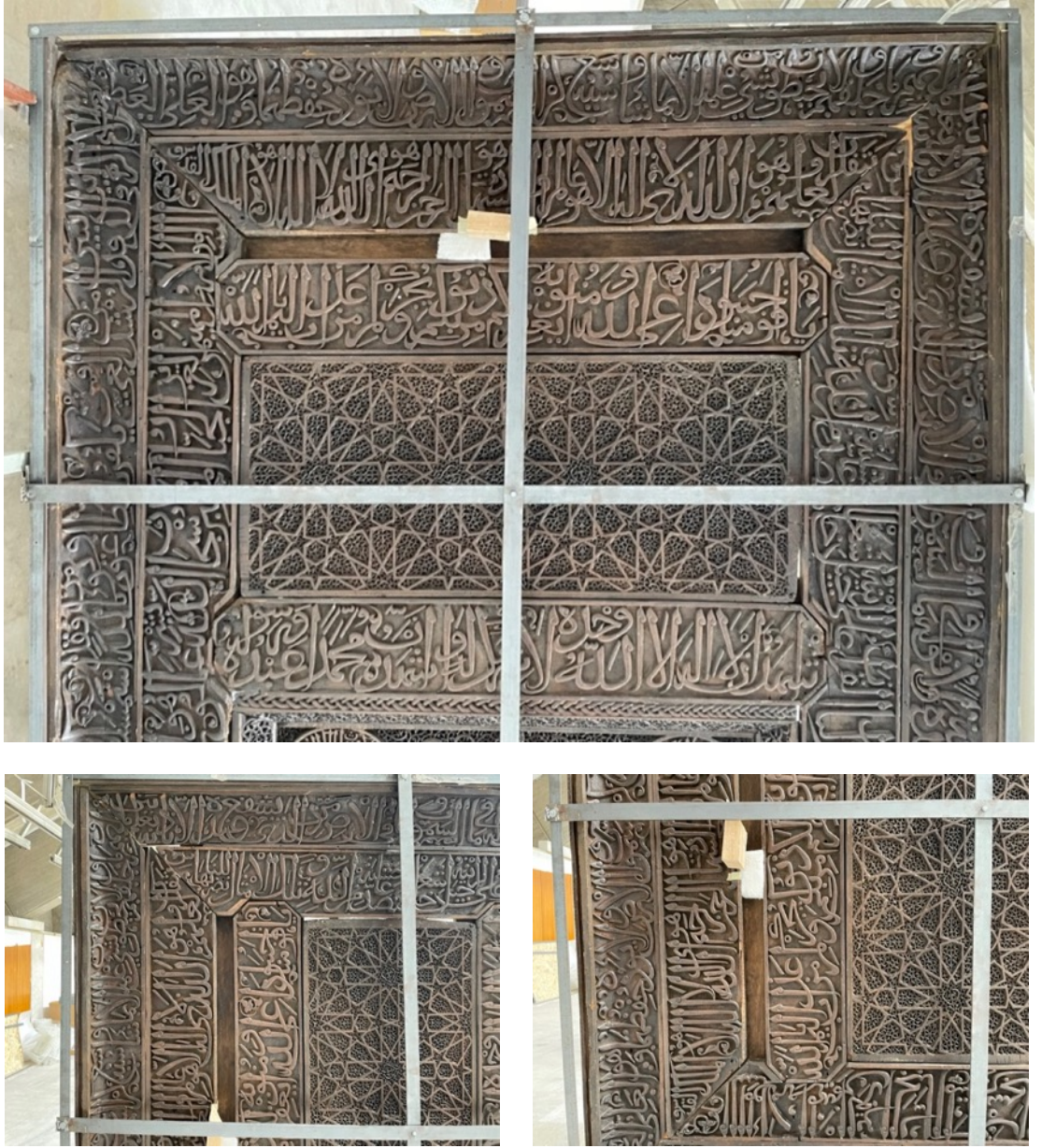
Resim 3.64. Taşkınpaşa Camii mihrabı oynama problemi örnekleri.
