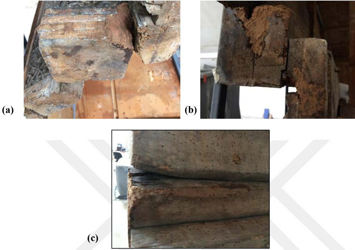
Resim 3.169. Taşkınpaşa Camii mihrabı alt kısımlarda sağlamlaştırma (a) işlem sonrası (b) işlem sırasında (c) işlem sonrası görüntü.
