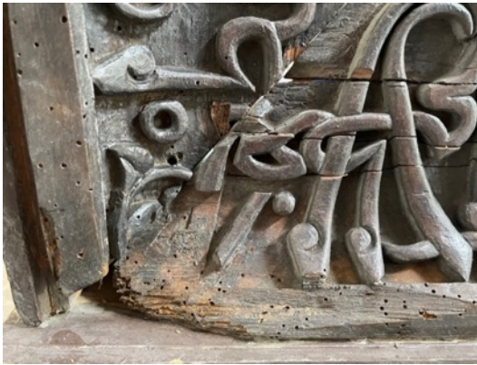
Resim 3.57. Taşkınpaşa Camii mihrabı süslemeli yüzeyde meydana gelen çatlak örneği ve detayları.
