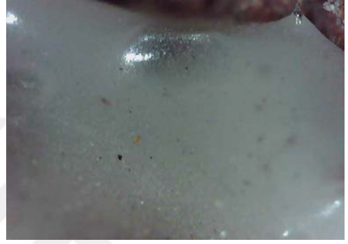
Resim 3.340. Taşkınpaşa Camii minberi niteliksiz onarım detay fotoğrafı 2 (a) Fotoğraf makinesi çekimi (b) Optik Mikroskopta x50 büyüklükte detay görüntüsü (c) Optik Mikroskopta x200 büyüklükte detay görüntüsü.
