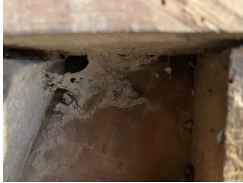
Resim 3.307. Taşkınpaşa Camii minberi yüzey birikintileri, toz ve kir / lekelenme detay fotoğrafı 15 (a) Fotoğraf makinesi çekimi (b) Optik Mikroskopta x50 büyüklükte detay görüntüsü (c) Optik Mikroskopta x200 büyüklükte detay görüntüsü.
