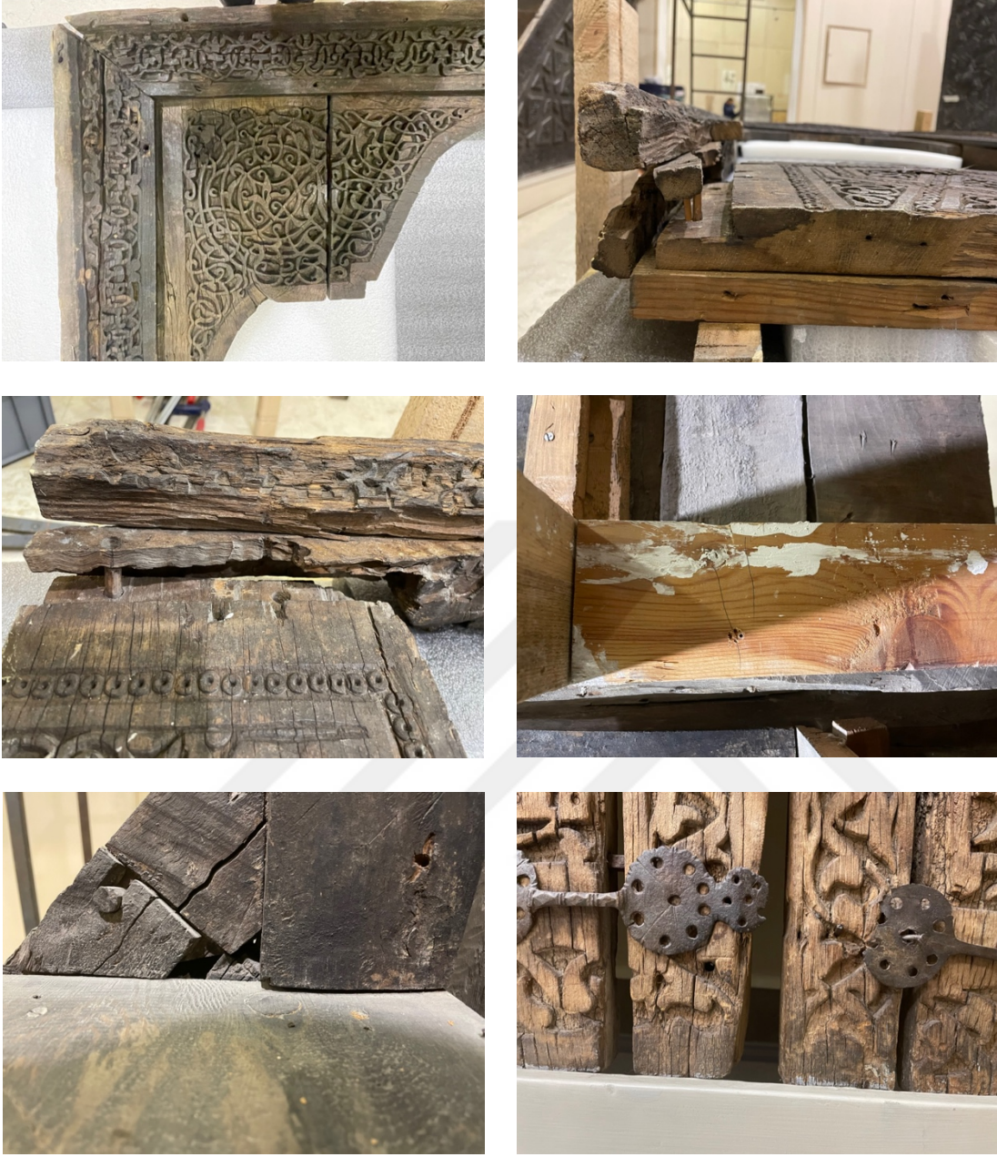
Resim 2.7. Eserde birleşim yerlerinde ayrılma, gevşeme, oynama.
