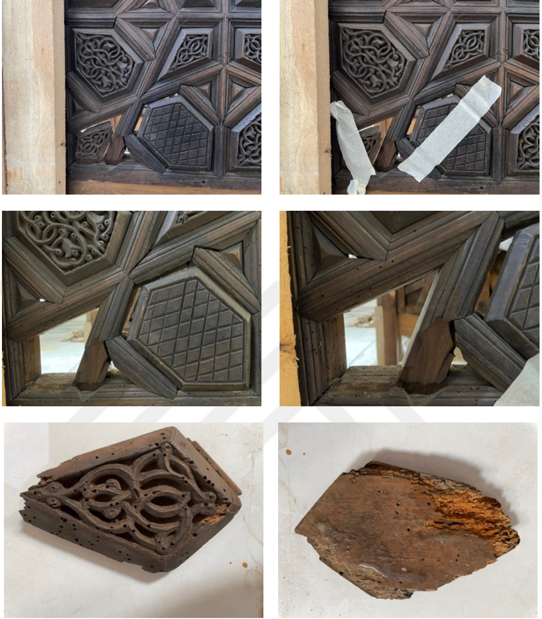
Resim 3.252. Taşkınpaşa Camii minberi süslemeli parçalarında gevşeme/oynama örnekleri.
