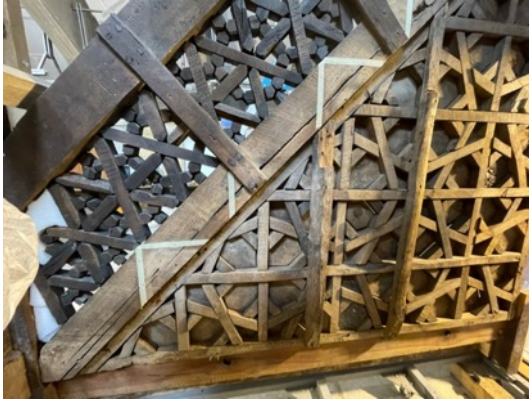
Resim 3.260. Taşkınpaşa Camii minberi birleşim yerlerinden ayrılma örnekleri 3.
