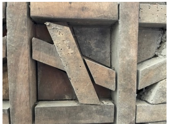
Resim 3.286. Taşkınpaşa Camii minberi köşk altı kısmı yüzey birikintileri, toz ve kir örnekleri 2.
