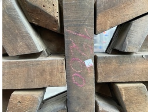
Resim 3.300. Taşkınpaşa Camii minberi yüzey birikintileri, toz ve kir / lekelenme detay fotoğrafı 8 (a) Fotoğraf makinesi çekimi (b) Optik Mikroskopta x50 büyüklükte detay görüntüsü (c) Optik Mikroskopta x200 büyüklükte detay görüntüsü.
