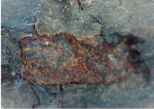
Resim 3.537. Şeyh Bahşi Mescidi vaaz kürsüsü metal malzeme bozulmaları detay görüntüleri.
