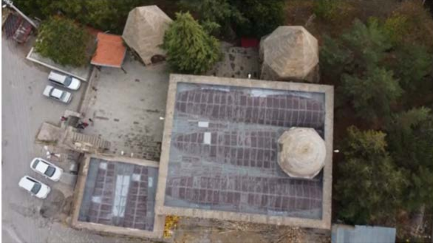
Resim 2.26. Taşkınpaşa Camii genel görünüm.
