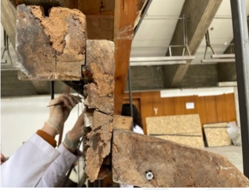
Resim 3.155. Taşkınpaşa Camii mihrabı yüzeyinden kimyasal boya kaldırma işlem görüntüleri 2.
