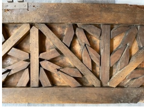
Resim 3.422. Taşkınpaşa Camii minberi kapı kanatları parça tamamlama işlem görüntüleri 2. (a, c) İşlem öncesi görüntüleri, (b, d) İşlem sonrası görüntüleri.
