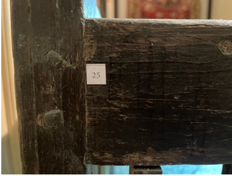
Resim 3.589. Gazanfer Ağa Camii vaaz kürsüsü yüzeyinde oluşan çatlama ve ayrılma örneği 4.
