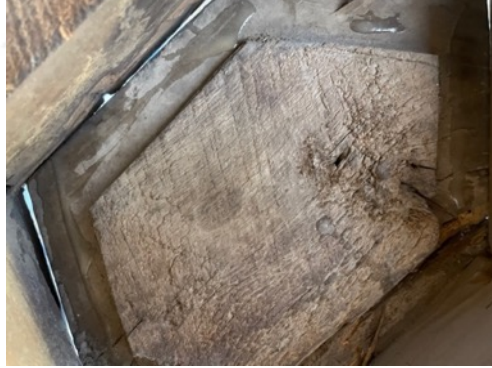
Resim 3.338. Taşkınpaşa Camii minberi merdiven kısmı niteliksiz onarım örnekleri 2.
