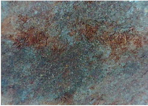
Resim 3.297. Taşkınpaşa Camii minberi yüzey birikintileri, toz ve kir / lekelenme detay fotoğrafı 5 (a) Fotoğraf makinesi çekimi (b) Optik Mikroskopta x50 büyüklükte detay görüntüsü (c) Optik Mikroskopta x200 büyüklükte detay görüntüsü.
