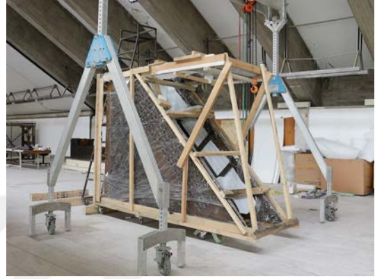
Resim 3.139. AKM içerisine caraskal sistemi kurulum görüntüleri.
