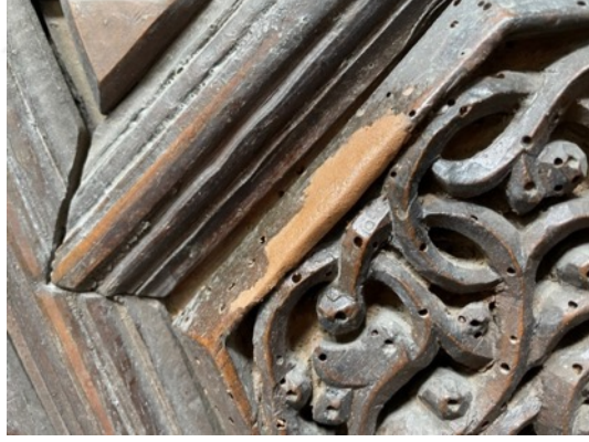
Resim 3.418. Taşkınpaşa Camii minberi parça tamamlama işlem görüntüleri 7.
