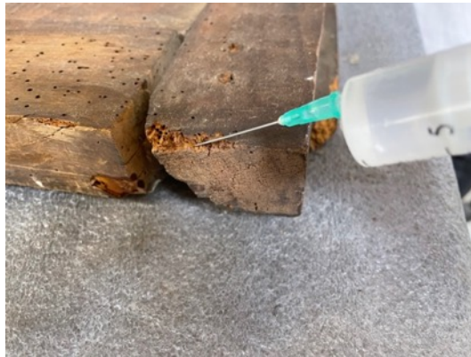
Resim 3.395. Taşkınpaşa Camii minberi sağlamaştırma işlem görüntüleri 1.
