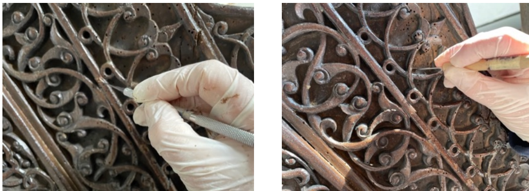
Resim 3.170. Taşkınpaşa Camii mihrabı ön yüzeyde böcek uçuş delikleri doldurma işlem görüntüleri 1.
