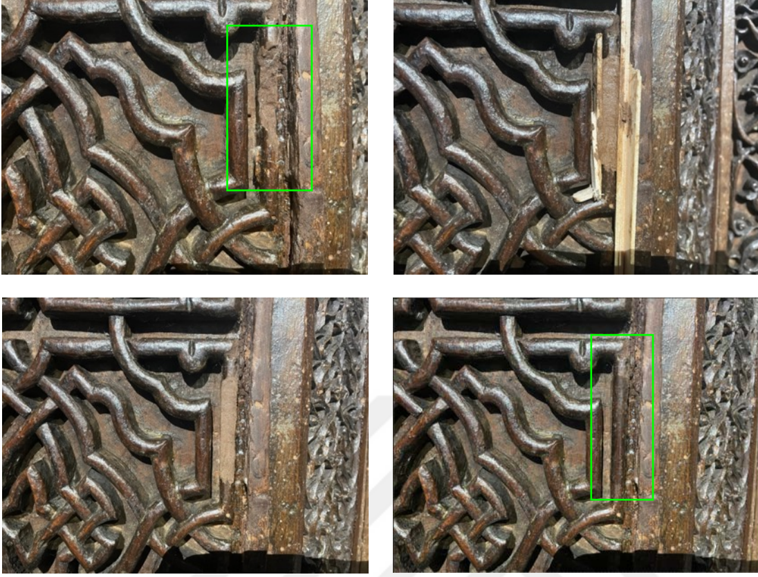
Resim 3.205. Taşkınpaşa Camii mihrabı müze teşhirde tamamlama ve böcek uçuş deliği doldurma işlem görüntüleri 11.
