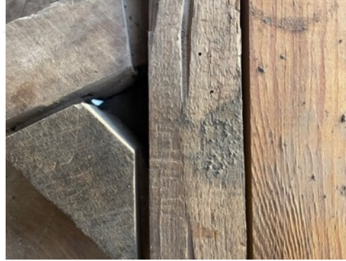
Resim 3.305. Taşkınpaşa Camii minberi yüzey birikintileri, toz ve kir / lekelenme detay fotoğrafı 13 (a) Fotoğraf makinesi çekimi (b) Optik Mikroskopta x50 büyüklükte detay görüntüsü (c) Optik Mikroskopta x200 büyüklükte detay görüntüsü.
