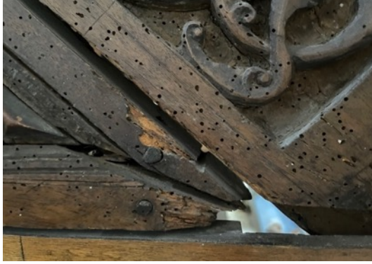
Resim 3.414. Taşkınpaşa Camii minberi kapı kanatları parça tamamlama işlem görüntüleri 3.
