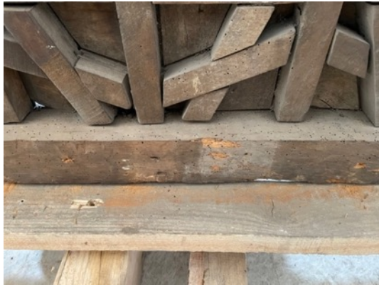
Resim 3.256. Taşkınpaşa Camii minberi iskelet sistemi oynama örnekleri 3.
