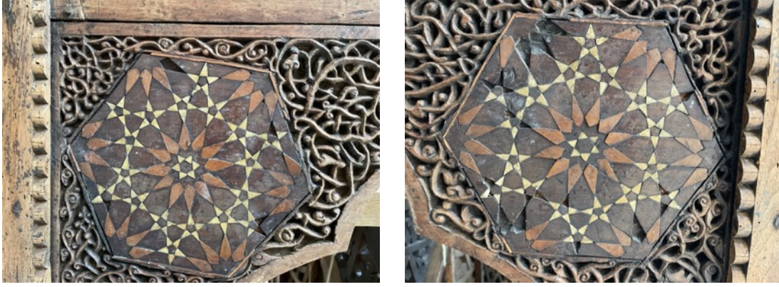
Resim 3.253. Taşkınpaşa Camii minberi tarsi teknikli rozet parçalarında oynama örnekleri.
