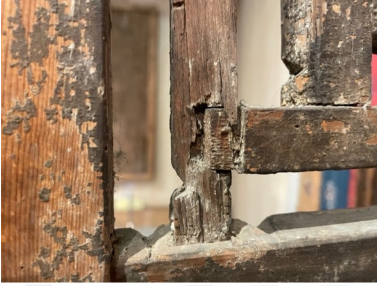
Resim 3.509. Şeyh Bahşi Mescidi vaaz kürsüsü yüzey birikinti ve kir örneği 1.
