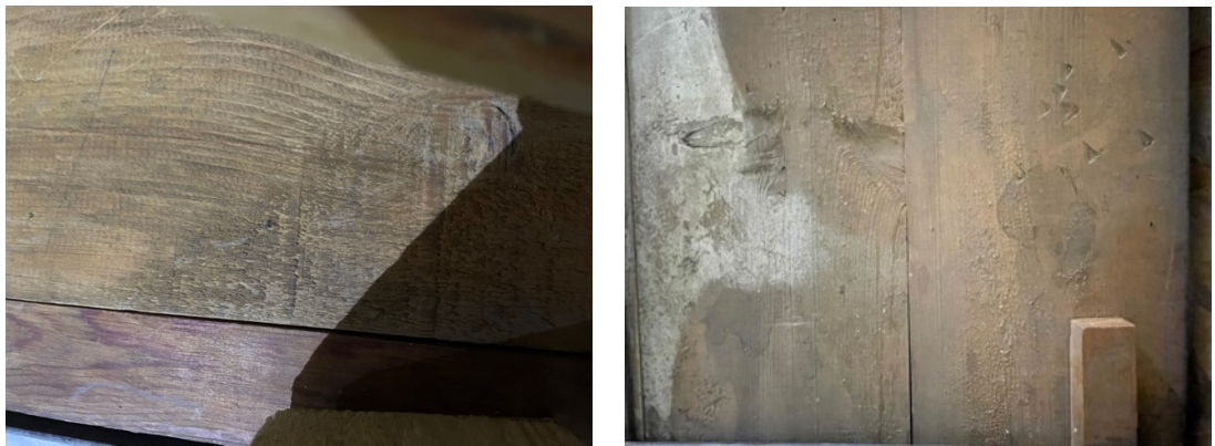
Resim 3.48. Taşkınpaşa Camii mihrabı yüzeyinde lif kıvrıklığı.
