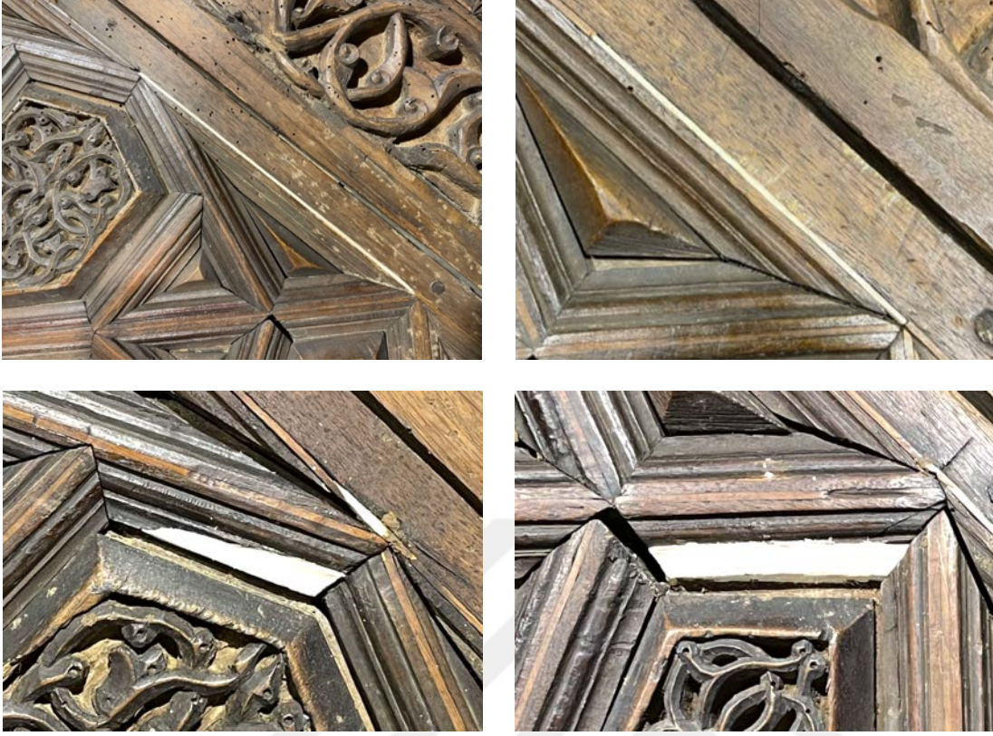
Resim 3.439. Taşkınpaşa Camii minberi müze nakil sonrası parça tamamlama işlem görüntüleri 9.
