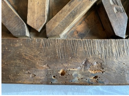
Resim 3.334.. Taşkınpaşa Camii minberi aynalık iç kısmı niteliksiz onarım örnekleri 3.
