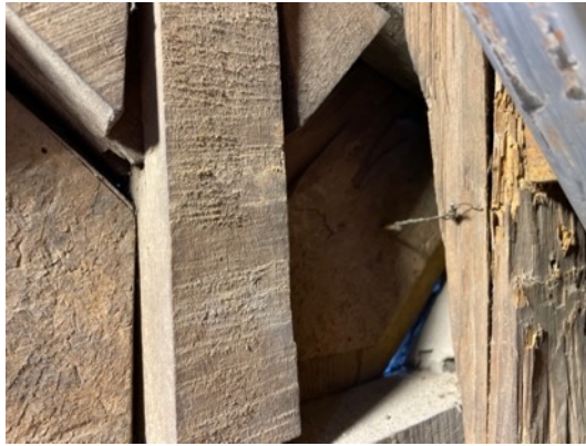
Resim 3.333. Taşkınpaşa Camii minberi aynalık iç kısmı niteliksiz onarım örnekleri 2.
