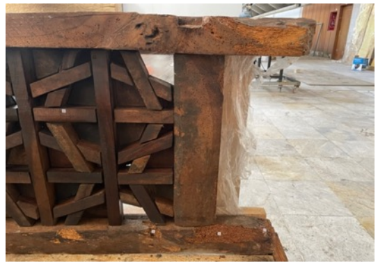
Resim 3.374. Taşkınpaşa Camii minberi aynalık kısmı enjektör ile Xirein uygulama işlem sonrası görüntüleri.
