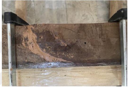
Resim 3.403. Taşkınpaşa Camii minberi sağlamlaştırma işlem görüntüleri 9.
