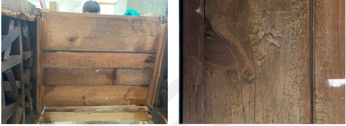
Resim 3.240. Taşkınpaşa Camii minberi yüzeyinde lif kıvrıklığı.
