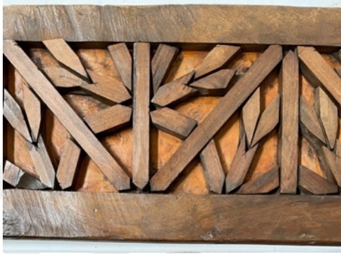
Resim 3.426. Taşkınpaşa Camii minberi kapı kanatları parça tamamlama işlem görüntüleri 6. (a, c) İşlem öncesi görüntüleri, (b, d) İşlem sonrası görüntüleri.
