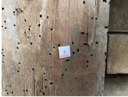
Resim 3.319. Taşkınpaşa Camii minberi böceklenme ve böcek uçuş delikleri detay fotoğrafı 1 (a) Fotoğraf makinesi çekimi (b) Optik Mikroskopta x50 büyüklükte detay görüntüsü (c) Optik Mikroskopta x200 büyüklükte detay görüntüsü.
