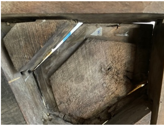
Resim 3.289. Taşkınpaşa Camii minberi aynalık iç kısmı yüzey birikintileri, toz ve kir örnekleri 1.
