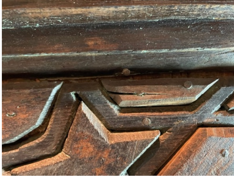
Resim 3.592. Gazanfer Ağa Camii vaaz kürsüsü süsleme kompozisyonunda oluşan çatlama ve ayrılma örneği 1.
