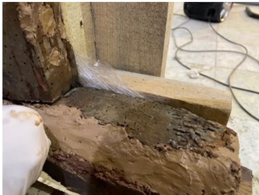
Resim 3.402. Taşkınpaşa Camii minberi sağlamlaştırma işlem görüntüleri 8.
