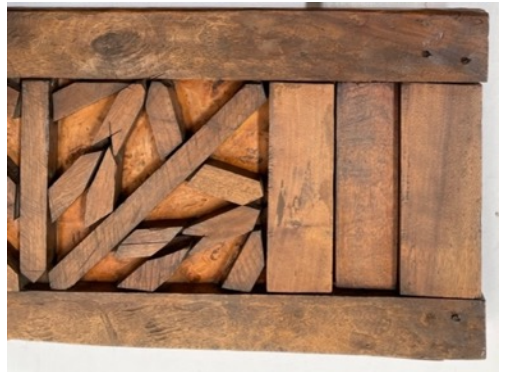
Resim 3.425. Taşkınpaşa Camii minberi kapı kanatları parça tamamlama işlem görüntüleri 5. (a, c) İşlem öncesi görüntüleri, (b, d) İşlem sonrası görüntüleri.
