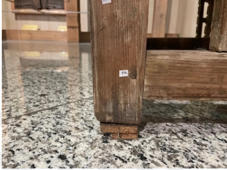
Resim 3.530. Şeyh Bahşi Mescidi vaaz kürsüsü ahşap malzeme ile yapılan destek görüntüsü 1.
