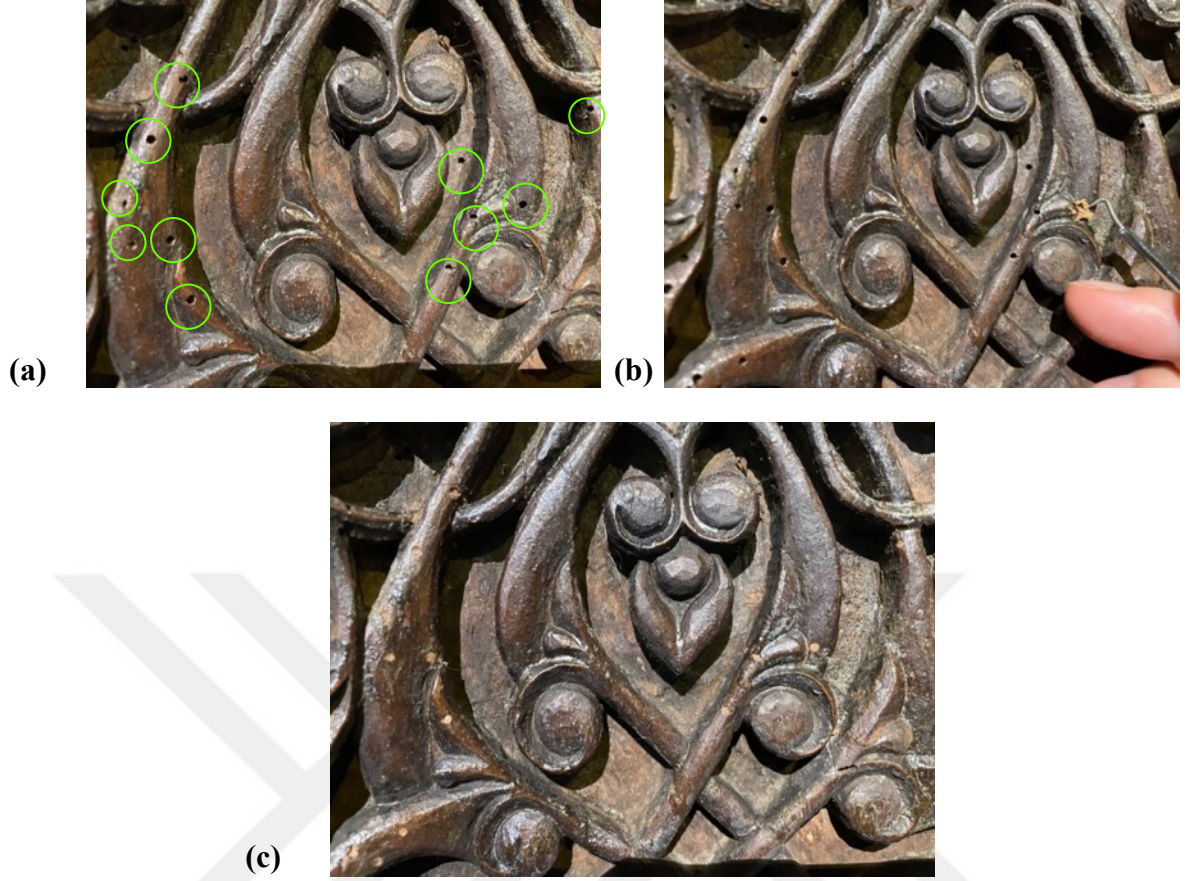
Resim 3.171. Taşkınpaşa Camii mihrabı ön yüzeyde böcek uçuş delikleri doldurma görüntüleri 2 (a) öncesi (b) sırası (c) sonrası görüntü.
