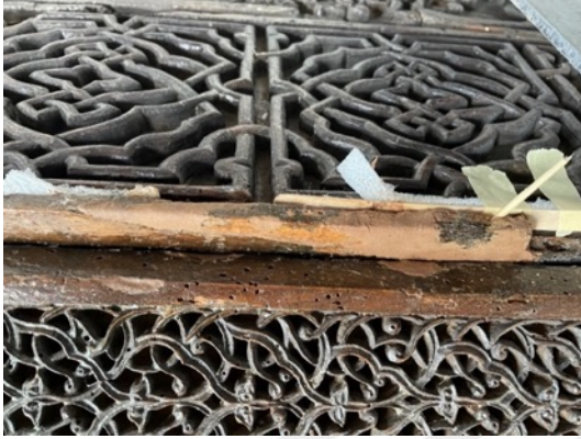
Resim 3.195. Taşkınpaşa Camii mihrabı müze teşhirde tamamlama ve böcek uçuş deliği doldurma işlem görüntüleri 1.
