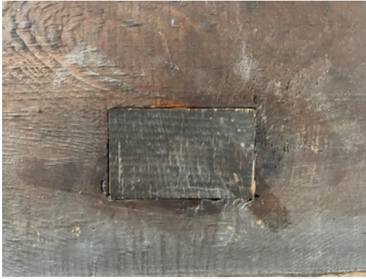
Resim 3.338. Taşkınpaşa Camii minberi merdiven kısmı niteliksiz onarım örnekleri 2.
