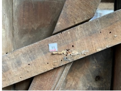
Resim 3.298. Taşkınpaşa Camii minberi yüzey birikintileri, toz ve kir / lekelenme detay fotoğrafı 6 (a) Fotoğraf makinesi çekimi (b) Optik Mikroskopta x50 büyüklükte detay görüntüsü (c) Optik Mikroskopta x200 büyüklükte detay görüntüsü.
