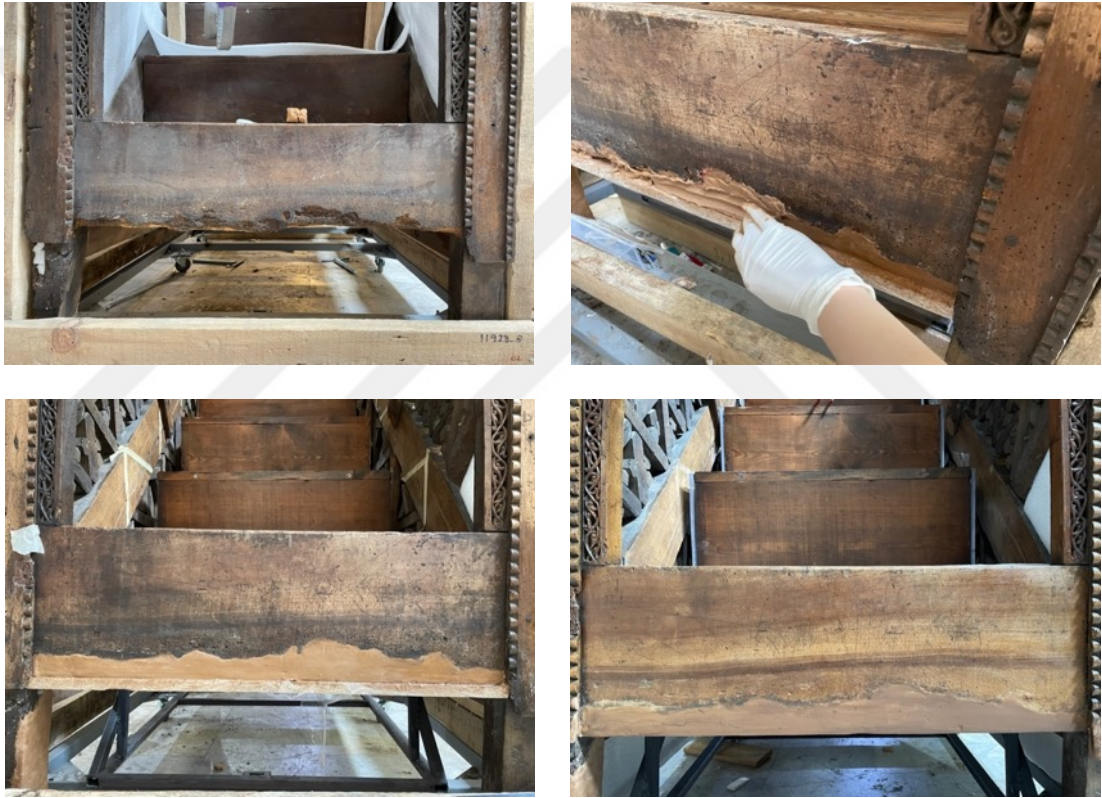
Resim 3.412. Taşkınpaşa Camii minberi kapı kanatları parça tamamlama işlem görüntüleri 1.
