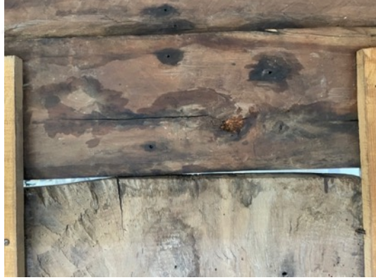
Resim 3.51. Taşkınpaşa Camii mihrabı süslemeli yüzeyde meydana gelen kırılma örneği detayları- 3.
