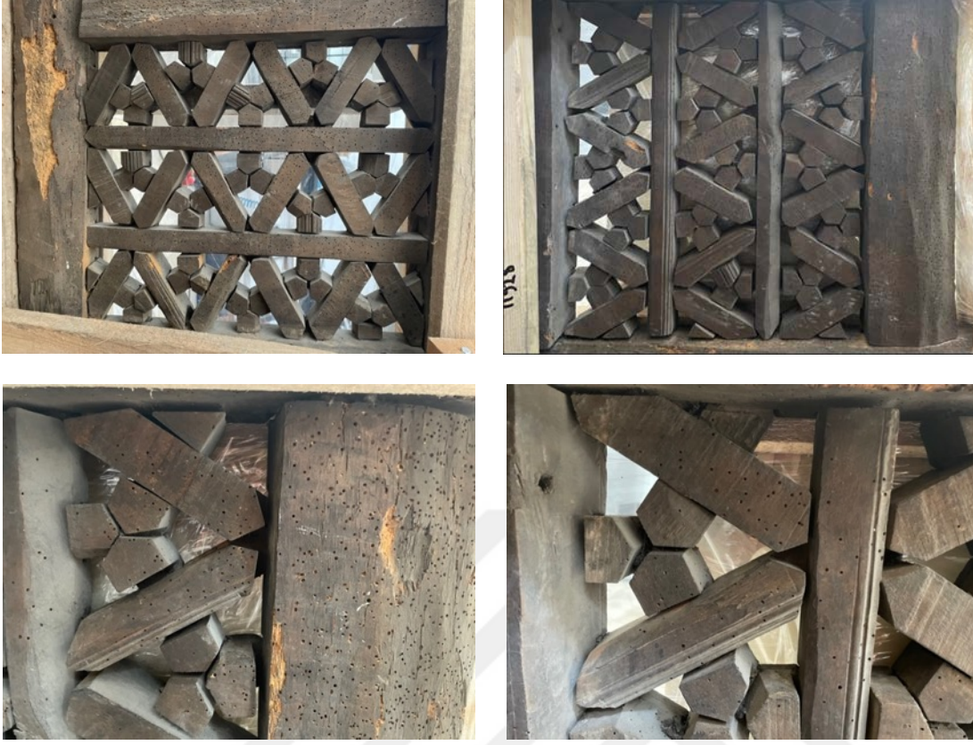
Resim 3.251. Taşkınpaşa Camii minberi köşk korkuluk kısmı parçalarında oynama örnekleri.
