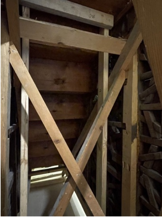
Resim 3.262. Taşkınpaşa Camii minberi eksen kayması ve gönye bozulma görüntüleri 2.
