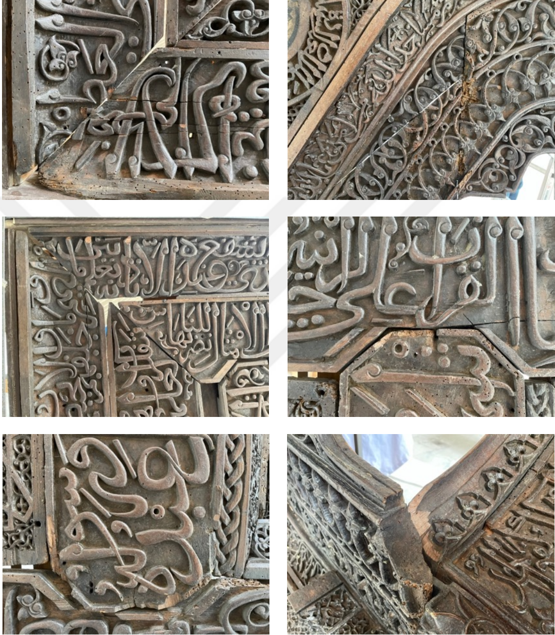
Resim 3.66. Taşkınpaşa Camii mihrabı köşe bağlantı yerlerinden ayrılma örnekleri.
