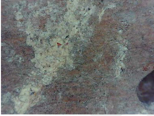
Resim 3.305. Taşkınpaşa Camii minberi yüzey birikintileri, toz ve kir / lekelenme detay fotoğrafı 13 (a) Fotoğraf makinesi çekimi (b) Optik Mikroskopta x50 büyüklükte detay görüntüsü (c) Optik Mikroskopta x200 büyüklükte detay görüntüsü.
