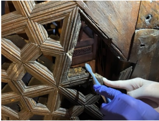
Resim 3.435. Taşkınpaşa Camii minberi müze nakil sonrası parça tamamlama işlem görüntüleri 5.
