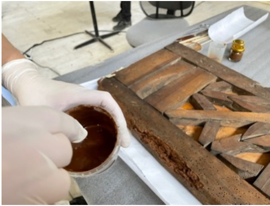
Resim 3.407. Taşkınpaşa Camii minberi kapı kanatları sağlamlaştırma işlem görüntüleri 3.
