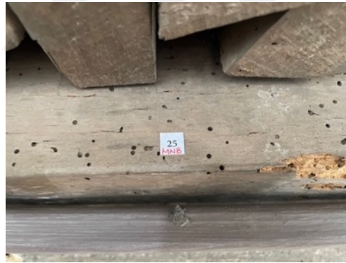
Resim 3.325. Taşkınpaşa Camii minberi böceklenme ve böcek uçuş delikleri detay fotoğrafı 7 (a) Fotoğraf makinesi çekimi (b) Optik Mikroskopta x50 büyüklükte detay görüntüsü (c) Optik Mikroskopta x200 büyüklükte detay görüntüsü.
