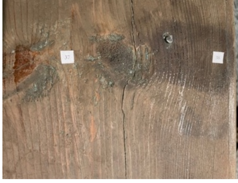
Resim 3.595. Gazanfer Ağa Camii vaaz kürsüsü rahle kısmında oluşan çatlama ve ayrılma örneği detayı.
