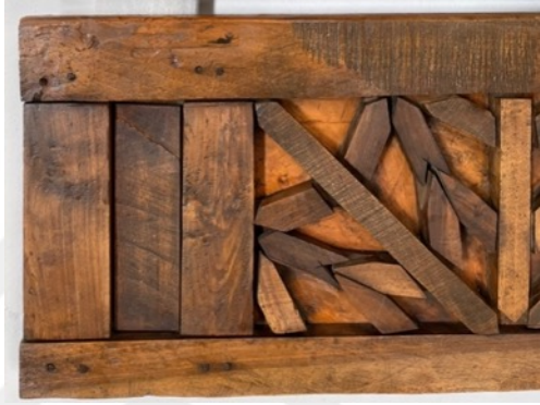
Resim 3.422. Taşkınpaşa Camii minberi kapı kanatları parça tamamlama işlem görüntüleri 2. (a, c) İşlem öncesi görüntüleri, (b, d) İşlem sonrası görüntüleri.
