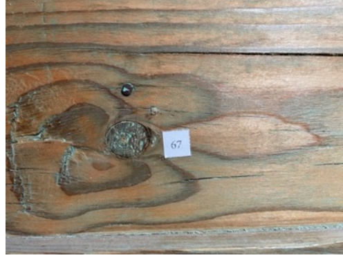
Resim 3.585. Gazanfer Ağa Camii vaaz kürsüsü arka yüzünde budak kaynaklı oluşan bozulma örneği detayı.
