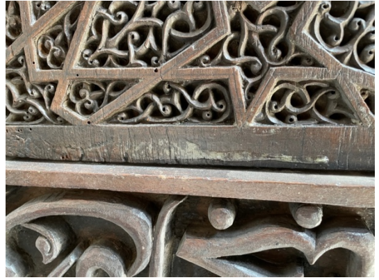
Resim 3.80. Taşkınpaşa Camii mihrabı koruyucu katmanda tabakalaşma/ayırışma örnekleri 2.
