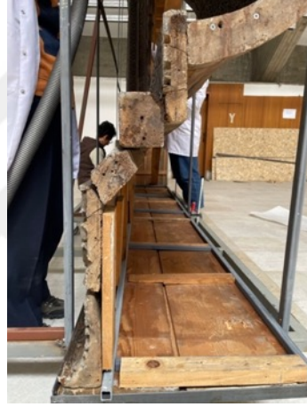
Resim 3.162. Taşkınpaşa Camii mihrabı yüzeyinden kimyasal boya kaldırma işlem görüntüleri 9.
