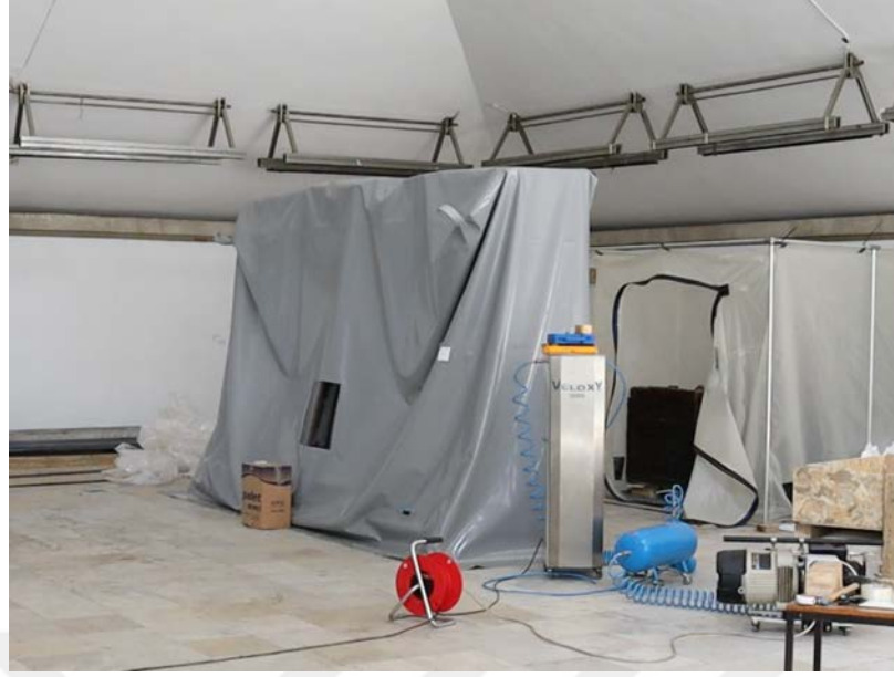
Resim 3.148. Taşkınpaşa Camii mihrabı ön yüzeyi azot çadırı işlem görüntüsü.
