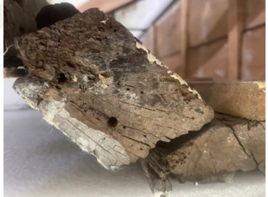
Resim 3.54. Taşkınpaşa Camii mihrabı alt kısmında meydana gelen kırılma örneğı detayları.
