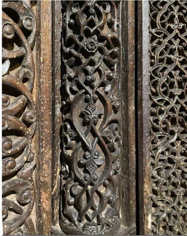
Resim 3.32. Taşkınpaşa Camii mihrabı sütünce detayı.
