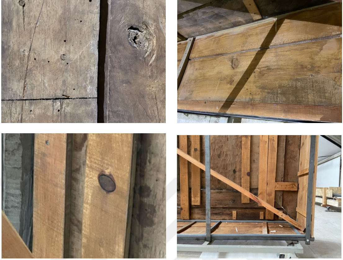
Resim 3.47. Taşkınpaşa Camii mihrabı yüzeyinde budaklı ahşap kullanımı.
