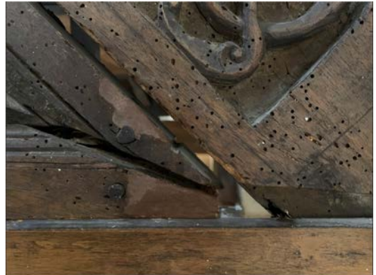
Resim 3.415. Taşkınpaşa Camii minberi parça tamamlama işlem görüntüleri 4.
