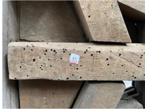
Resim 3.321. Taşkınpaşa Camii minberi böceklenme ve böcek uçuş delikleri detay fotoğrafı 3 (a) Fotoğraf makinesi çekimi (b) Optik Mikroskopta x50 büyüklükte detay görüntüsü (c) Optik Mikroskopta x200 büyüklükte detay görüntüsü.
