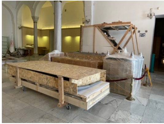
Resim 3.365. Taşkınpaşa Camii minberi geçici önleyici koruma örnekleri 8.
