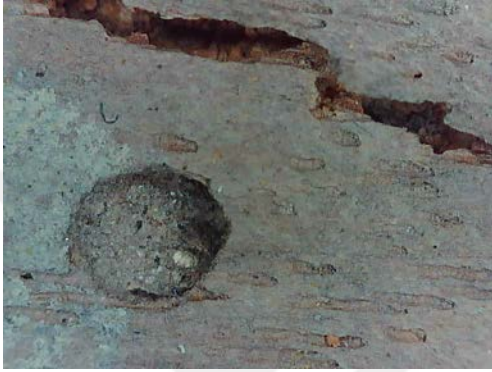
Resim 3.327. Taşkınpaşa Camii minberi böceklenme ve böcek uçuş delikleri detay fotoğrafı 9 (a) Fotoğraf makinesi çekimi (b) Optik Mikroskopta x50 büyüklükte detay görüntüsü (c) Optik Mikroskopta x200 büyüklükte detay görüntüsü.
