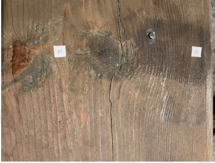
Resim 3.581. Gazanfer Ağa Camii vaaz kürsüsü rahle kısmında budak kaynaklı oluşan bozulma örneği 1.
