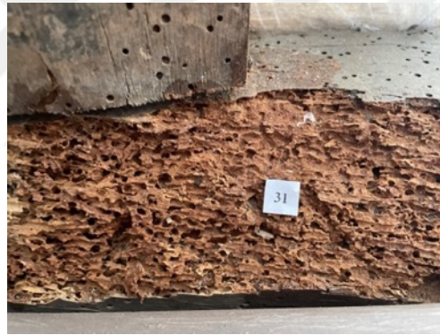
Resim 3.329. Taşkınpaşa Camii minberi böceklenme ve böcek uçuş delikleri detay fotoğrafı 11 (a) Fotoğraf makinesi çekimi (b) Optik Mikroskopta x50 büyüklükte detay görüntüsü (c, d) Optik Mikroskopta x200 büyüklükte detay görüntüsü.
