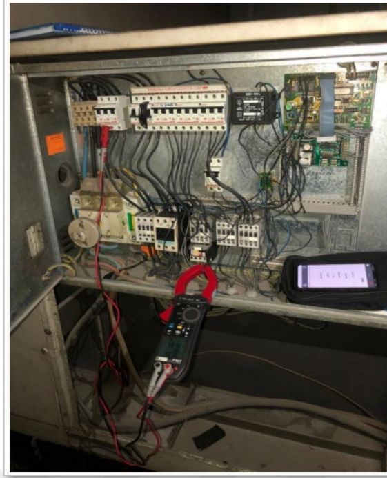
Şekil 3.10. Pompa/Motor Sistemlerinin Ölçüm Yöntemi
