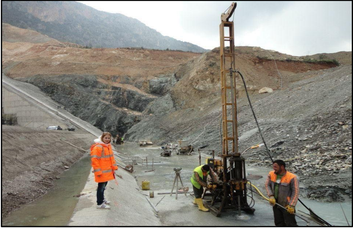
Şekil 4.6. Pamukluk Barajı'nda talveg ve sağ sahildeki topuk plağı betonunu basınçlı su testi ve enjeksiyon uygulaması
