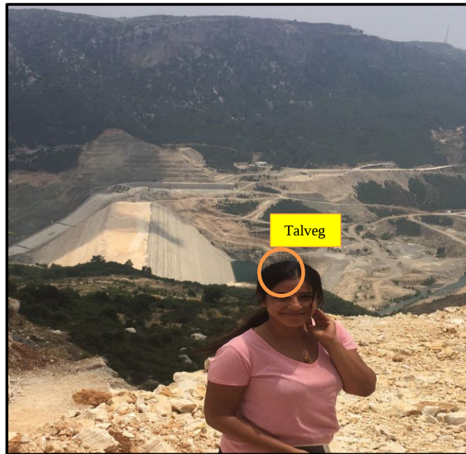
Şekil 1.1. Pamukluk Barajı 2018 yılı talvegdeki su birikintisi
