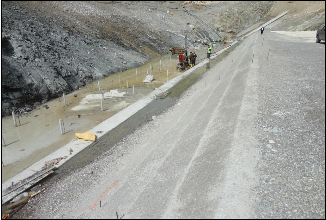
Şekil 4.7. Pamukluk Barajı'nda talveg ve sol sahildeki topuk plağı betonunu basınçlı su testi ve enjeksiyon uygulaması
