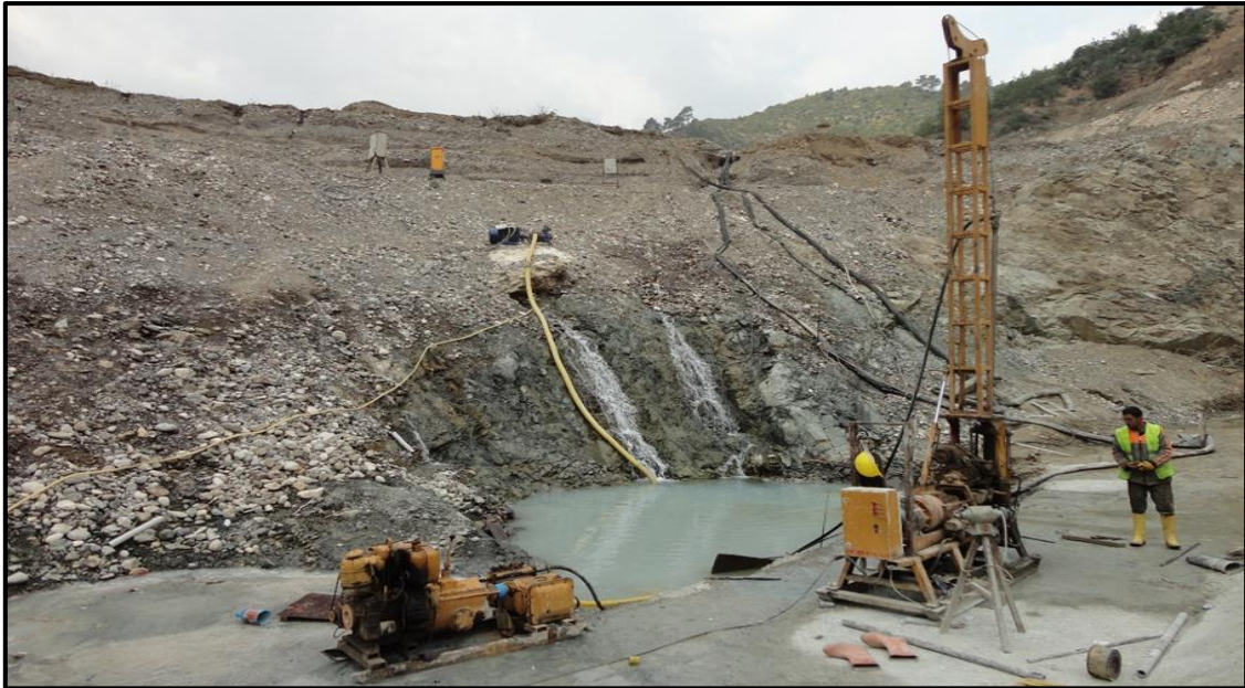
Şekil 4.4. Pamukluk Barajı'nda talvegteki suyun pompalar yardımı ile çekilmesi
