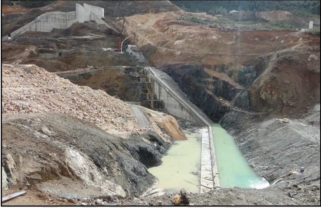
Şekil 4.3. Pamukluk Barajı topuk plağı betonu dökümü
