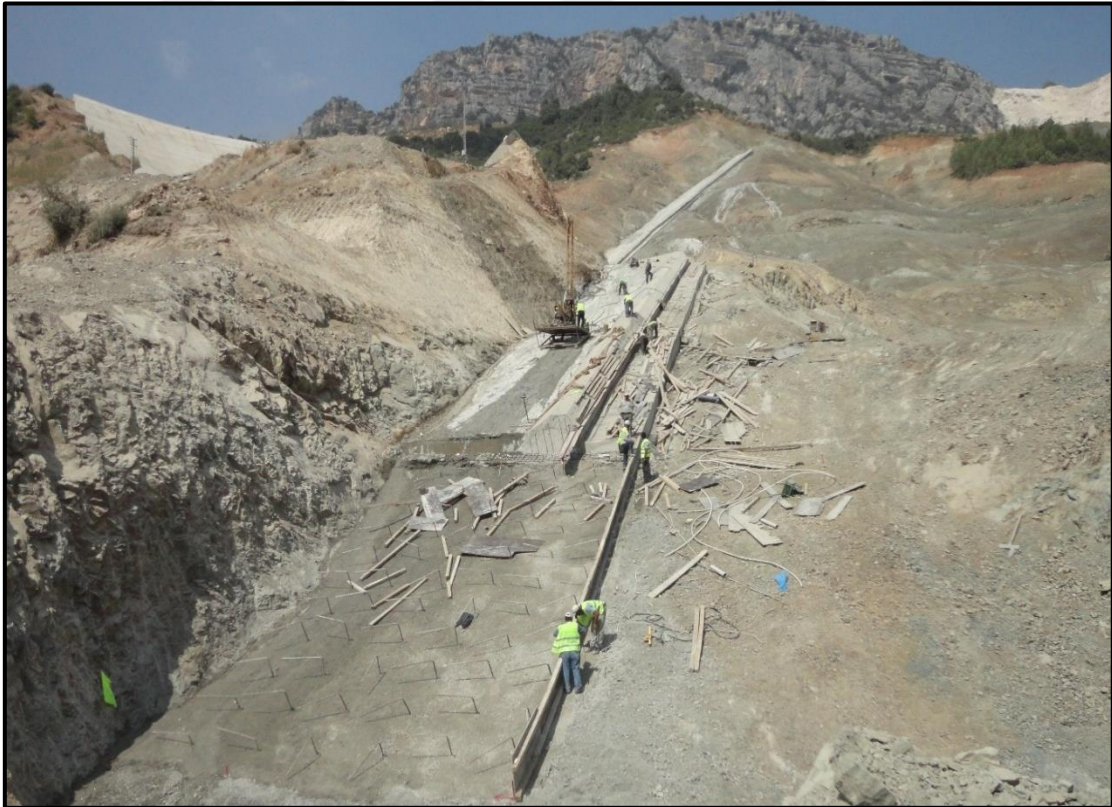
Şekil 3.6. Pamukluk Barajı sağ sahilde topuk plağı beton dökümü için hazırlanan ankraj ve kalıp görünümü
