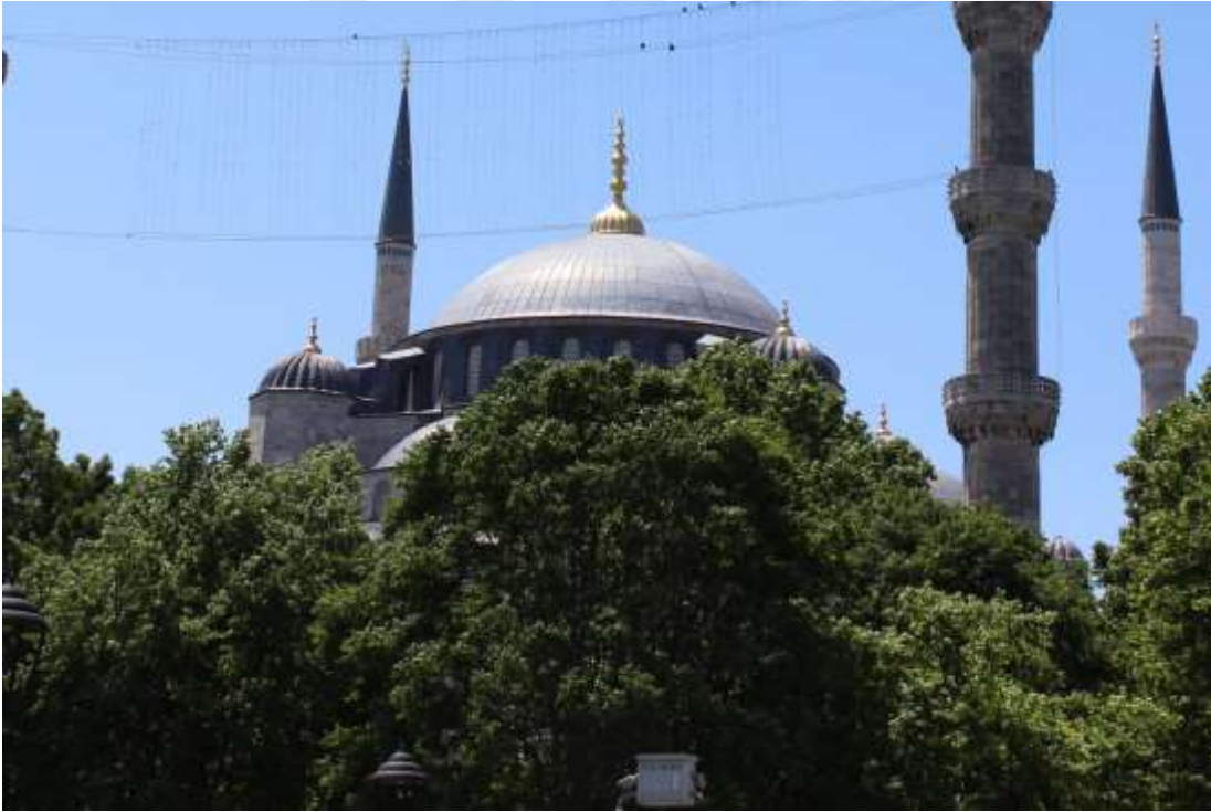
Şekil 5.3.1.10 : Yeni Camii üst örtü detay.
