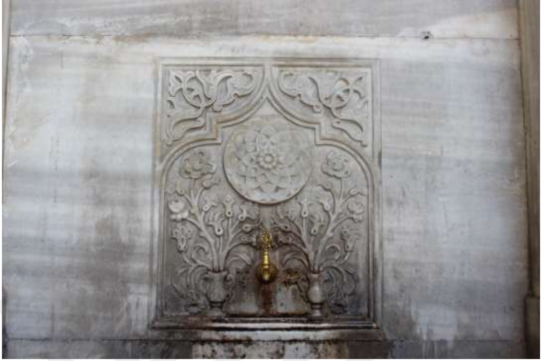
Şekil 5.6.3 : Yeni Camii çeşmesi, ayna taşı detayı.
