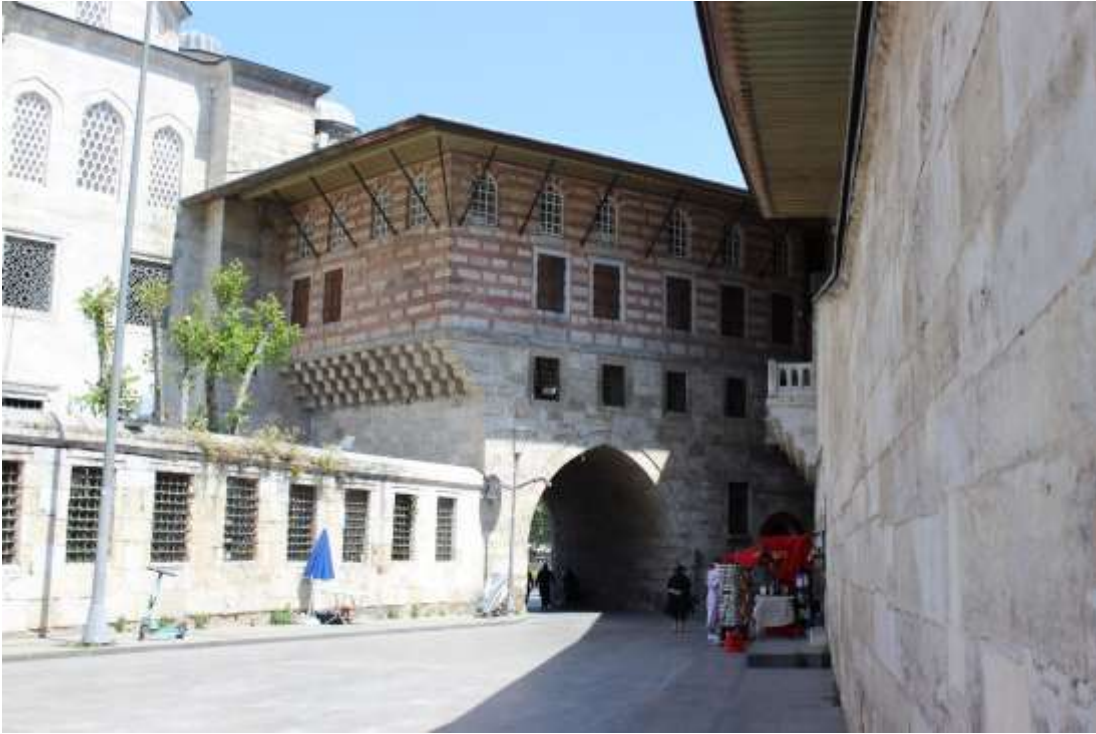
Şekil 5.3.1.6 : Yeni Camii Hünkâr Kasrı.
