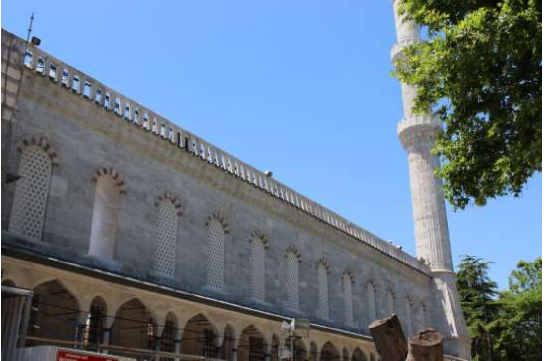
Şekil 5.3.1.11 : Sultan Ahmed Camii avlu cephesi.
