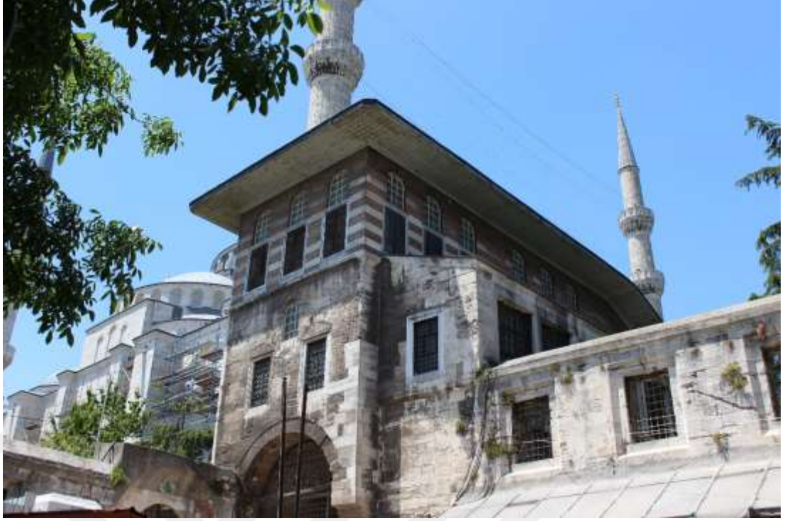
Şekil 5.3.1.3 : Sultan Ahmed Camii Hünkâr Kasrı.
