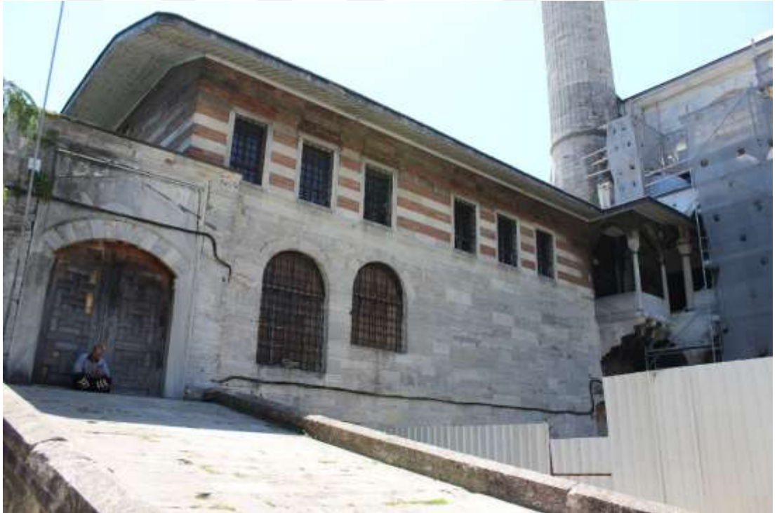
Şekil 5.3.1.4 : Sultan Ahmed Camii Hünkâr Kasrı.
