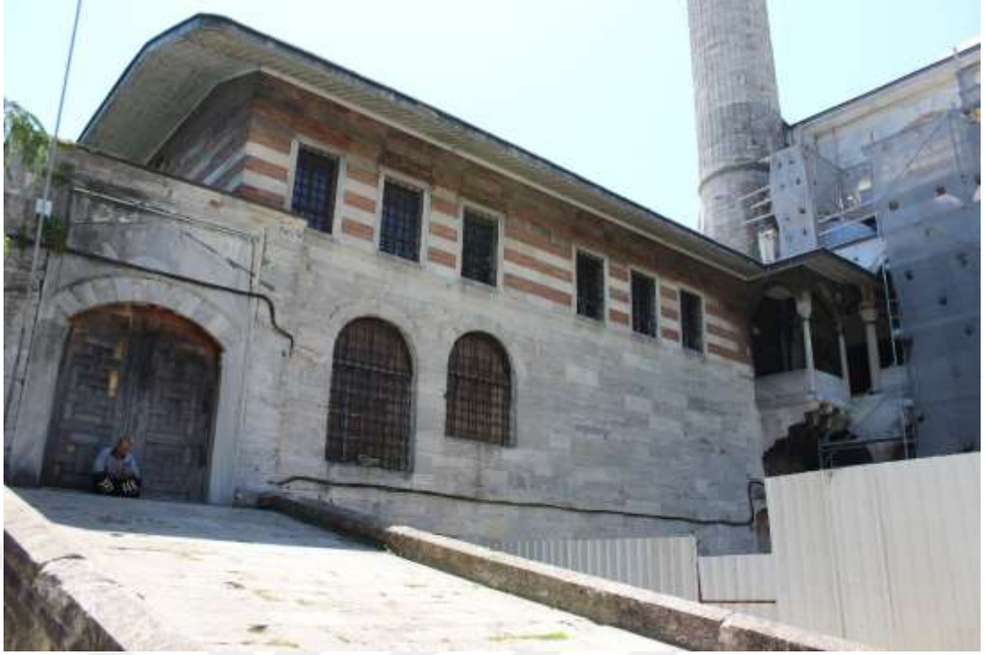
Şekil 5.7.5 : Sultan Ahmed Camii Hünkâr Kasrı.
