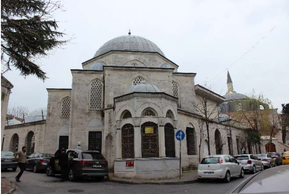
Şekil 5.3.2.5 : Bayram Paşa Türbesi.
