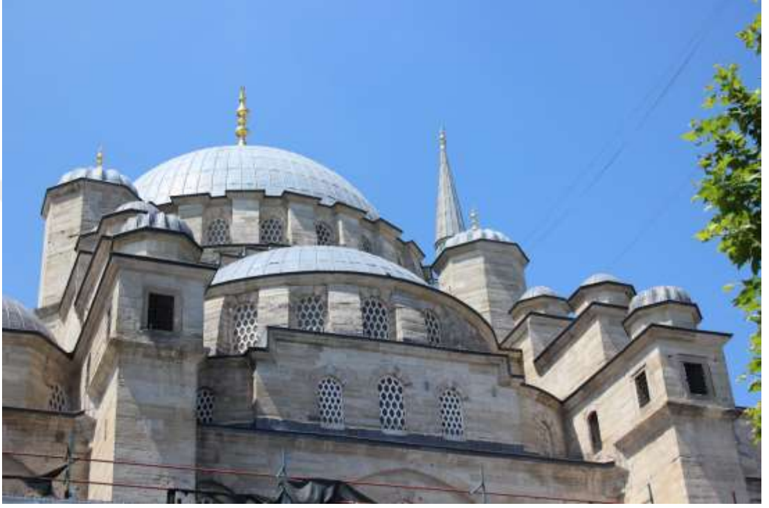
Şekil 5.3.1.8 : Yeni Camii üst örtü detay.
