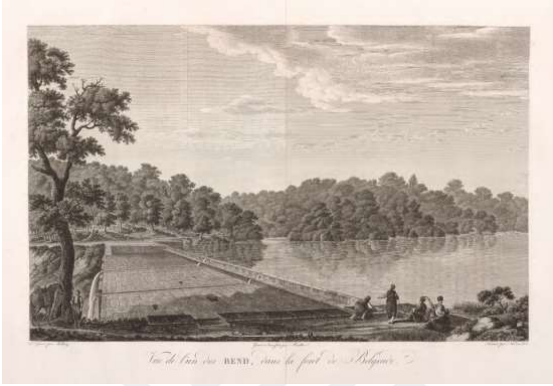
Şekil 5.6.20 : Sultan II. Osman Bendi'nin menba yönünden betimlemesi (Melling, Paris 1819).
