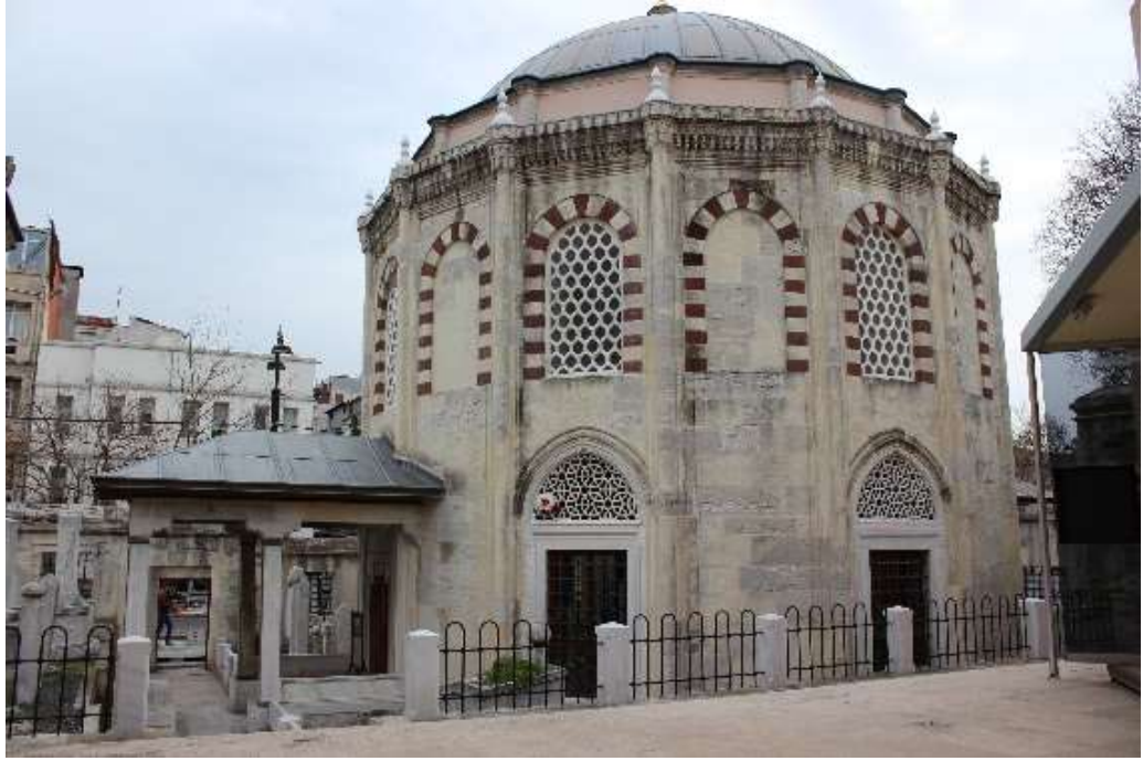
Şekil 5.3.2.2 : Koca Sinan Paşa Türbesi.
