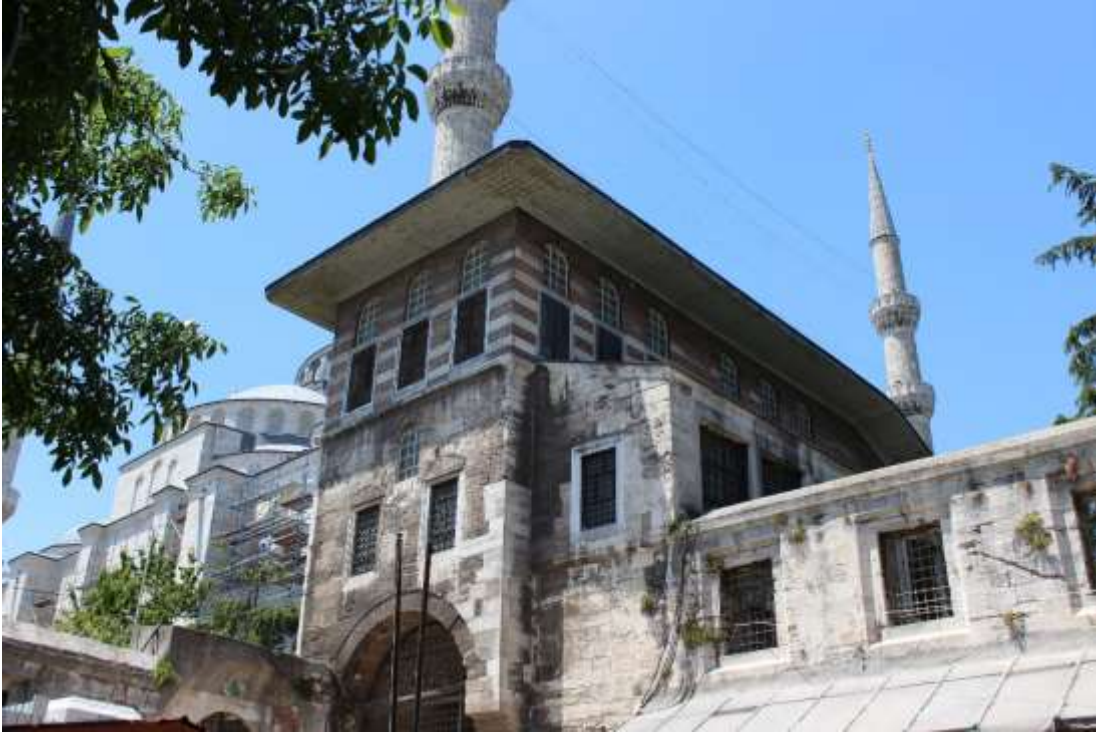
Şekil 5.7.4 : Sultan Ahmed Camii Hünkâr Kasrı.
