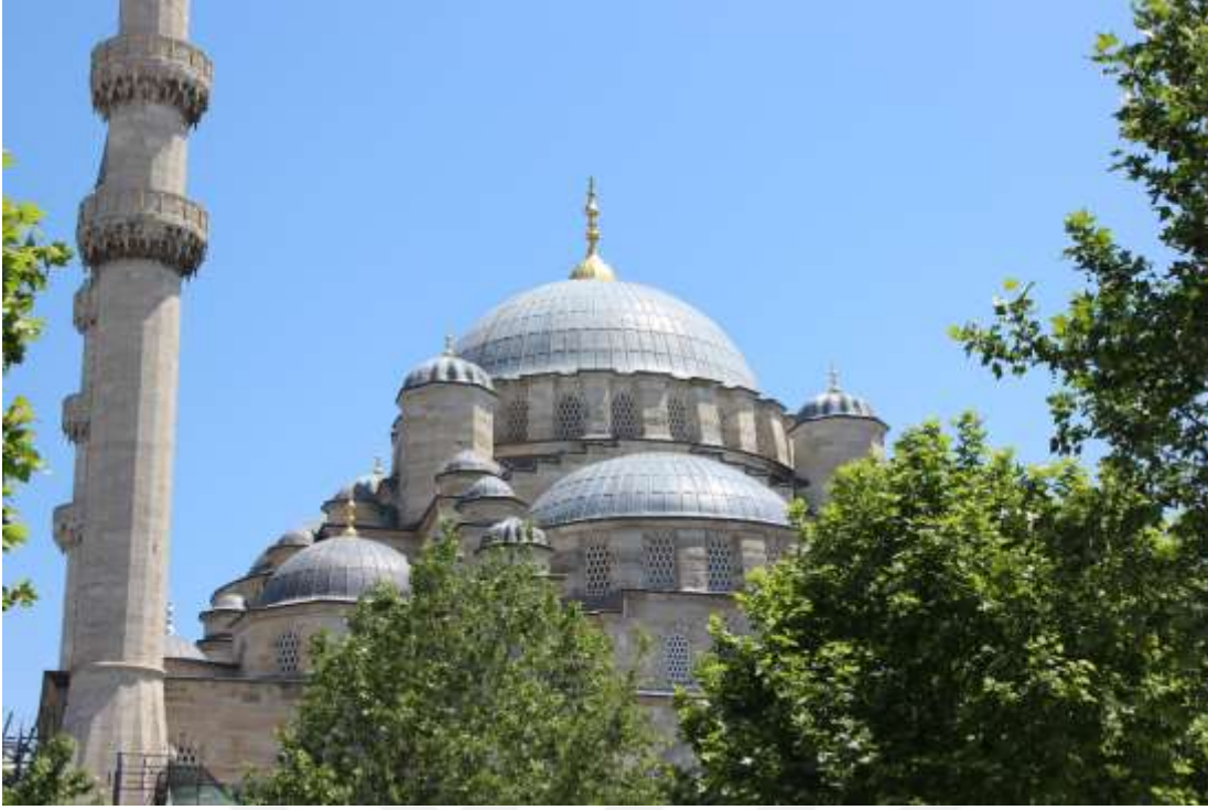
Şekil 5.3.1.9 : Yeni Camii üst örtü detay.
