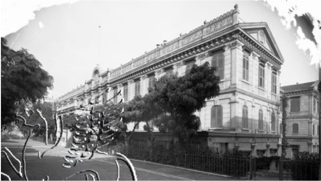
Şekil 4.65 Fransız Elçiliği Batı ve Güney Cephesi (D-DAI-IST-9745)
