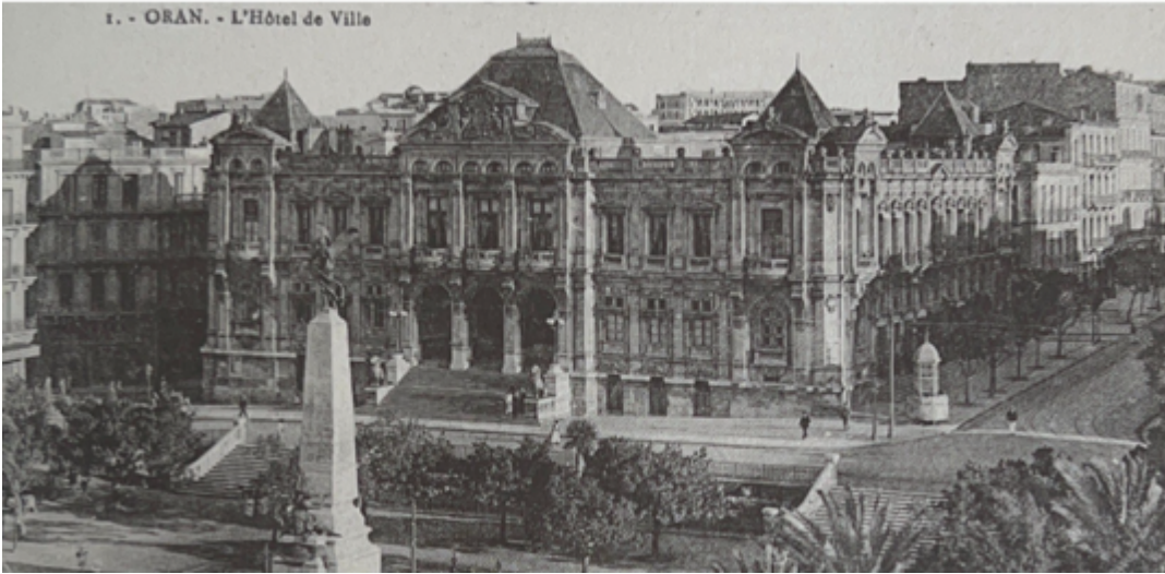
Şekil 3.20 Oran Belediye Hükümet Konağı (Çelik, 2012: 244)
