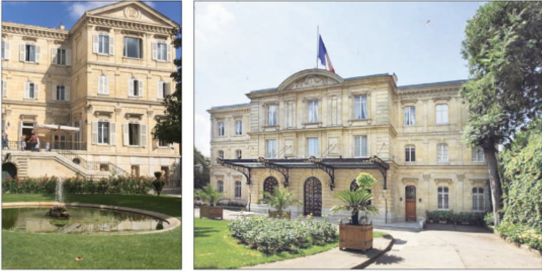
Şekil 4.67 sol Fransa Sarayı Güney Cephesi (Onat, 2022), sağ Kuzey Cephesi (Sayiner, 2016)
