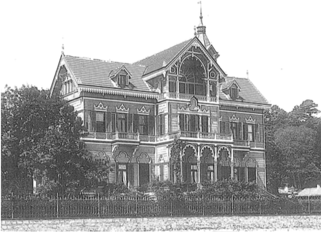
Şekil 4.132 Yazlık Elçilik Köşkü Boğaz Cephesi (Bachman, 2003: 61)
