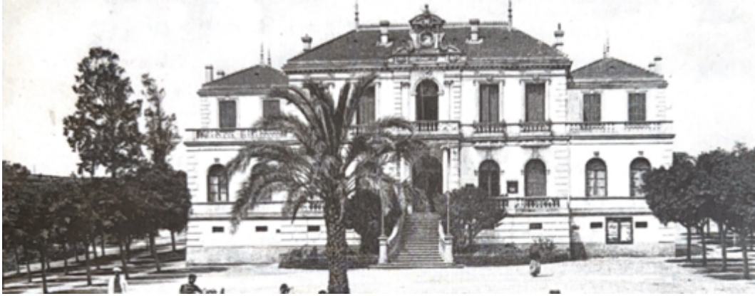
Şekil 3.22 Kolea Vilayet Binası (Çelik, 2012: 245)
