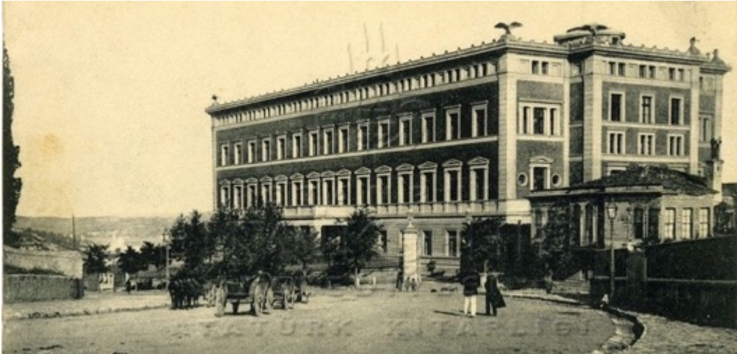
Şekil 4.126 Elçilik Binası Kuzey Cephesi (Marche, 2023)
