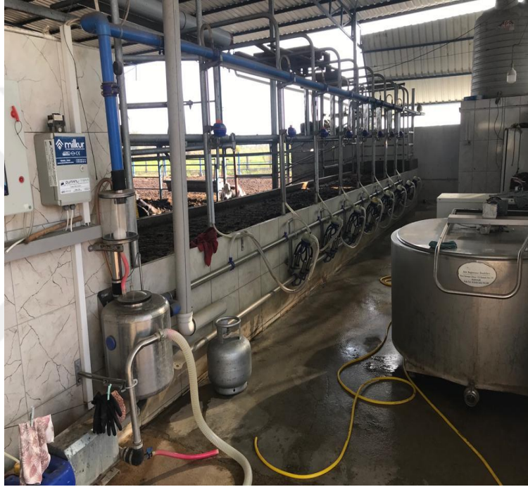
Resim 3.1. Çalışma alanından işletmelere ait bazı görüntüler
