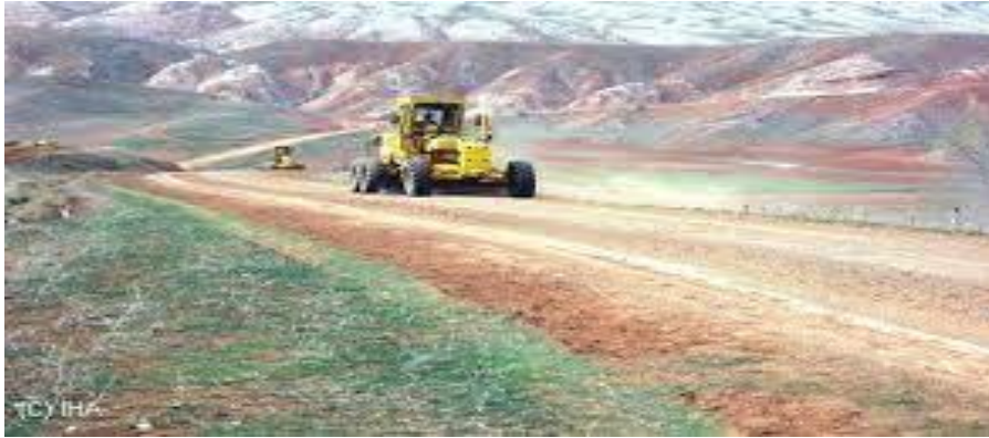
Resim 3.3 Reglaj işlemi devam eden yol güzergahı
