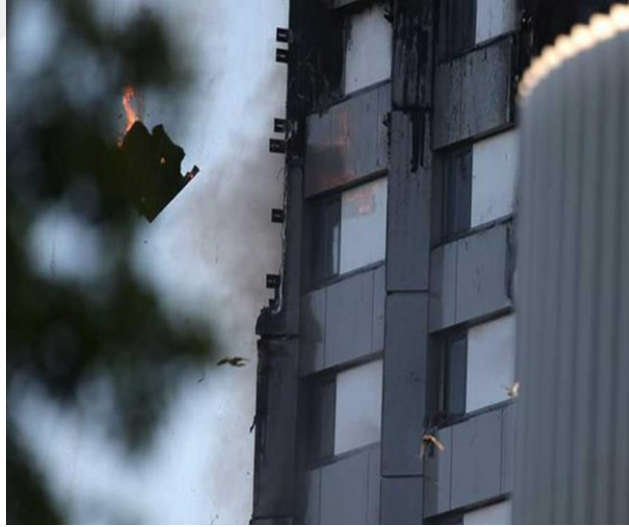
Şekil 15 Grenfell Tower Yangını (2)
