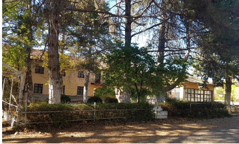
Fotoğraf 3.2. Hasanoğlan'da Köy Enstitüsü Adına İnşa Edilen İlk Bina ve Hasanoğlan'a Öğrenciler Tarafından Getirilen Suyun Aktığı İlk Çeşme
