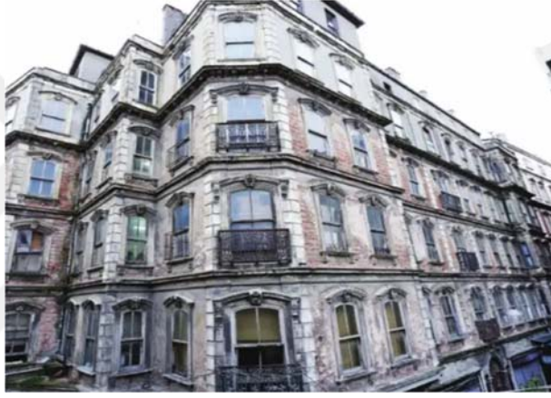
Resim 3.22 Barnathan Apartmanı, restorasyondan önceki cephe görünüşü (Oğuz,2016).
