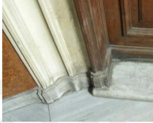
Resim 3.53 Botter Apartmanı, süpürgelik- kapı birleşim detayı (Yenigün, 2011).
