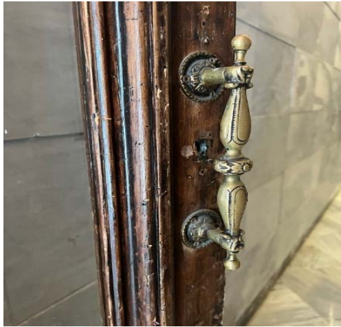
Resim 3.81 Ravouna Binası, koridor ara kapı kulp detayı (Erol, 2022).
