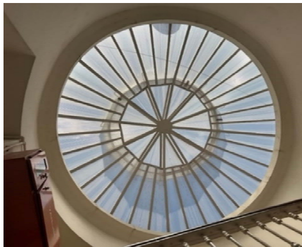
Resim 3.11 Hidiyyal Palas, demir strüktür cam çatı detayı (Erol, 2022).
