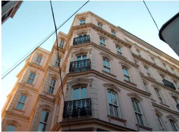
Resim 3.23 Barnathan Apartmanı, restorasyondan sonraki cephe görünüşü (Meroddi, 2021).
