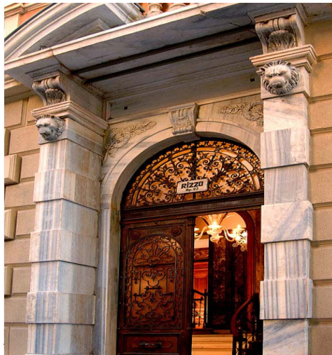
Resim 3.16 Rizzo Apartmanı, apartman girişi (Erol, 2022).
