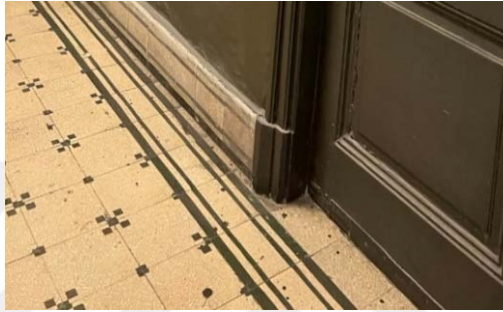
Resim 3.97 Mısır Apartmanı, mozaik zemin yüzeyi ve süpürgelik detayı (Erol, 2022).
