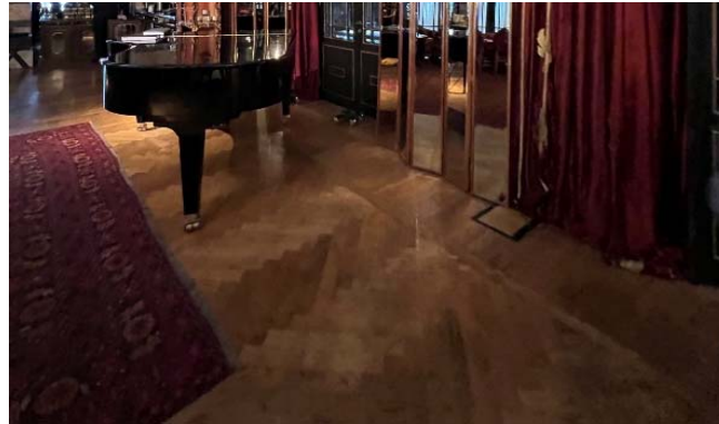
Resim 4.10 Kubbeli Salon, balıksırtı ahşap kaplama zemin yüzeyi (Erol, 2022).
