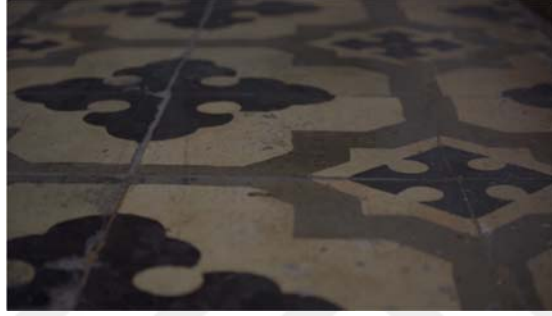
Resim 3.90 Papadopoulos Apartmanı, mozaik karo zemin kaplamaları (Erol, 2022).
