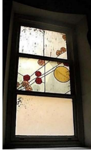
Resim 3.55 Botter Apartmanı, birinci ve ikinci kat arasındaki giyotin pencere – vitray detayı (Yenigün, 2011).
