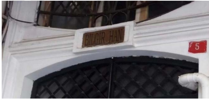
Resim 3.104 Bilgir Han, ana giriş kapısı üzeri metal çapraz örgü detayı (Erol, 2022).
