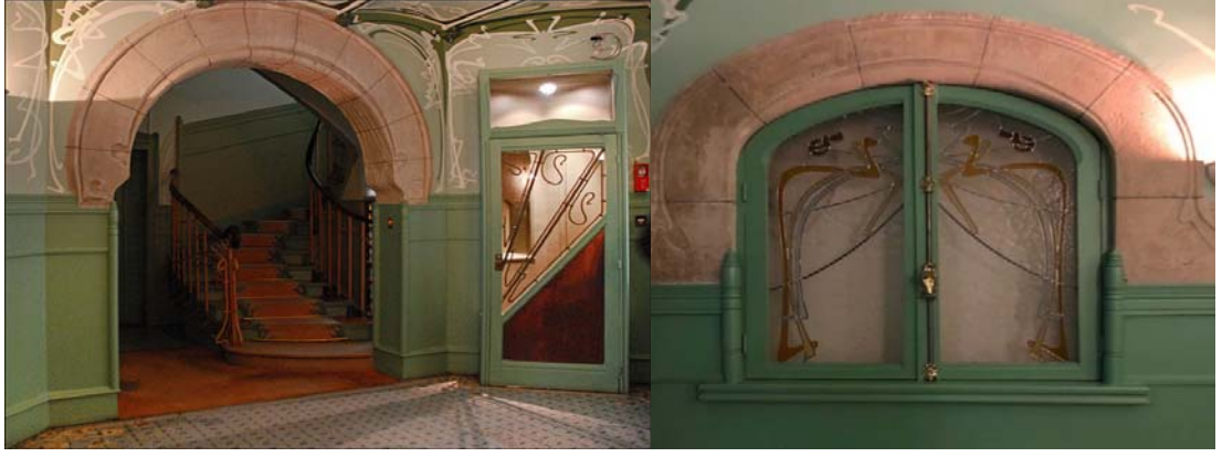
Resim 2.32 Castel Beranger, duvar yüzeyindeki ahşap lambri ve şablonlar, zemin yüzeyinde kullanılan ahşap ve mozaik malzeme, Hector Guimard, 1898, Paris (Flickr, 2006).
