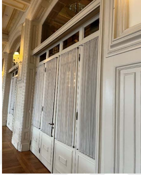
Resim 4.17 Pera Salonu, duvar yüzeyi (Erol, 2022).
