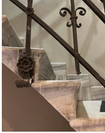
Resim 3.82 Ravouna Binası, demir korkuluk detayı (Erol, 2022).
