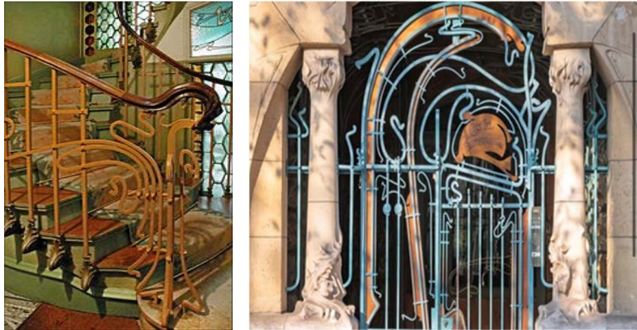
Resim 2.76 Castel Beranger, demirin merdiven ve kapıda kullanımı (Arthive, 2020).
