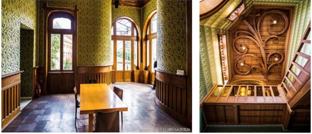
Resim 2.37 Villino Florio, duvar ve tavan yüzeylerinde ahşap kullanım, Ernesto Basile, 1902, Palermo (Duca, 2016).
