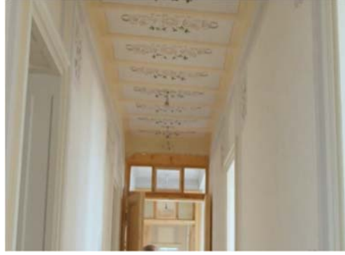
Resim 3.32 Barnathan Apartmanı, tepe penceresi (Oğuz, 2016).
