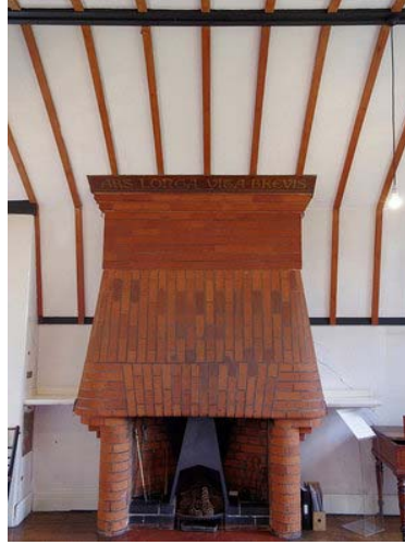
Resim 2.20 Red House, iç mekân duvar yüzeylerindeki ahşap çıta detayları ve tuğla şömine (Harkness, 2015).
