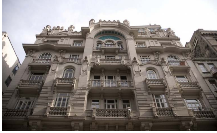
Resim 3.92 Mısır Apartmanı, ön cephe görünüşü (Kandıracıoğlu, 2020).
