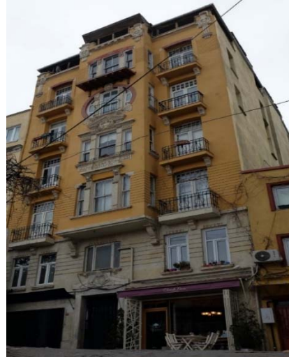
Resim 3.85 Papadopoulos Apartmanı, cephe görünüşü (Ender, 2016).
