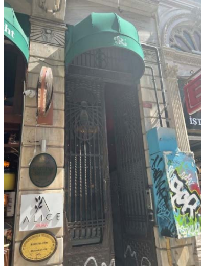
Resim 3.78 Ravouna Binası, demir apartman kapısı (Erol, 2022).
