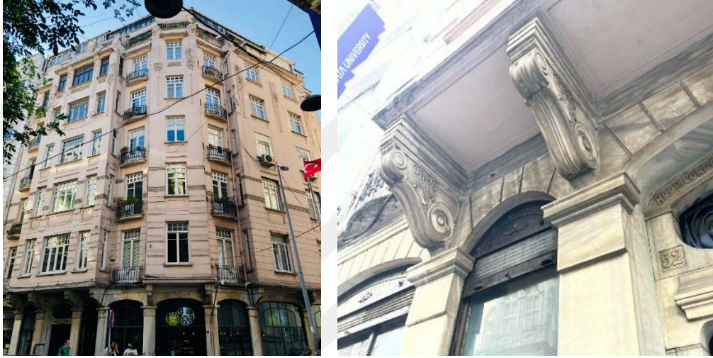
Resim 3.113 Cordova Apartmanı, cephe görünüşü ve giriş kapısı (Erol, 2022).
