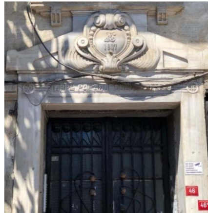
Resim 3.86 Papadopoulos Apartmanı, apartman girişi (Erol, 2022).
