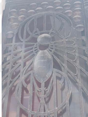
Resim 3.79 Ravouna Binası, demir apartman kapısı kelebek detayı (Erol, 2022).
