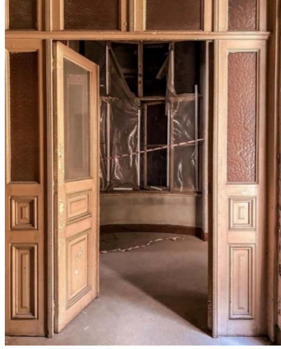
Resim 3.57 Botter Apartmanı, daire içerisindeki çift kanatlı ve tepe pencereli ahşap kapı (Yüksel, 2022).
