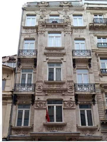
Resim 3.76 Ravouna Binası, cephe görünüşü (Erol, 2022).
