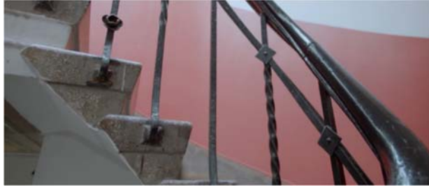
Resim 3.91 Papadopoulos Apartmanı merdiven korkuluk detayı (Erol, 2022).
