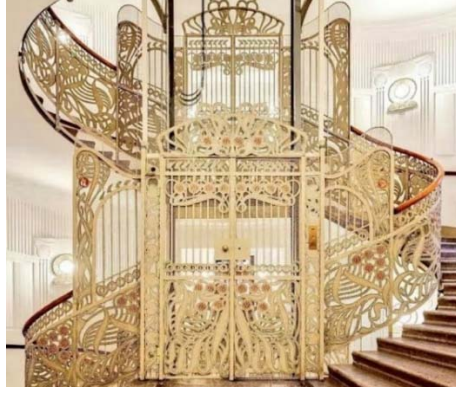
Resim 2.80 Majolica House, demir merdiven korkuluğu ve asansör kafesi, Otto Wagner, 1899, Viyana (Marcijus, 2020).
