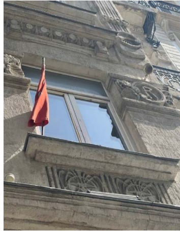
Resim 3.77 Ravouna Binası, ailenin baş harflerinin cephedeki görünüşü (Erol, 2022).
