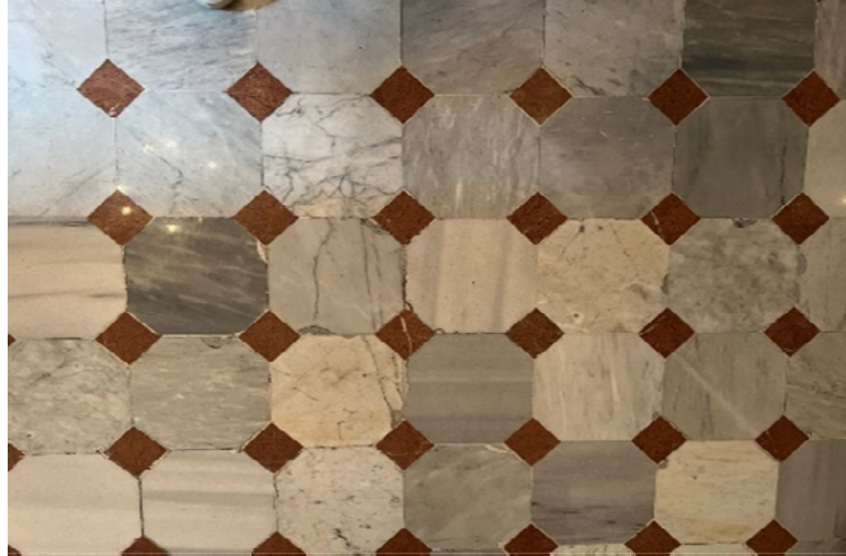
Resim 4.1 Giriş Holü, mermer zemin malzemesi (Erol, 2022).
