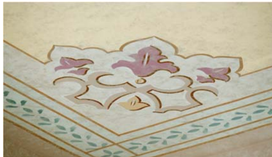
Resim 3.29 Barnathan Apartmanı, duvar ve tavan yüzeylerindeki el çizimleri (Oğuz, 2016).
