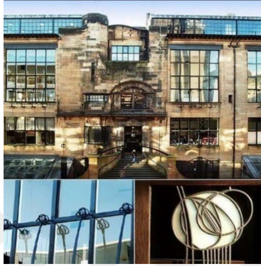
Resim 2.70 Glasgow School, dış mekânda kullanılan demir malzeme, Glasgow (Taylor, 2018).
