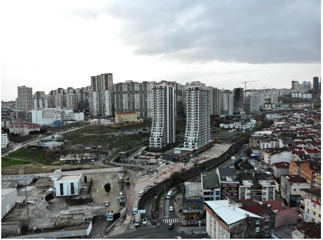
Şekil 4.24: İstanbul, Esenyurt merkez drone ile genel görünümü
