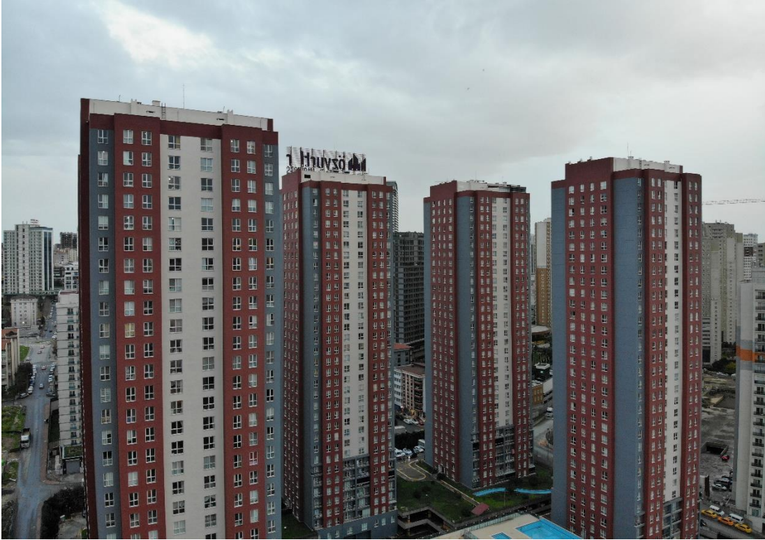
Şekil 4.16: İstanbul’da konut inşaat ölçeği ve sunduğu ilişkiler, Özyurtlar İnşaat, N Towers, Drone çekimi.
