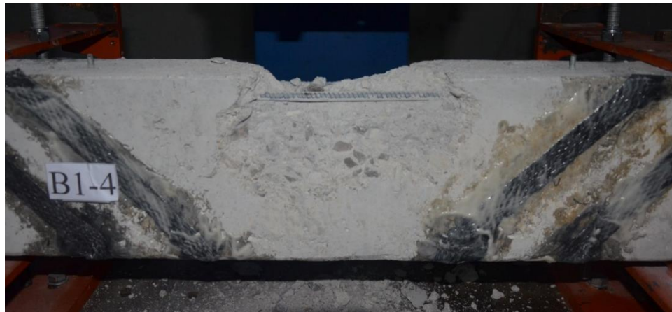
Şekil 4.30. B1-4 deney elemanında oluşan göçme hasar durumu
