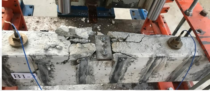
Şekil 4.22. B1-3 deney elemanında oluşan göçme hasar durumu
