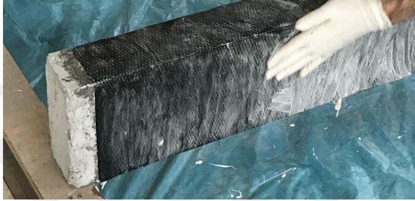
Şekil 3.36. CFRP kumaşların epoksi ile yapıştırılma işlemi
