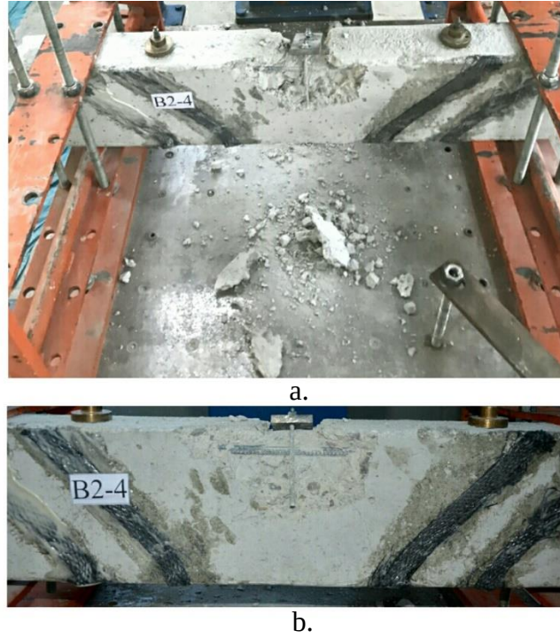
Şekil 4.86. B2-4 deney elemanında oluşan göçme hasar durumu
