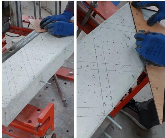
Şekil 3.33. CFRP'nin yapıştırılacağı bölgelere çizim yapılması
