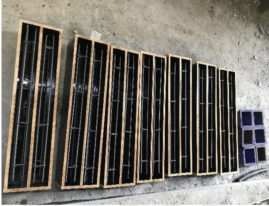
Şekil 3.17. Beton dökümü öncesi kalıp ve donatı görünümü
