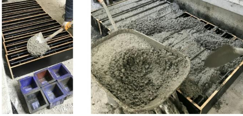
Şekil 3.18. Beton döküm işlemi
