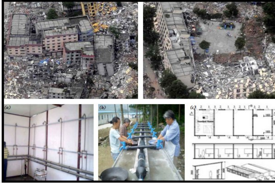
Şekil 1.5. Çin'in Wensuhan Depreminden sonraki görünümü ve alınan geçici önlemler (Kalkan ve ark, 2020).
