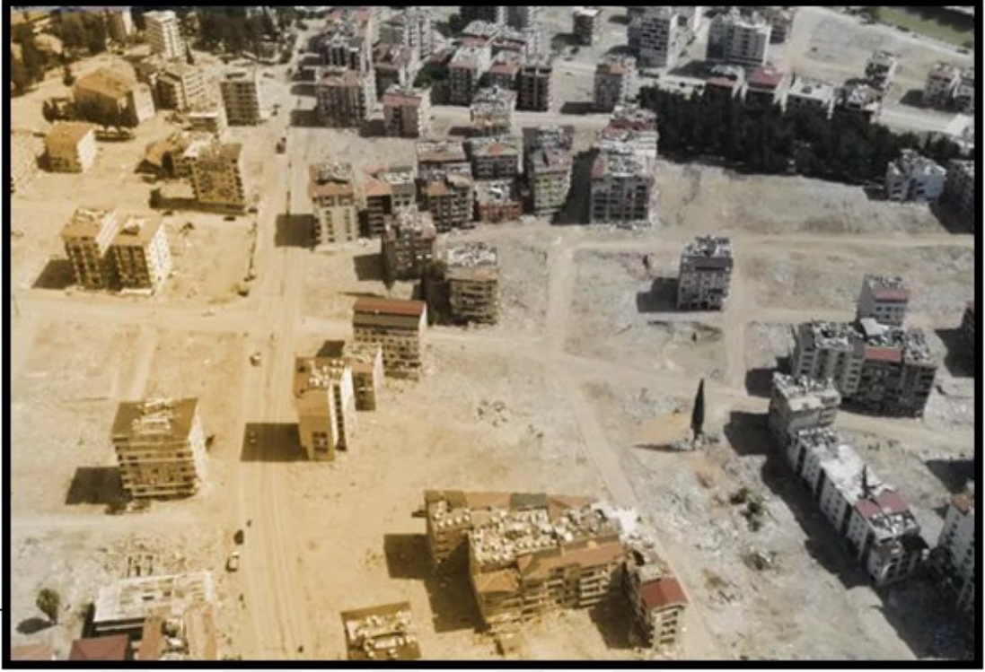
Şekil 3.4. Yıkılan Binalar kaldırıldı (Mynet,2023).
