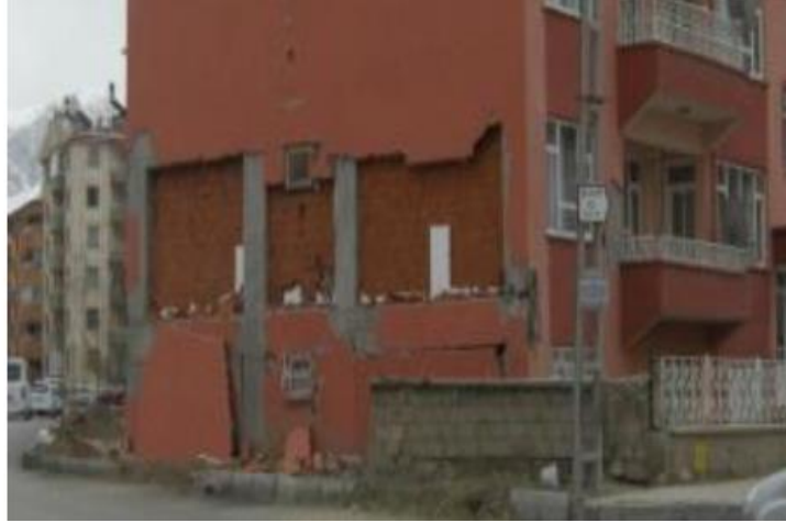
Şekil 3.4. Taşıyıcı Olmayan Yapı Elemanlarını Kullanımı
