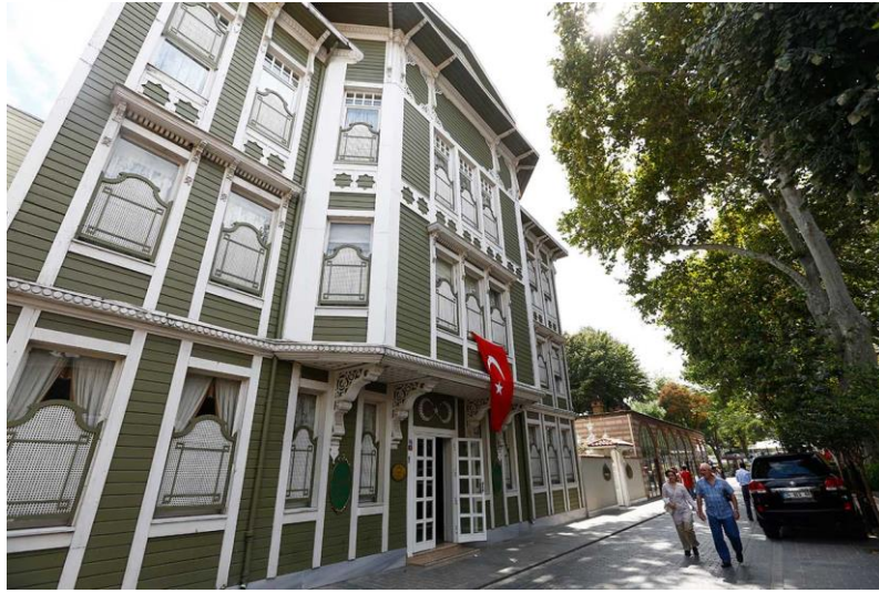
Şekil 30. Yeşil Ev İstanbul (Turing, 2020)
