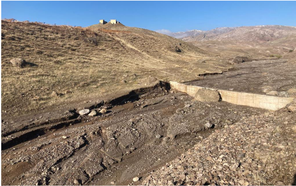
Şekil 5.52. Akarsuların akışını yavaşlatmak için bentler kurulmuştur (Beydoğmuş)
