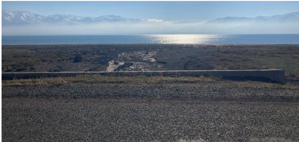
Şekil 5.60. Ulaşım sağlanması amacıyla akarsular üzerinde köprüler yapılmış suların Keban Barajı Gölüne ulaşması amaçlanmıştır (Kıraç).
