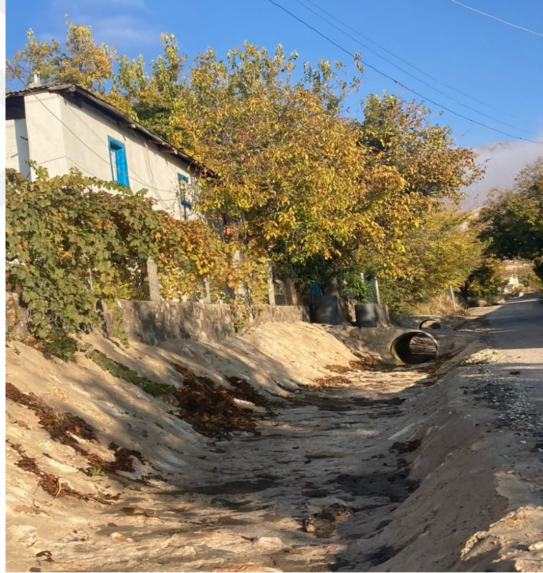
Şekil 5.49. Yerleşim alanlarını sel ve taşkınlardan korumak için yapılan yapay dere yatakları (Kıraç)
