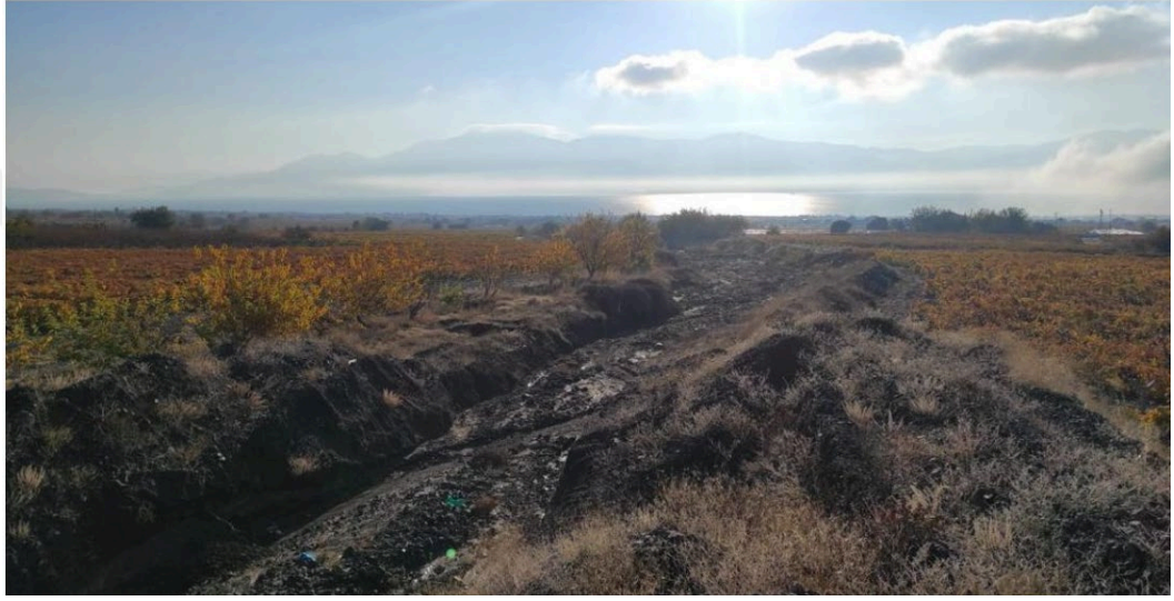
Şekil 5.61. Taşkınlar ile Keban Barajı Gölü kıyısında biriken sedimentler ile tarım alanları olarak kullanılmaktadır (Kıraç)
