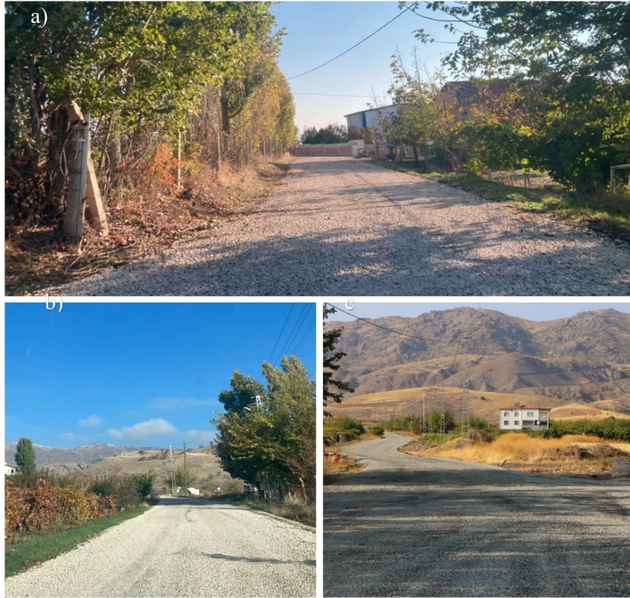
Şekil 5.55. Çalışma sahasındaki köy yolları a)Beydoğmuş b) Beydoğmuş c)Hoşköy
