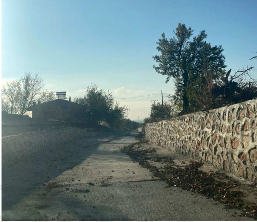
Şekil 5.51. Dere yataklarında ulaşım amacıyla açılması ve taşkınların yolları kapatmaması için duvar örülmesi (Kıraç)
