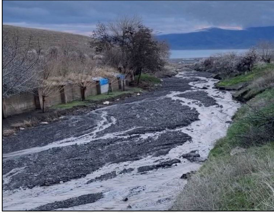
Şekil 5.21. Hoşköy’de genişletilmiş dere yatağından bir görünüm
