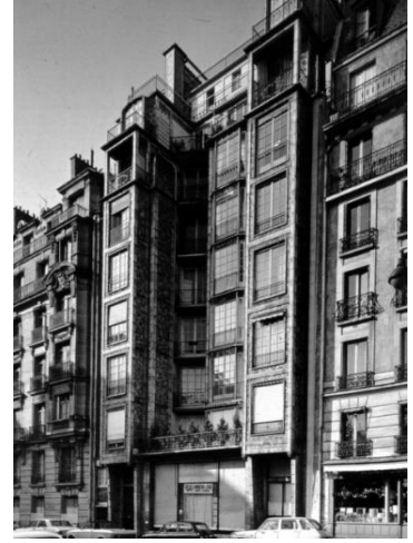
Resim 2.4: Auguste Perret, Franklin Caddesi Apartman Fotoğrafi, Paris, 1903.
