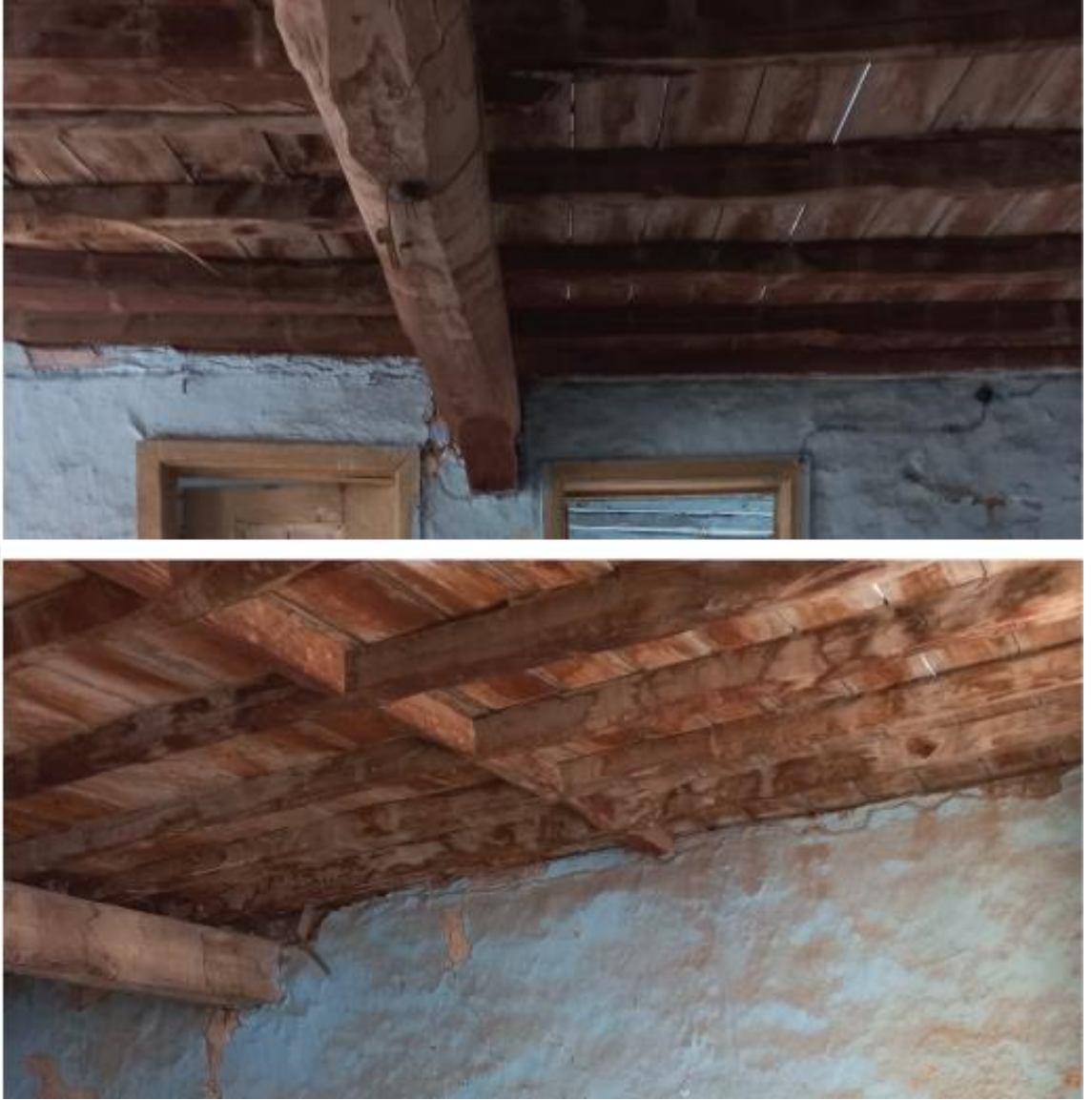
Şekil 3.15. Eşrefzade Mahallesi, 5 ada, 17 parseldeki konutun ahşap kirişleri
