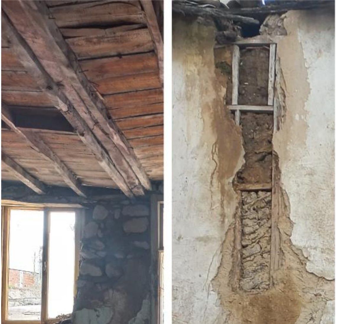
Şekil 3.33. Eşrefzade Mahallesi, 5 ada, 17 parselde bulunan yapıda gözlemlenen yapı onarımları
