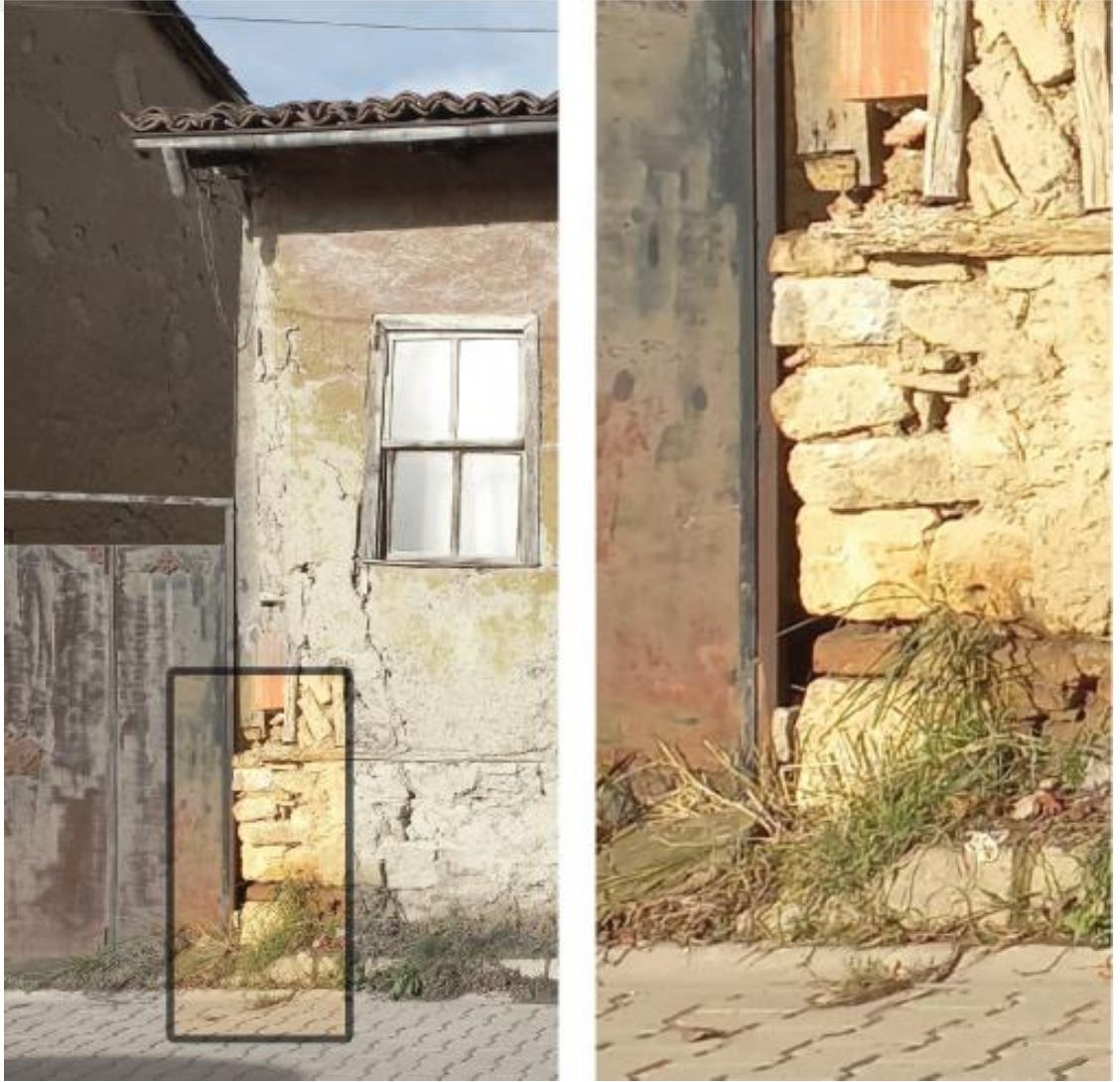
Şekil 3.14. Geleneksel İznik konutlarında moloz taşlı yığma duvar iççiliği ve köşe detayları
