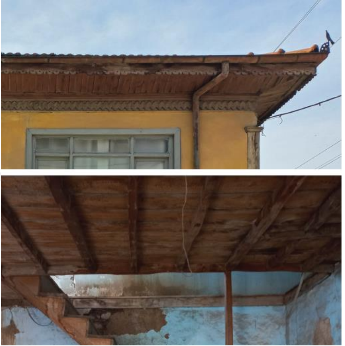
Şekil 3.12. Geleneksel İzmir konutlarında ahşap malzeme kullanımı (2)
