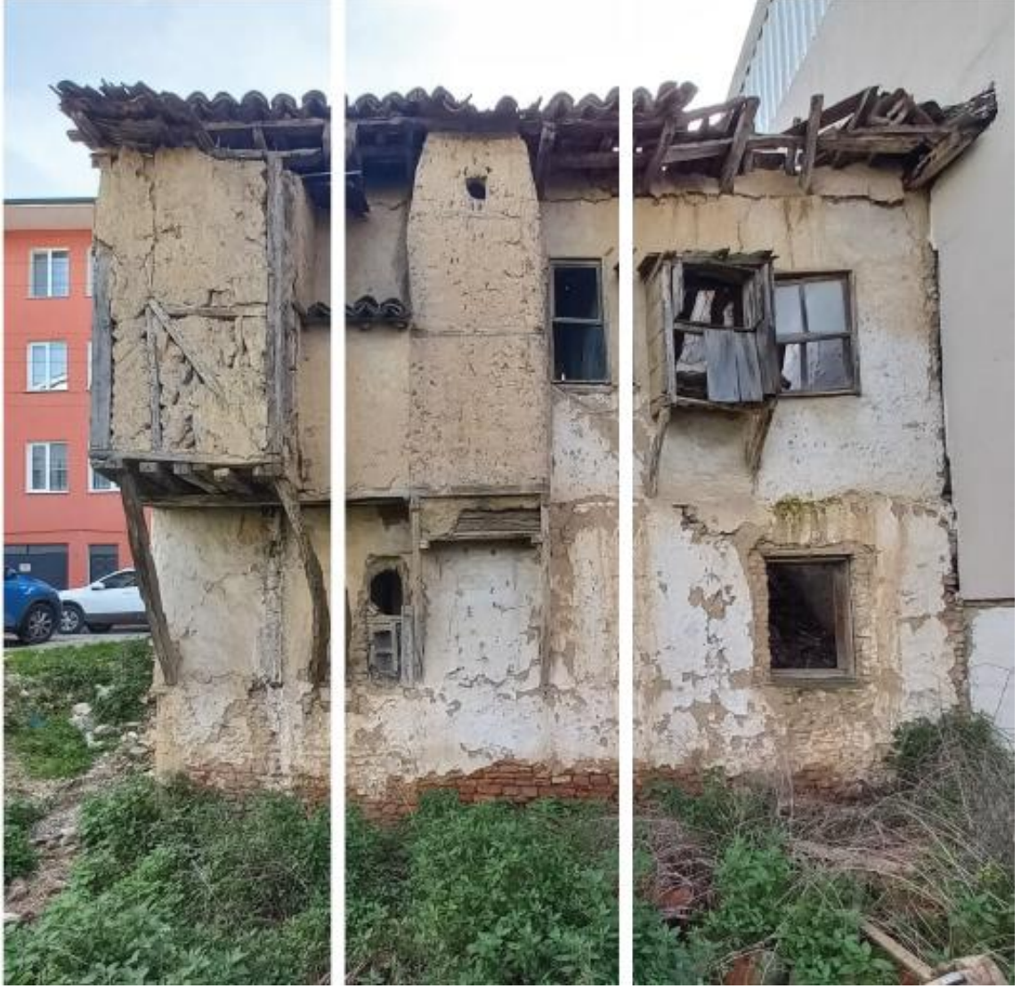
Şekil 3.18. Eşrefzade Mahallesi, 75 ada, 14 parseldeki konutun arka cephe cumbaları
