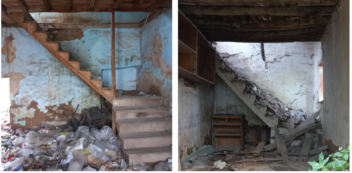
Şekil 3.24. Geleneksel İzmir konutlarında merdiven ve döşeme yarıkları
