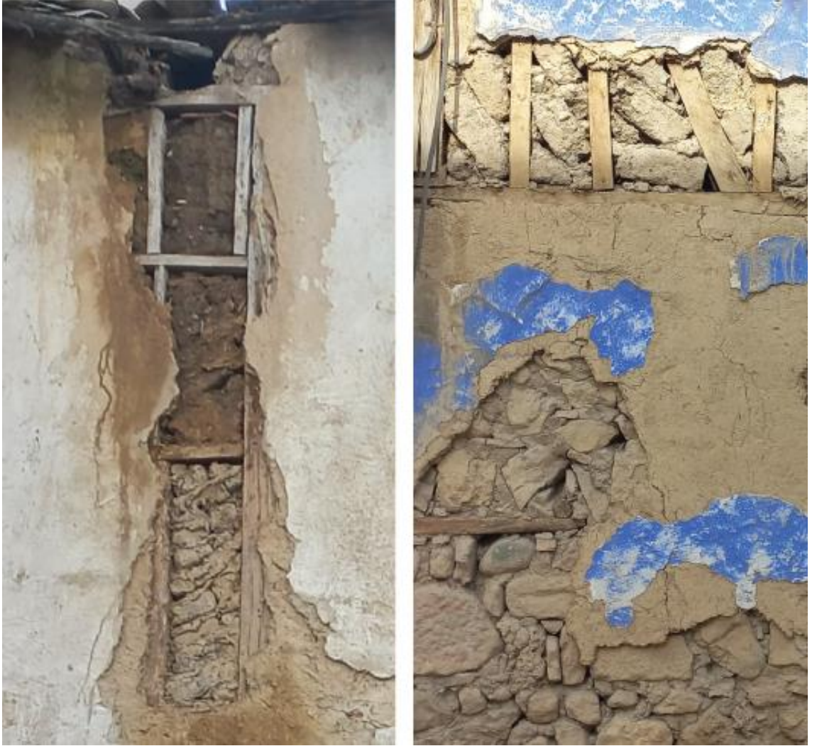
Şekil 3.11. Geleneksel İznik konutlarında ahşap malzeme kullanımı (1)
