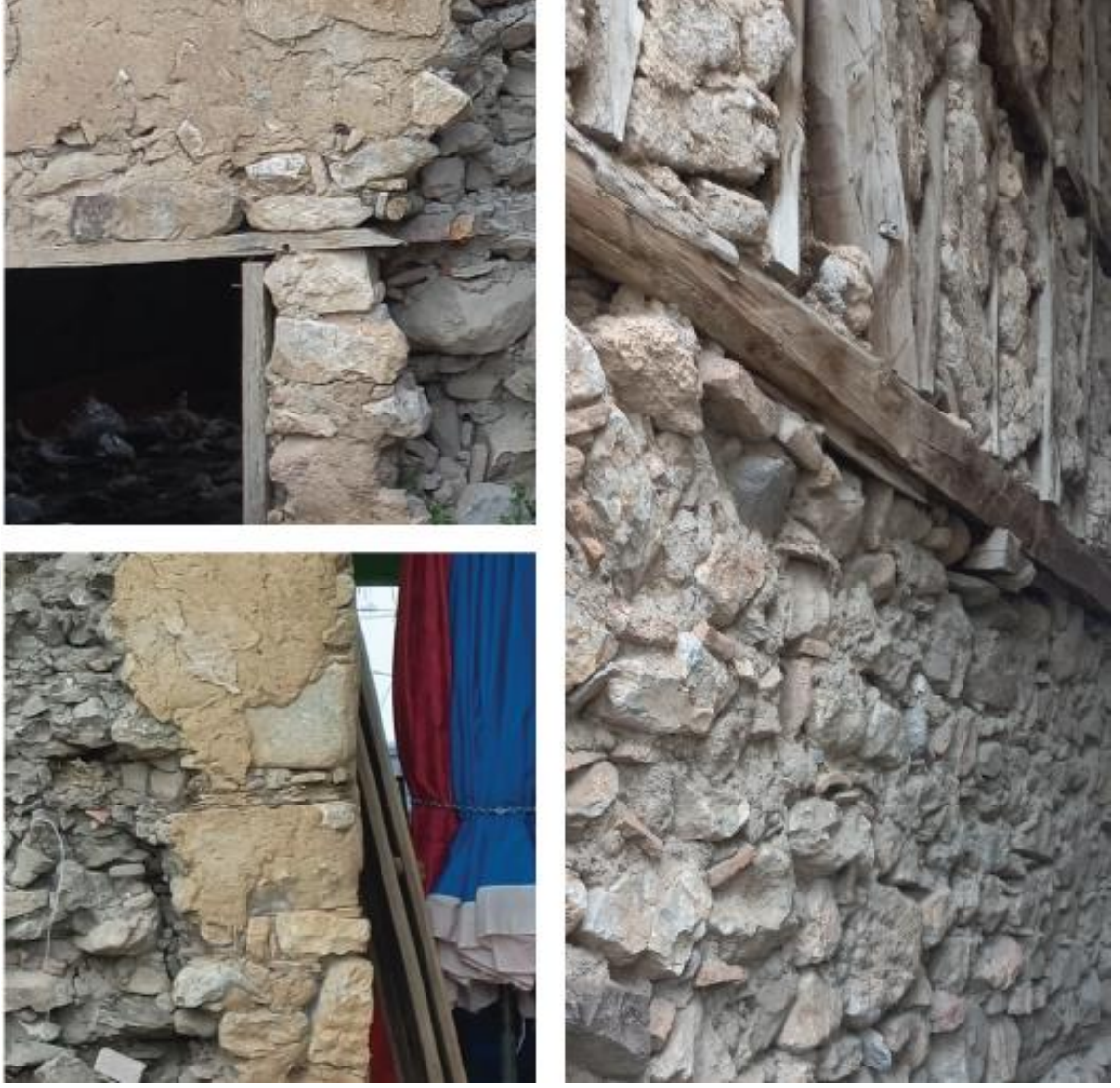
Şekil 3.10. Geleneksel İznik konutlarında moloz taş kullanımı
