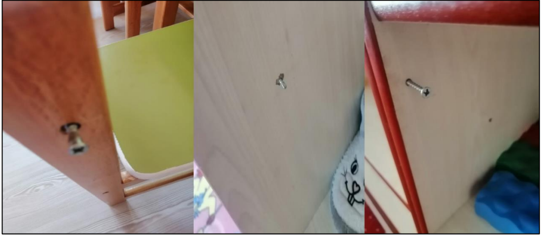
Şekil 4.16. Okul öncesi eğitim kurumlarına ait ahşap donatılarda çivi-vida bağlantı hasarları
